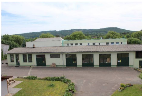
Obrázek 41 – Pohled na nové dílny 1
