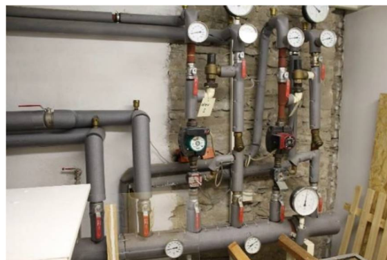
Obrázek 12 - R+S pr ÚT – část II
