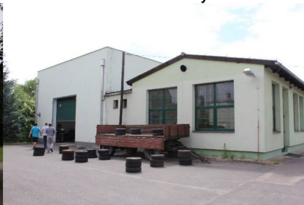
Obrázek 44 - Pohled na nové dílny 4
