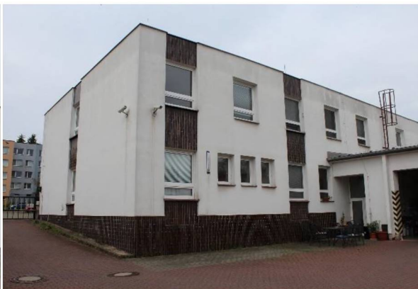
Obrázek 16 - Pohled II – hlavní budova
