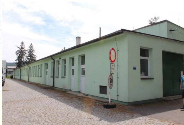
Obrázek 46 – Pohled na budovu starých dílen 2
