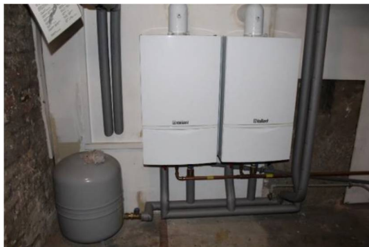
Obrázek 9 - Zdroje tepla pro ÚT - část I
