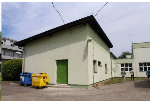
Obrázek 42 – Pohled na nové dílny 2
