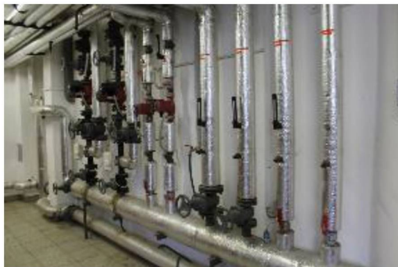
Obrázek 68 - Rozdělovač/sběrač
