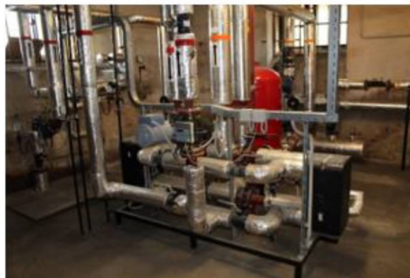
Obrázek 7 - Deskové výměníky pro ÚT
