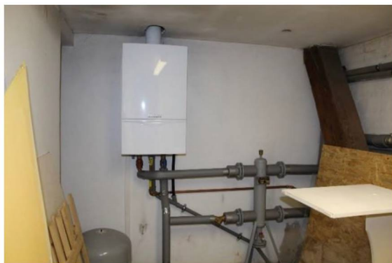
Obrázek 11 - Zdroj tepla pro ÚT – část II
