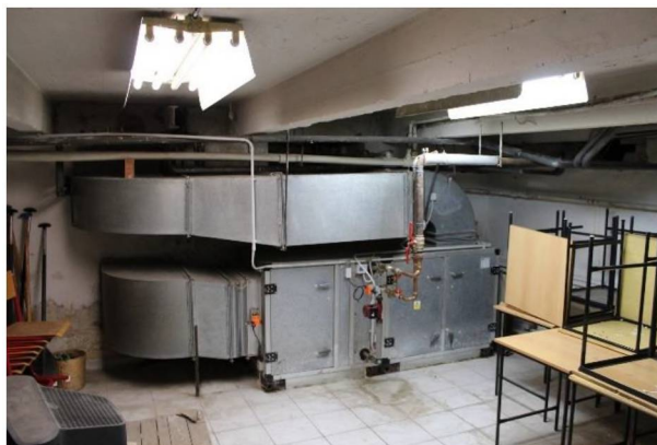
Obrázek 3 - VZT jednotka pro kuchyň
