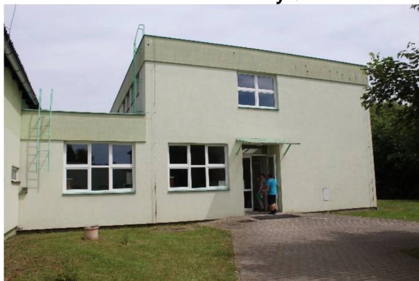
Obrázek 43 – Pohled na nové dílny 3
