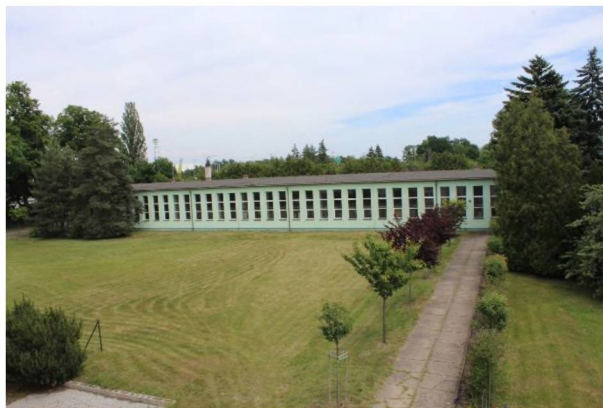
Obrázek 45 - Pohled na budovu starých dílen 1
