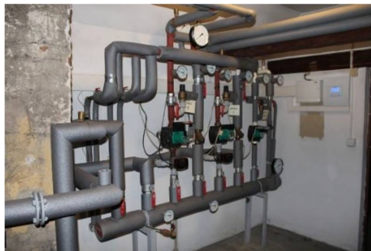
Obrázek 10 - R+S pro ÚT - část I
