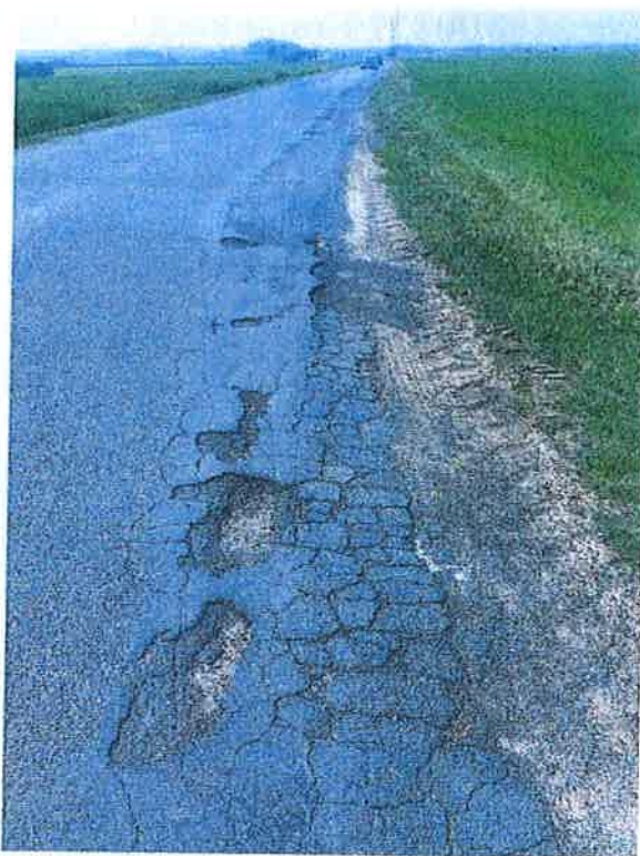
Obr.3 a Obr.4 – Výtluky a trhliny ve vozovce
