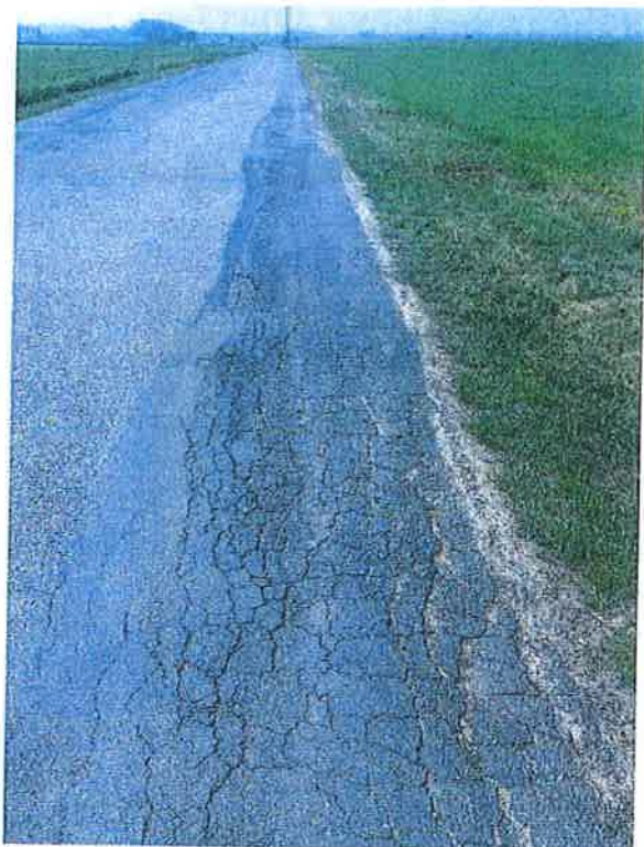
Obr.3 a Obr.4 – Výtluky a trhliny ve vozovce
