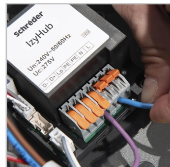
Modul IzyHub odolný proti chybám při instalaci usnadňuje elektrické připojení při instalaci a během údržby.
