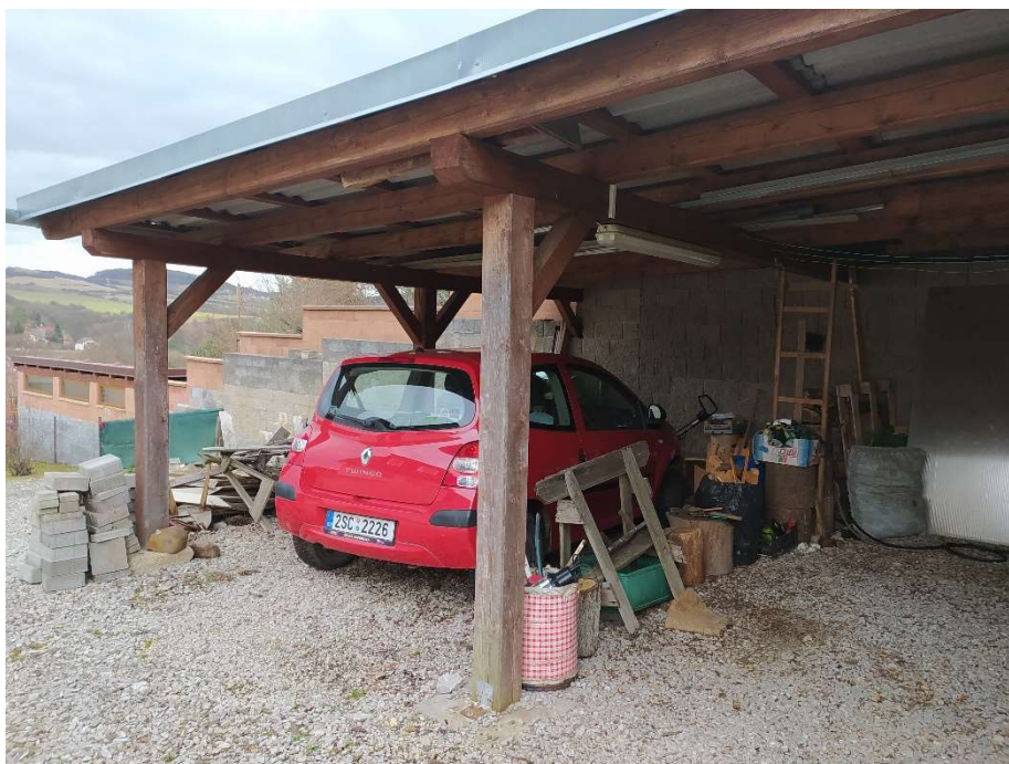
zastřešení parkovacích míst
