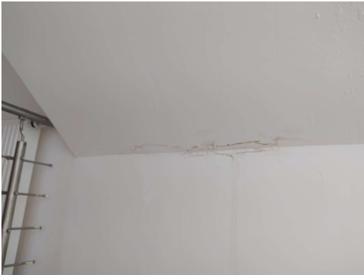
m. č. 2.01 nad schodištěm
