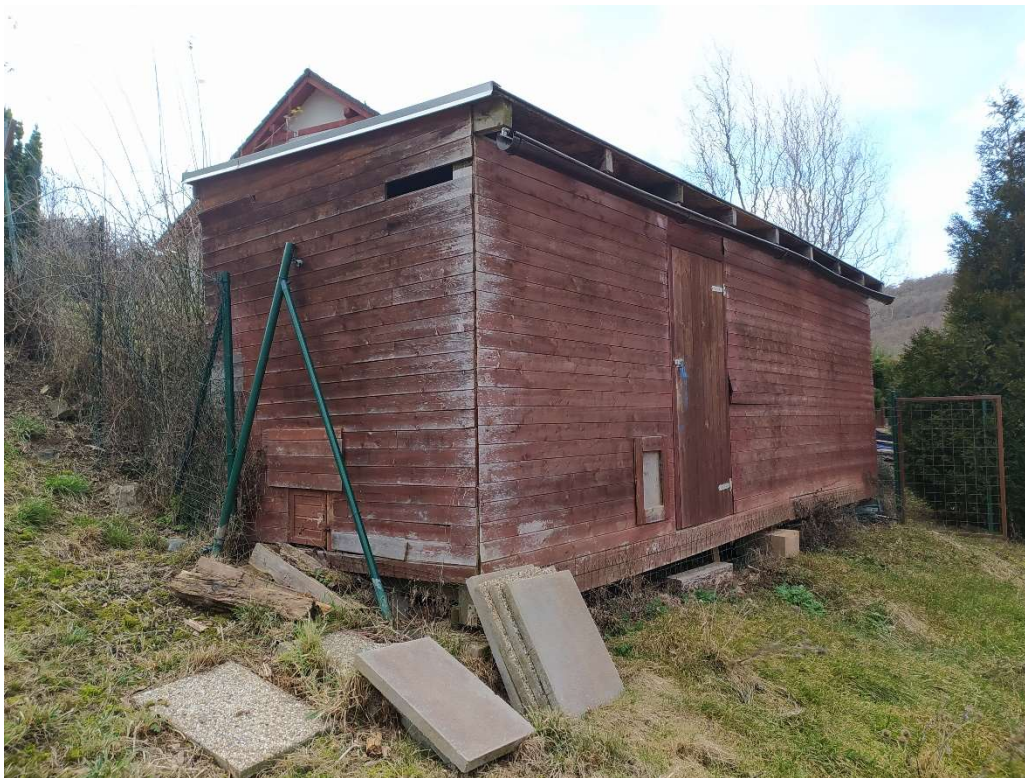
dřevěný sklad s kurníkem
