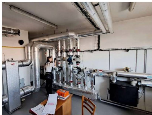
Rozdělovač/sběrač, topné větve, výměník tepla pro TV
