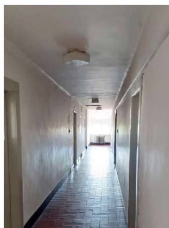
Osvětlení na chodbě
