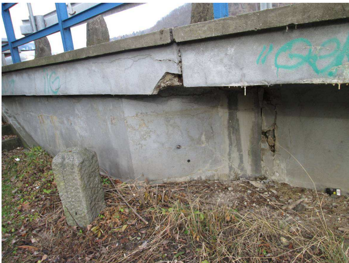
Pravé křídlo OP1. Trhliny, výluhy, rozpad betonu.
