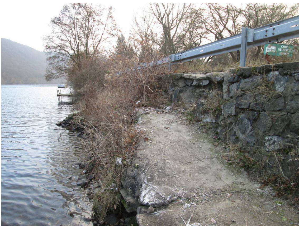
Navazující zídka za L křídlem OP2. Vypadané spárování a zdivo, lokálně až rozpad zídky.
