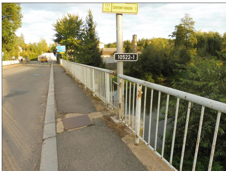
Okraj mostu vpravo.
