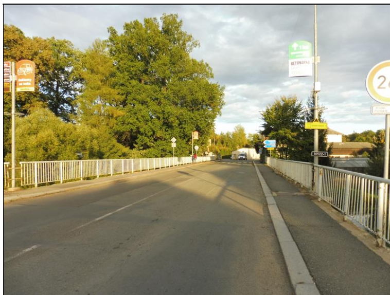
Pohled na most ve směru staničení.
