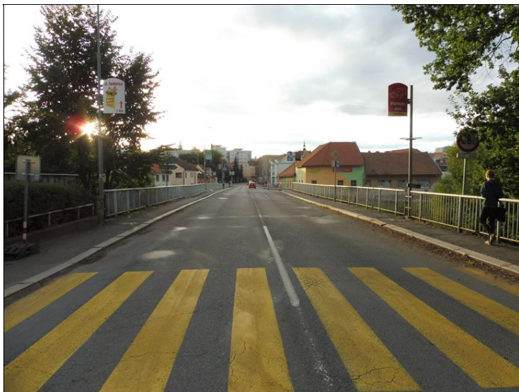
Pohled na most proti směru staničení.
