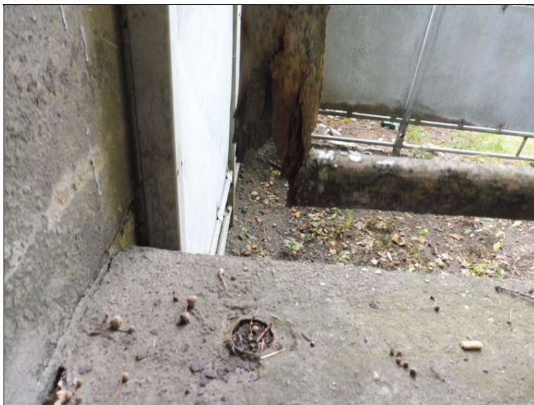
Zábradlí na schodišti u OP4L.
