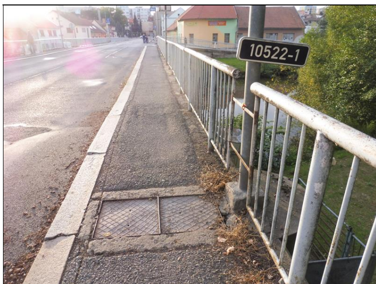
Okraj mostu vlevo (proti směru staničení).
