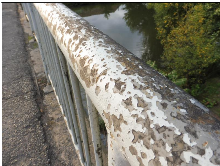
Zábradlí v L.
