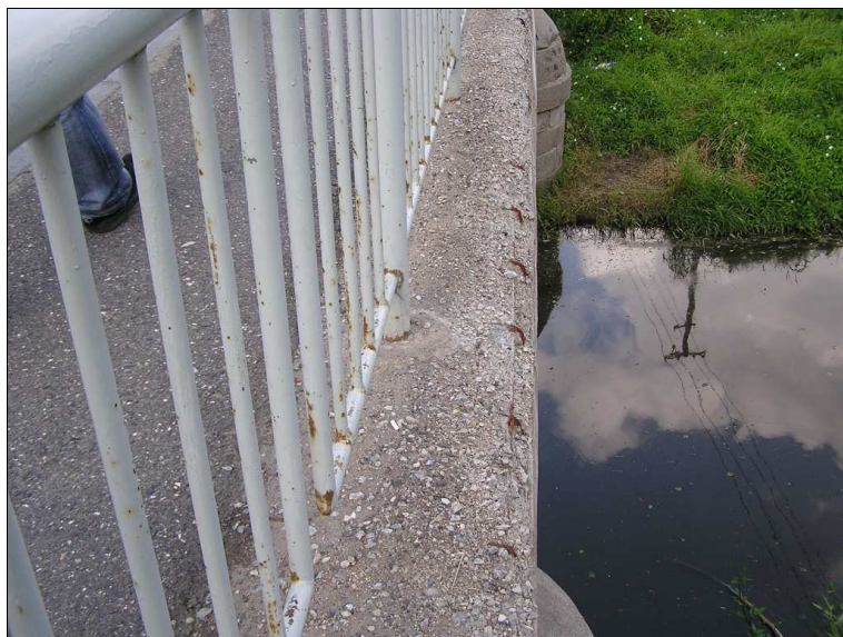
Koroze obnažené výztuže říms.
