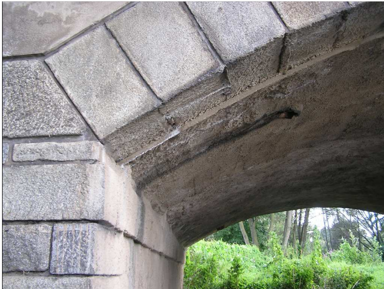
Voda vytékající z odvodňovače přímo na spodní líc klenbového pasu.
