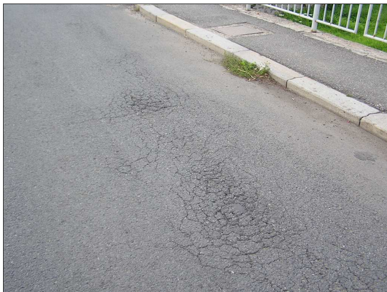
Rozpraskaný kryt vozovky.
