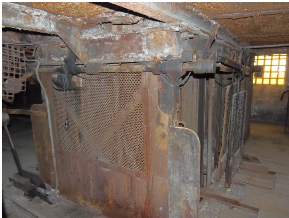
Obr. č. 2: Příčníky věže z profilů U nesoucí mj. i nosníky plošiny.
