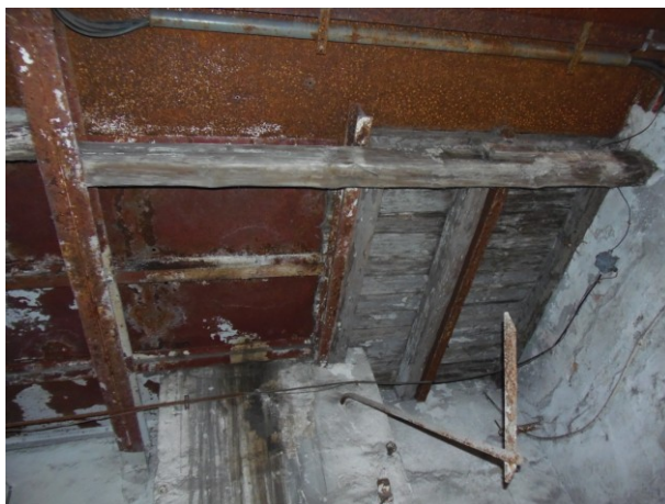
Obr. č. 8: Otvary ve stropu 1NP zakryté dřevěnými záklopy (vpravo oc. výměna na dřev. trámu).
