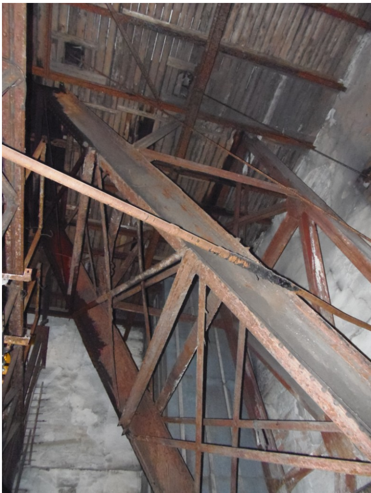
Obr. č. 3: Vzpěra - v popředí původní, v zadu dodatečně přidaná při zvyšování.
