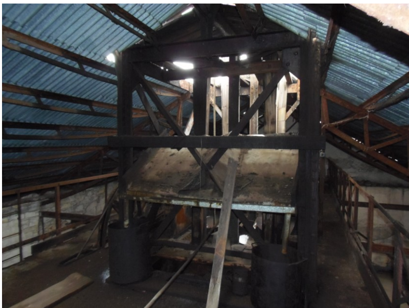
Obr. č. 5: Navýšená část věže hlavního těžního oddělení pod střechou.
