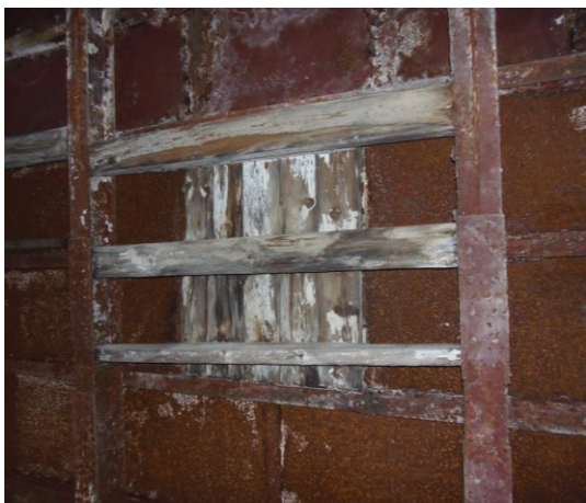
Obr. č. 8: Otvary ve stropu 1NP zakryté dřevěnými záklopy (vpravo oc. výměna na dřev. trámu).
