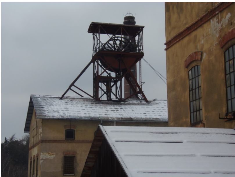
Obr. č. 6: Navýšená část těžní věže nad střechou.
