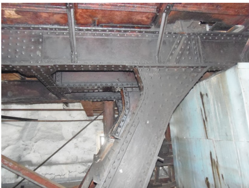
Obr. č. 4: Styčnick na úrovni +367,19. Je patrné silné znečištění mazadly.
