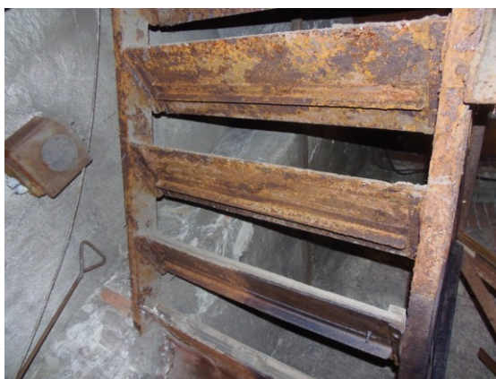
Obr. č. 9: Mezipodesta schodiště 1NP (po pokusu s povrch.úpravou tanátováním).
