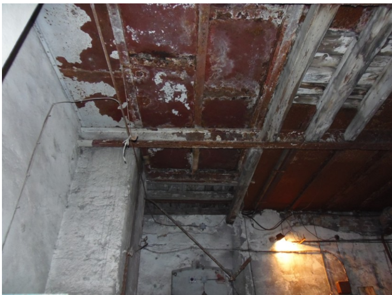
Obr. č. 7: Zatékání a koroze u severní stěny.
