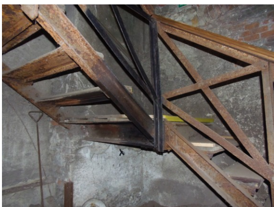
Obr. č. 9: Mezipodesta schodiště 1NP (po pokusu s povrch.úpravou tanátováním).
