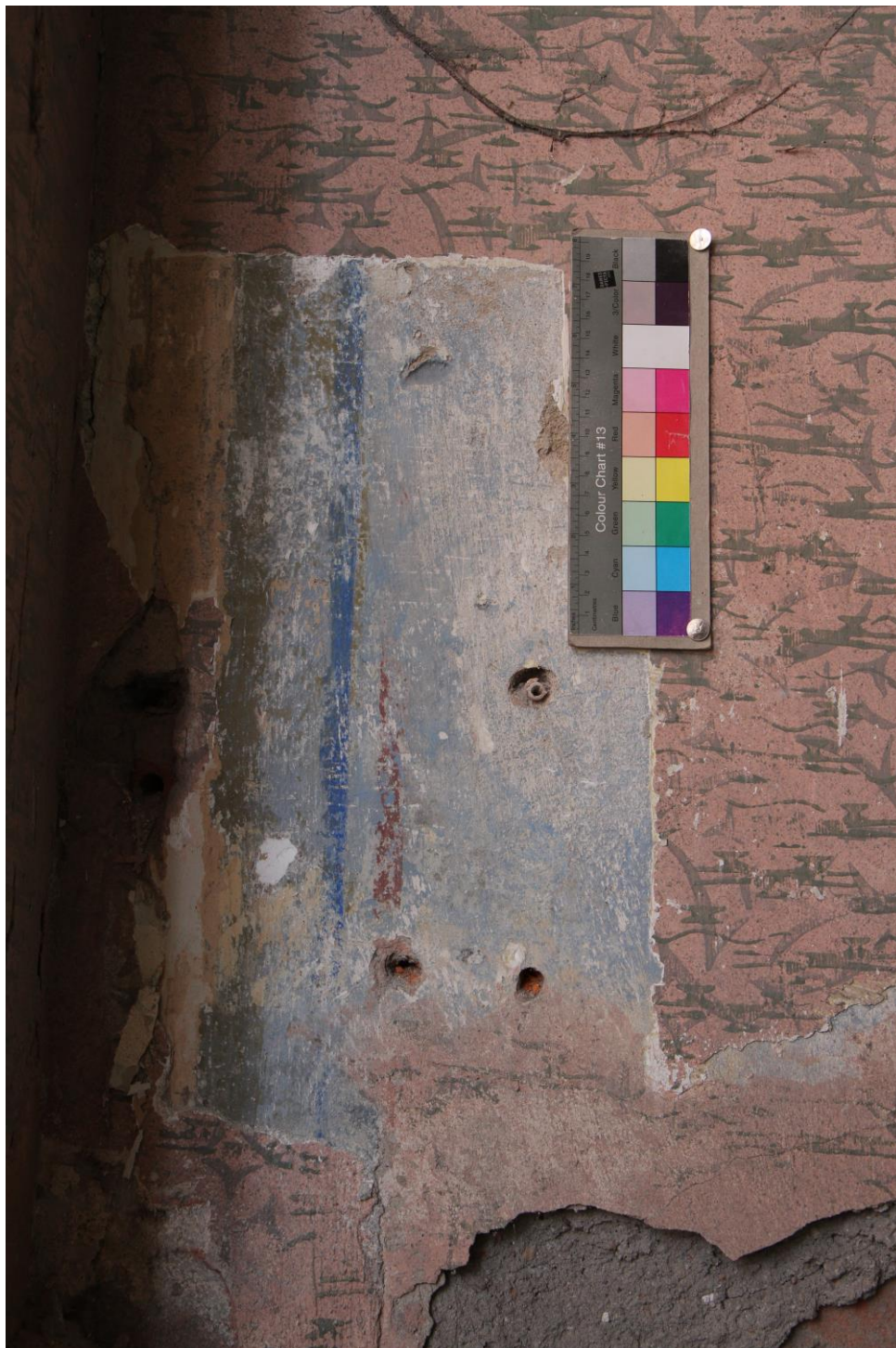
Sonda M2-S3 na stěně v rohu místnosti, provedená v nejstarší nalezené vrstvě – modrá plocha ohraničená zeleným pásem a modrou a hnědo - červenou linkou
