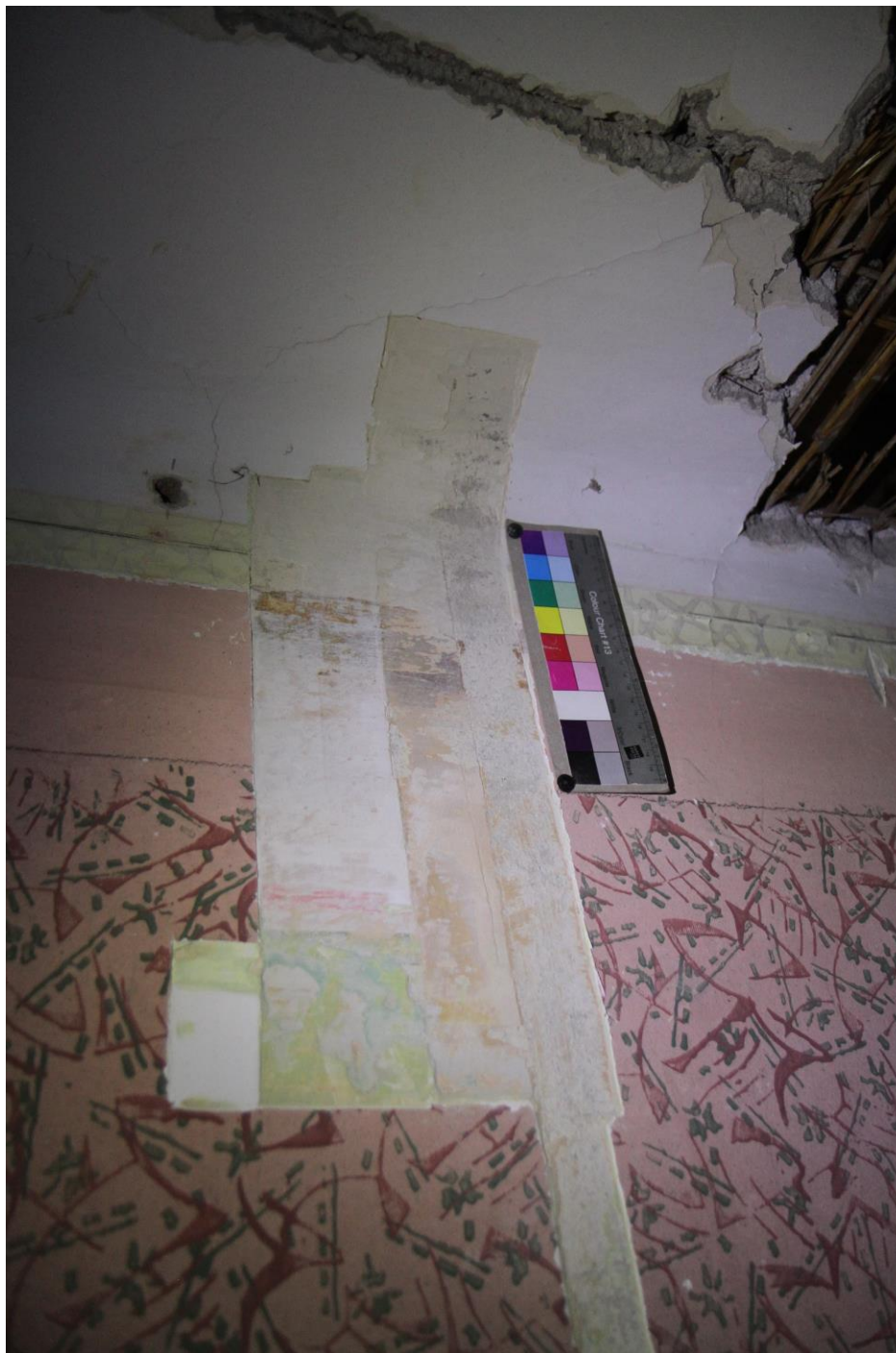
Sonda M1-S2 ve fabionu mezi stropem a stěnou: M1-S1: 0+1 – omítka s fragmenty šedé, 2 – sytě okrová s širším šedým pásem a užším okrovým pod fabionem, 3 – bílá plocha s červenou linkou pod fabionem a fragmenty dekoru, 4 + 5 + 6 – souvrství modré, zelené a žluté, 7 – bílý podklad pod současným dekorem, 8 – současná výmalba (po natáčení filmu)
