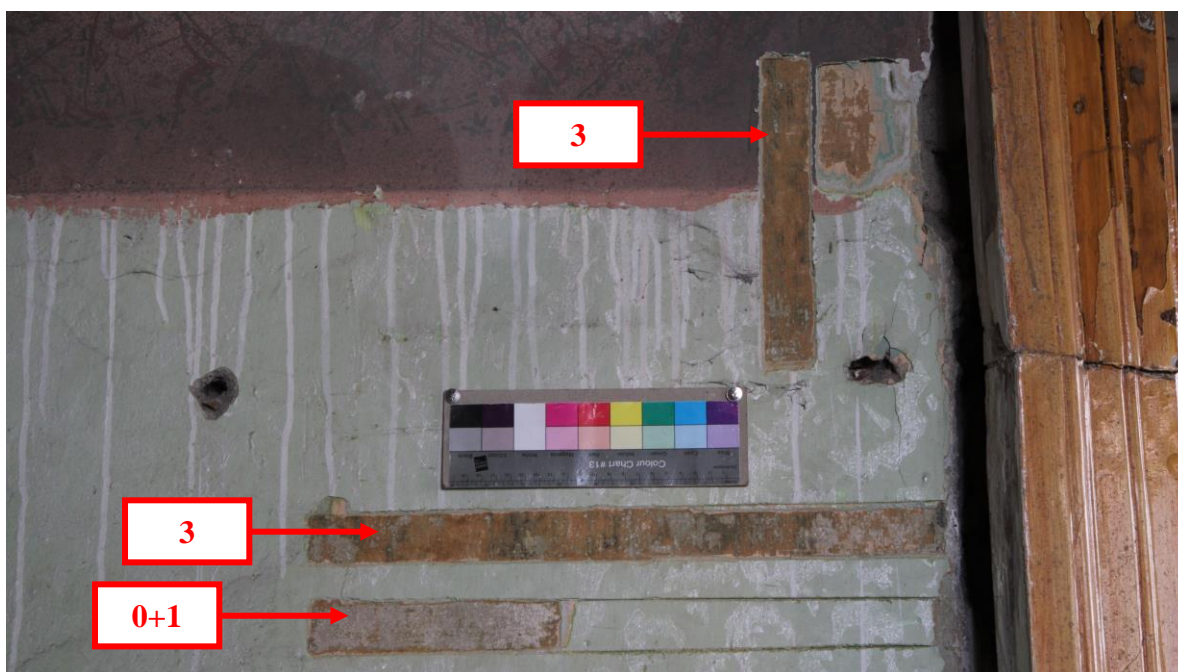
Sonda S1M5 v ploše stěny vedle dveří: Pásové sondy provedené ve vrstvě č. 1 a 3
