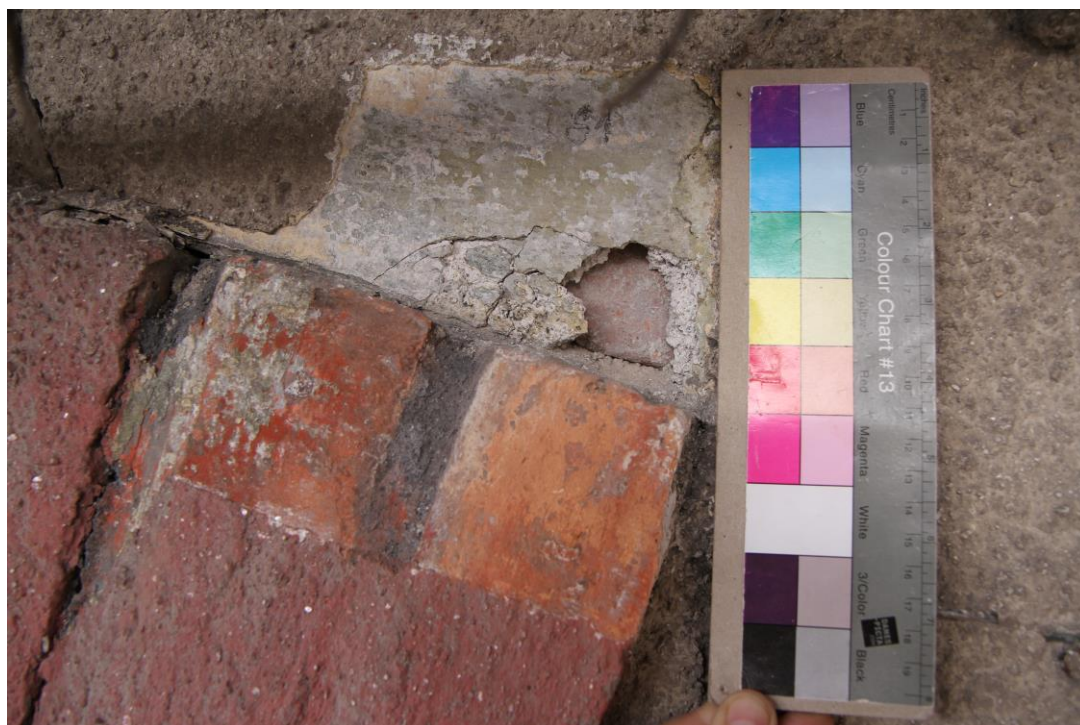
Sonda F-S1 na záklenku původního okna a v ploše stěny nad ním
