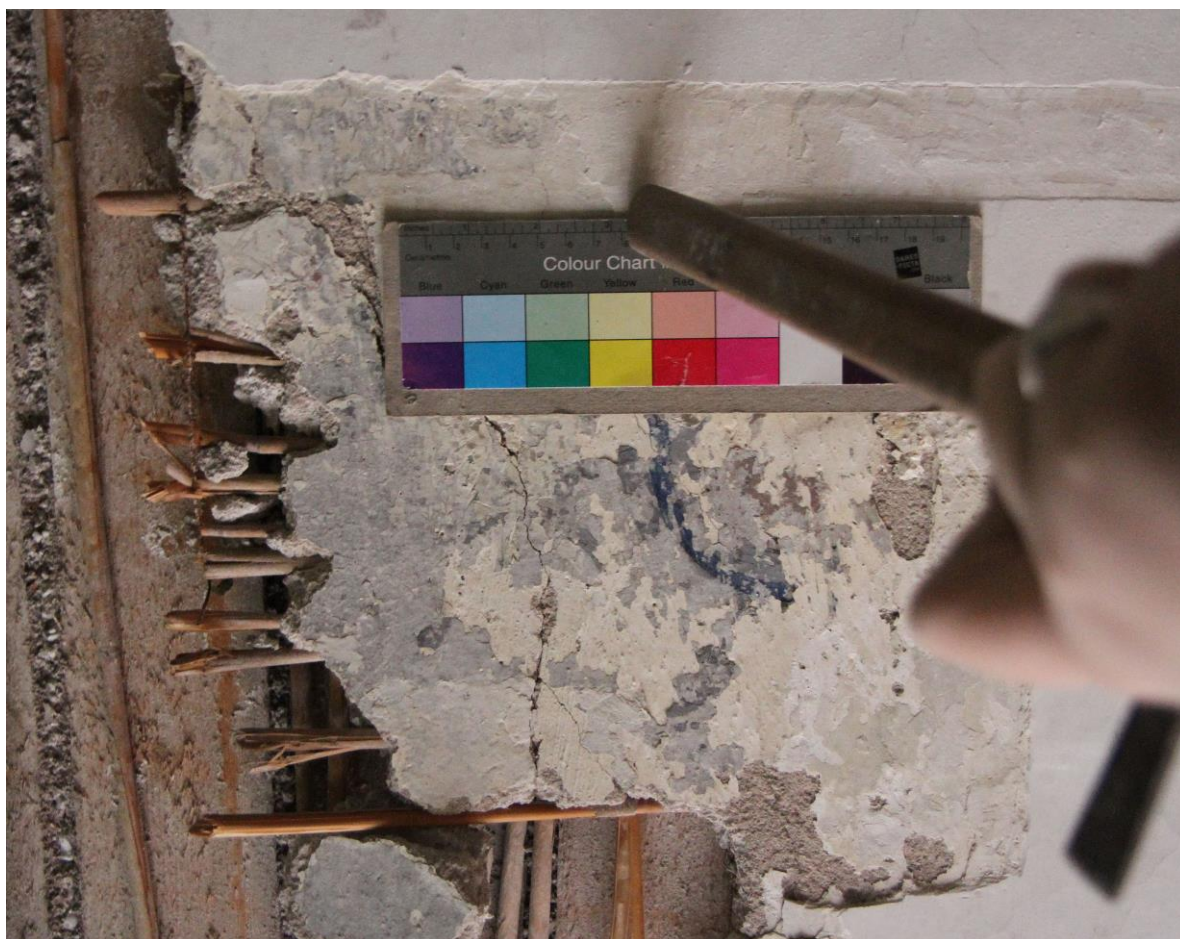
Sonda M2-S5 - fragment rozety, nalezené na stropě v nejstarší barevné vrstvě
