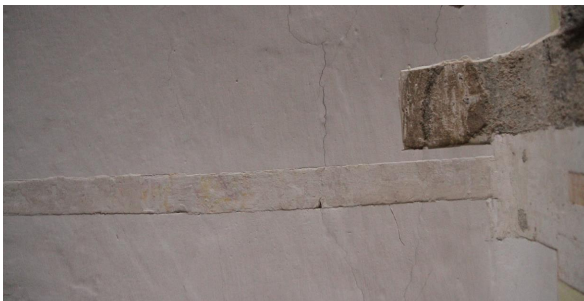
Pásová sonda M2-S5 provedená ve vrstvě č. 2 v lomeně bílém odstínu s fragmenty výzdoby
