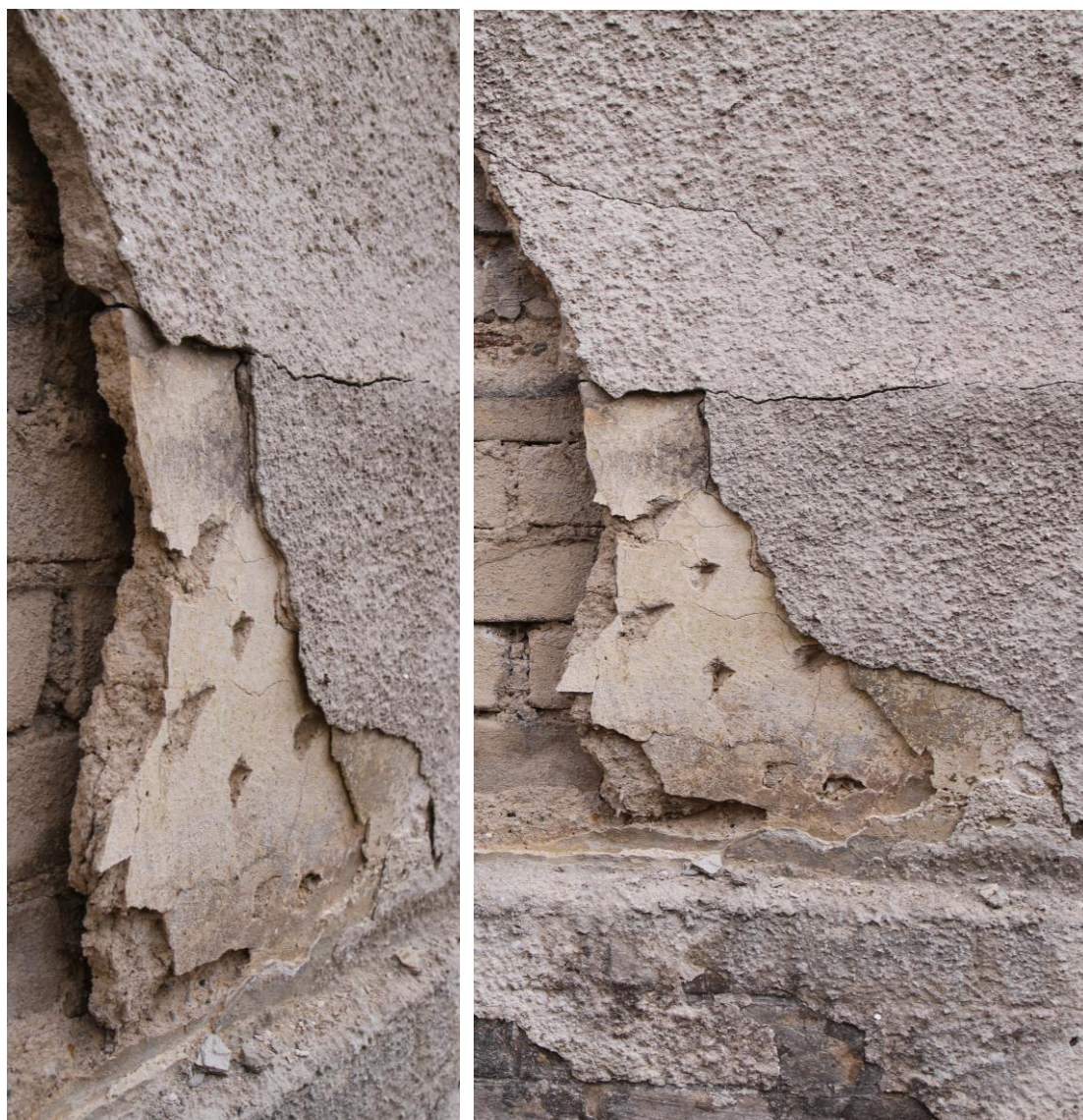
Sonda F – S8 nad soklem fasády - detail odhalené pekované omítky ve vrstvě č. 0+1 v sondě F-S5
