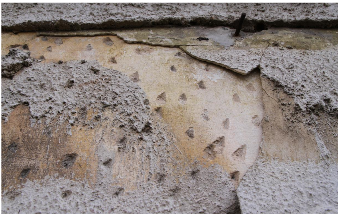
Sonda F – S6 pod kordonovou římsou - detail odhalené pekované omítky ve vrstvě č. 0+1 v sondě F-S5
