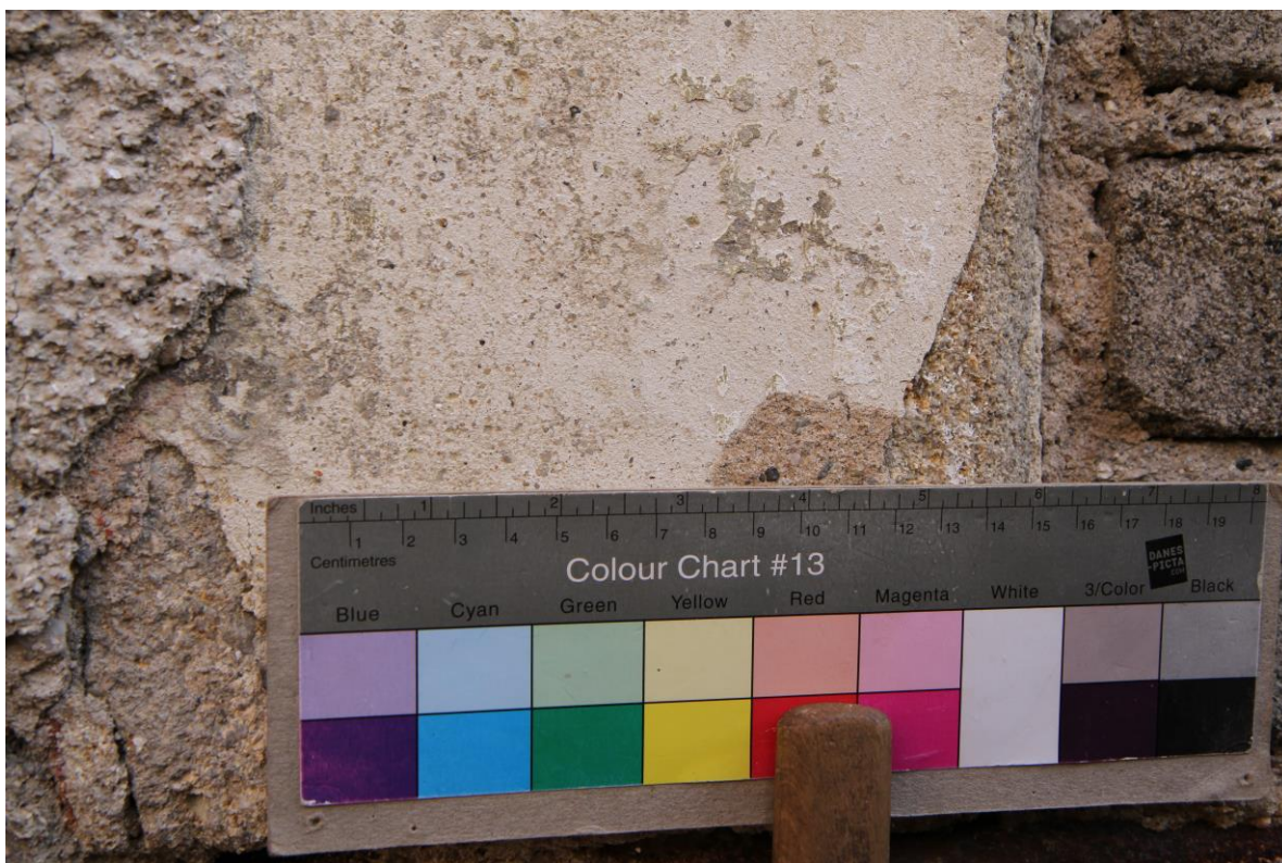
sonda F – S6 – detail odhaleného kamenného ostění ve spodní části fasády
