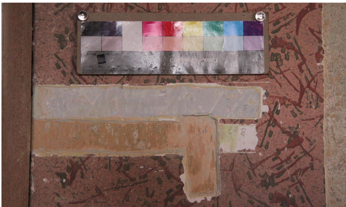
Sonda S1-M4 v ploše stěny vedle dveří, provedená ve vrstvách č. 3 (okr s fragmenty dekoru) +4 (meruňková), 5 (modrá), 6 (zelená) + 8 (bílá)
