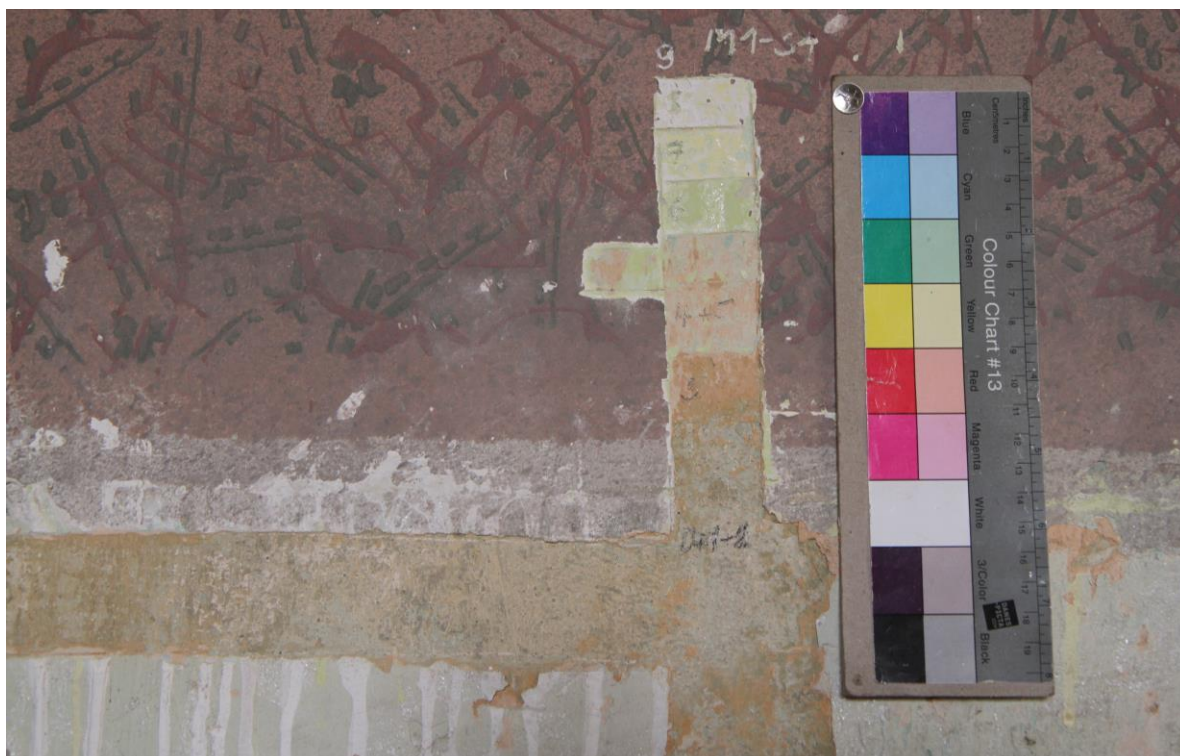
Detail sondy: M1-S1: 0+1 – omítka s fragmenty studené zelené, 2 – teplá zelená, 3 – okrový nátěr s fragmenty dekoru, 4 – meruňková, 5 – modrá výmalba, 6 – zelený nátěr, 7 – žlutý nátěr, 8 – bílý podklad pod současným dekorem, 9 – současná výmalba (po natáčení filmu)
