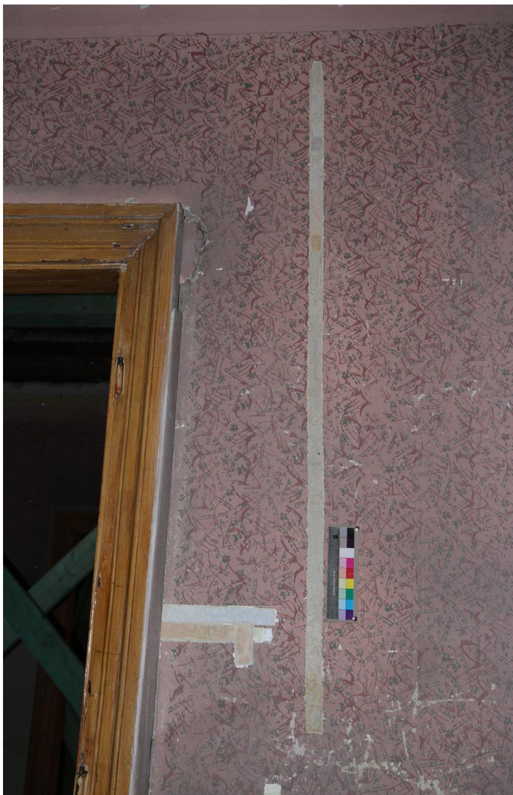
Pásová sonda M1-S3 v nejstarší nalezené vrstvě
