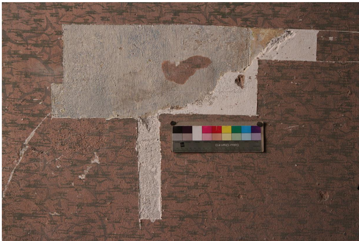
Sonda M2 – S2 v ploše stěny vedle dveří, provedená v nejstarší nalezené modré vrstvě (vpravo viditelná mladší vysrávka bílé barvy)
