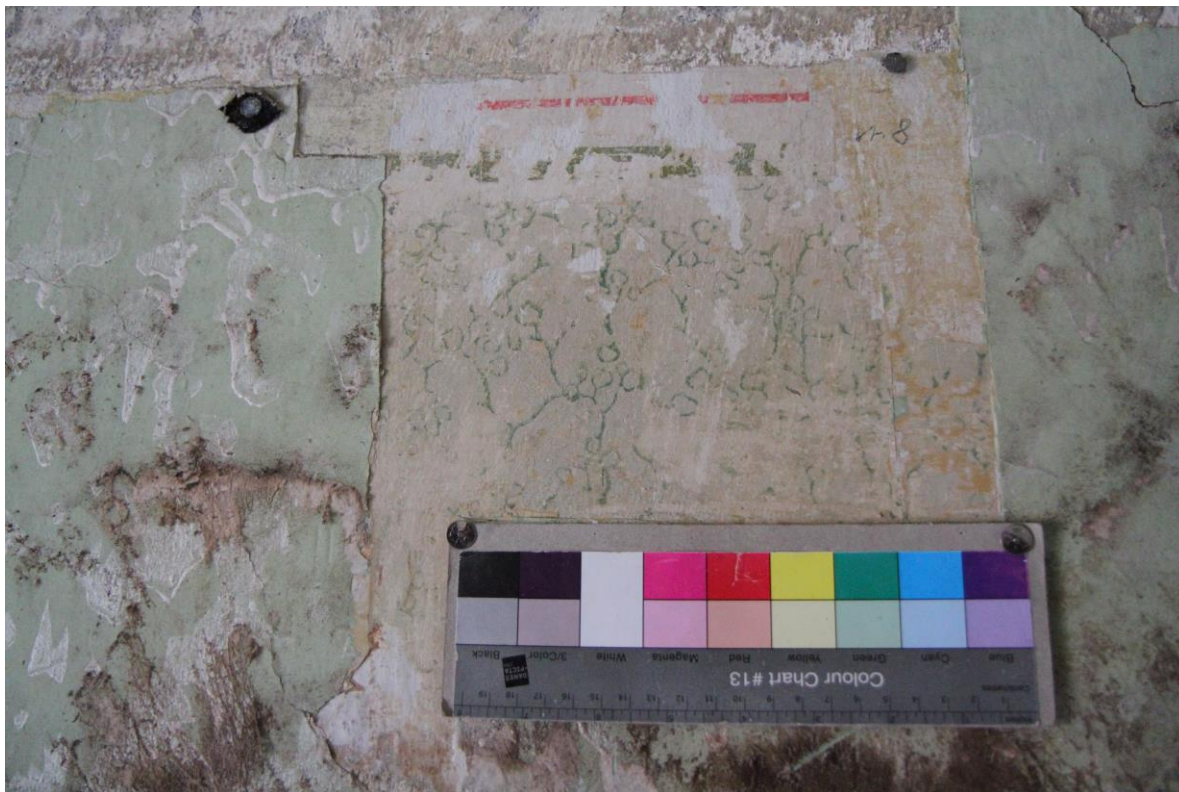
Detail sondy M3-S4, vrstva č. 8 dle číslování sondy M3 – S1 – zelený dekor na světle zeleném podkladu, pod fabionem zakončený zelenou a červenou linkou
