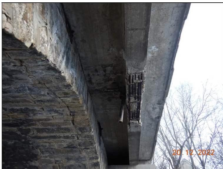
Betonové rozšíření 5. pole, pohled zprava. Koroze obnažené výztuže podélného trámu i desky. Podélná trhлина v klenbě.
