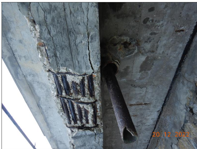
Betonové rozšíření 1. pole, pohled zleva. Koroze obnažené výztuže podélného trámu i desky.
