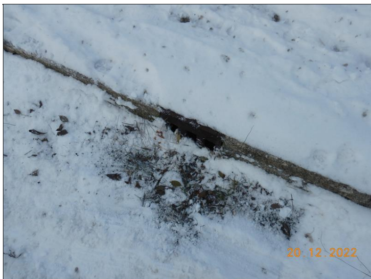
Zanesený odvodňovač.
