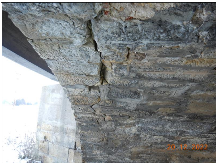
Podélná trhlina v klenbě 1. pole zleva.
