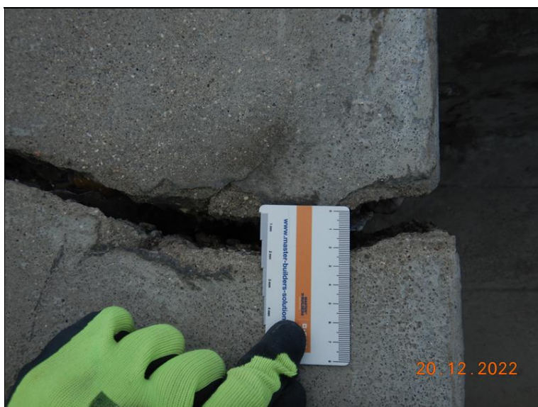
Otevřená spára v pravém křídle OP1, detail.
