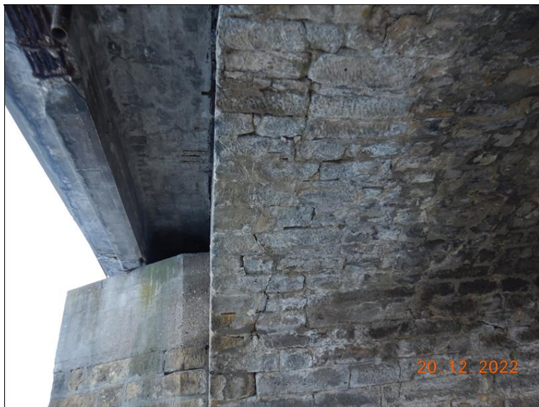
Podélná trhlina v klenbě 3. pole zleva.
