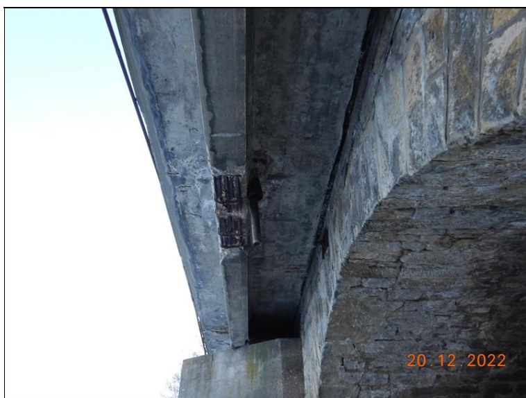
Betonové rozšíření 4. pole, pohled zleva. Koroze obnažené výztuže podélného trámu i desky.
