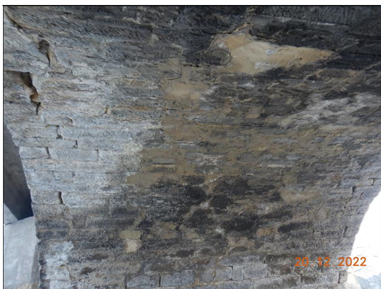
Podélná trhlina a rozpad kamenných kvádrů v klenbě 2. pole zleva. Stopy po sanacích spárovacího materiálu i kamenných kvádrů. Stopy po zatékání, výkvěty.
