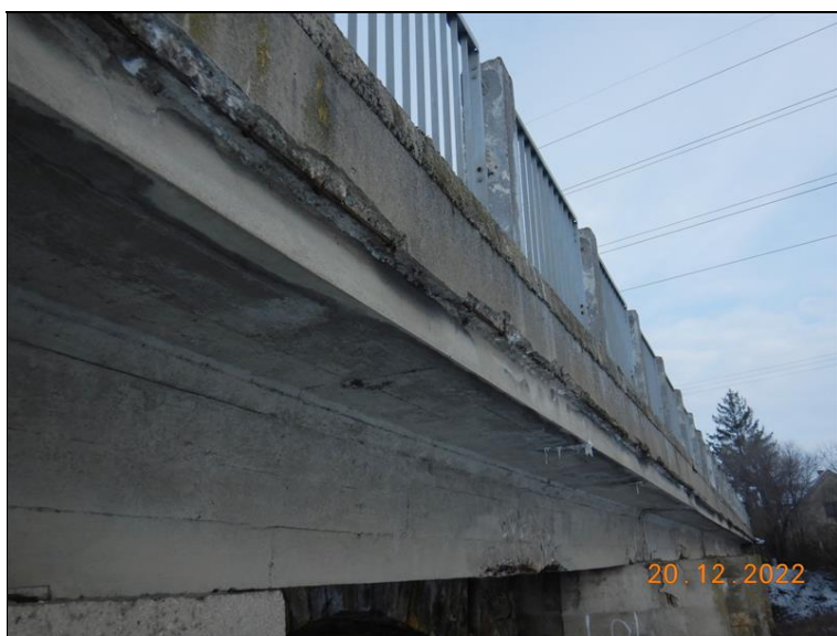
Koroze obnažené výztuže římsy v 1. poli.
