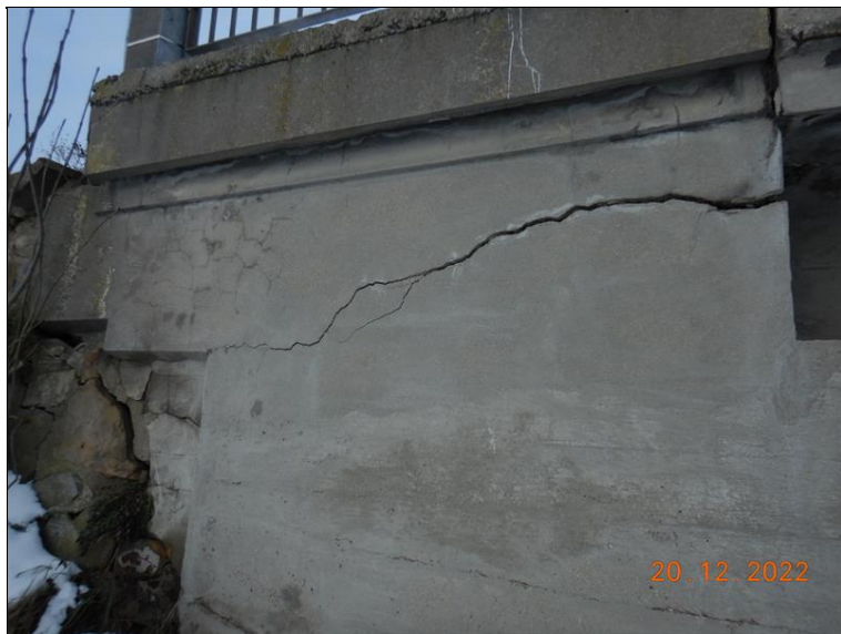
Otevřená spára v pravém křídle OP1.
