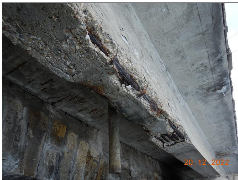
Betonové rozšíření 1. pole, pohled zprava. Koroze obnažené výztuže podélného trámu i desky.
