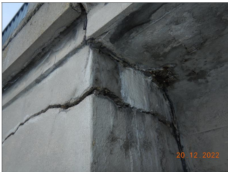
Průsaky dilatační spárou na OP1.
