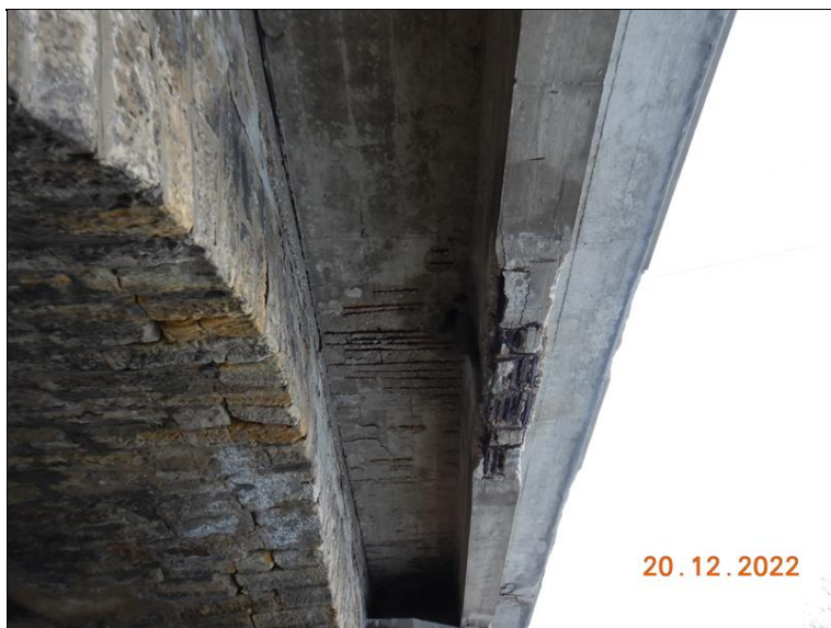
Betonové rozšíření 2. pole, pohled zprava. Koroze obnažené výztuže podélného trámu i desky. Podélná trhlina v klenbě.
