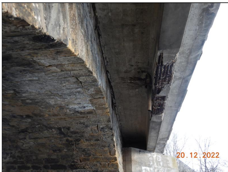
Betonové rozšíření 4. pole, pohled zprava. Koroze obnažené výztuže podélného trámu i desky. Podélná trhlina v klenbě.
