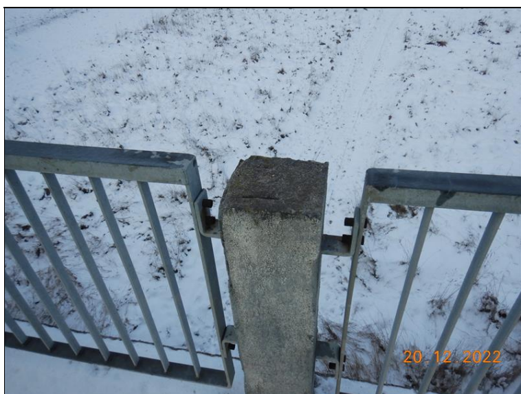
Chybí nadbetonávka hlavy sloupku.
