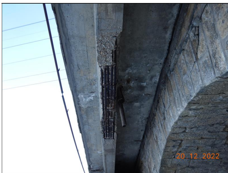
Betonové rozšíření 3. pole, pohled zleva. Koroze obnažené výztuže podélného trámu i desky.
