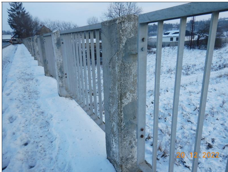
Trhliny ve sloupku zábradlí.
