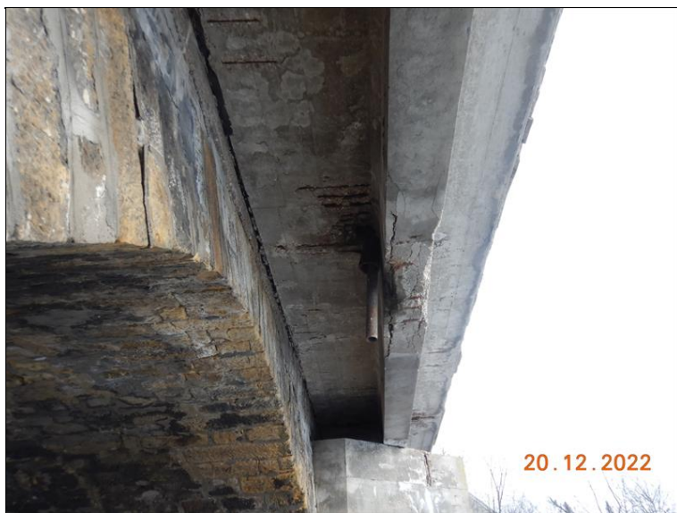
Betonové rozšíření 3. pole, pohled zprava. Koroze obnažené výztuže podélného trámu i desky. Podélná trhлина v klenbě.
