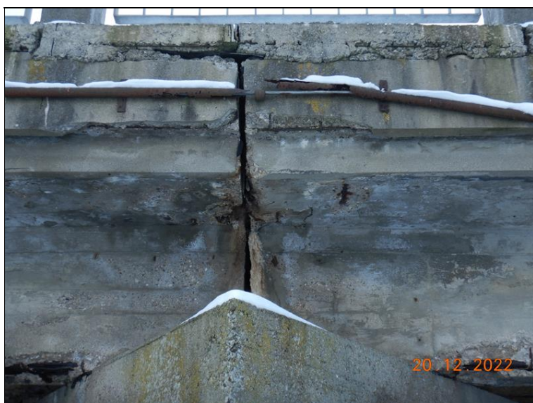
Uložení betonového rozšíření na P2. Drcení betonu, koroze obnažené výztuže. Zatékání spárou.
