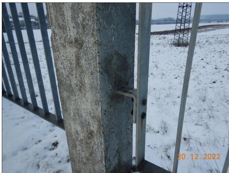
Koroze spojovacího materiálu.
