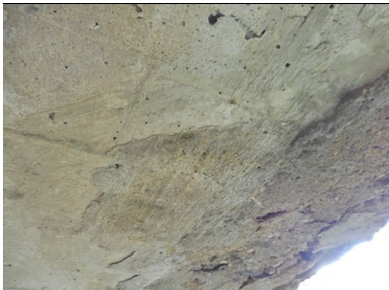
Zatékání na okraji NK.
