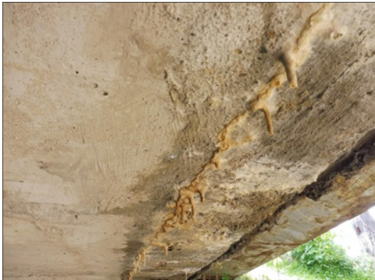
Zatékání na okraji NK.
