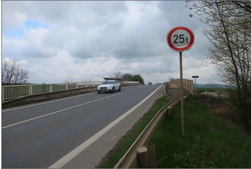
stávající SDZ omezující zatížitelnost na mostě
