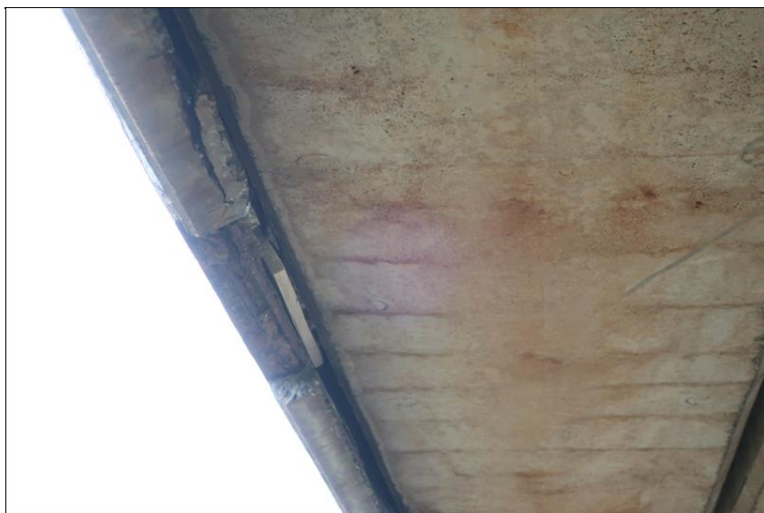
separace krycí vrstvy na spodním lici římsového prefabrikátu
