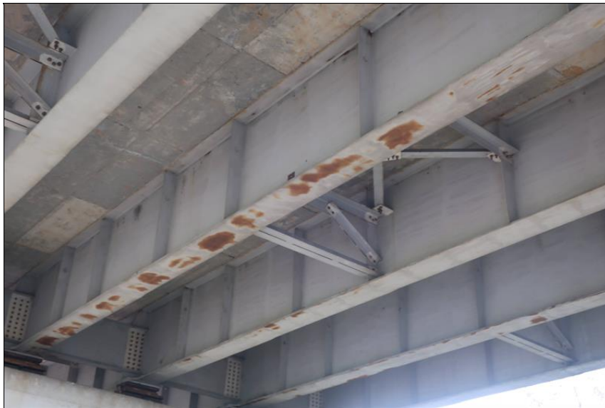
koroze spodní pásnice nosníku v 1. poli
