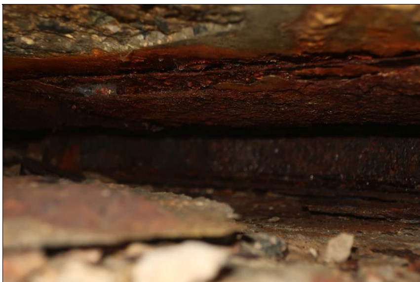
intenzivní koroze úložné kolejnice na O4 aktivní průsaky se stopami koroze na spodním líci nosníku nad O4
