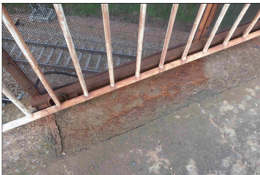
koroze horizontálního štítu protidotykové zábrany
