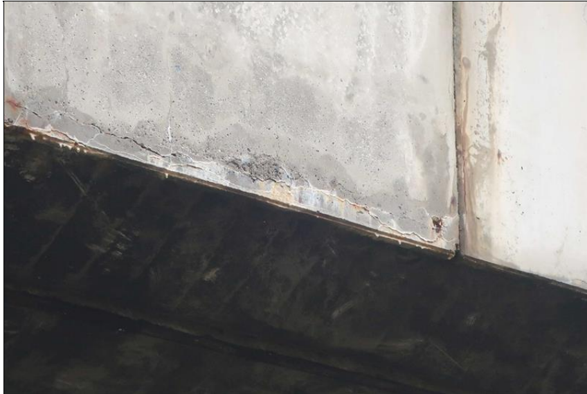
trhliny s výluhy pojiva na spodním líci římsového přefabrikátu
