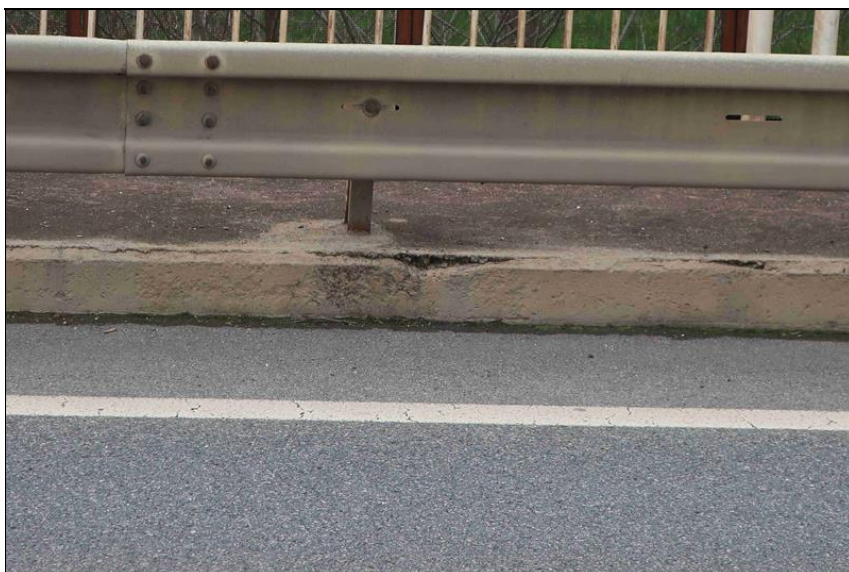
degradace betonu pravého chodníku
