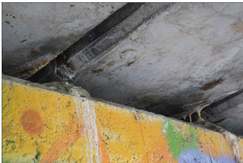
průsaky s výluhy pojiva sparami mezi nosníky nad O4
