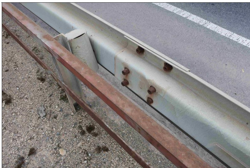
koroze šroubů svodnice a vodících úhelníků
