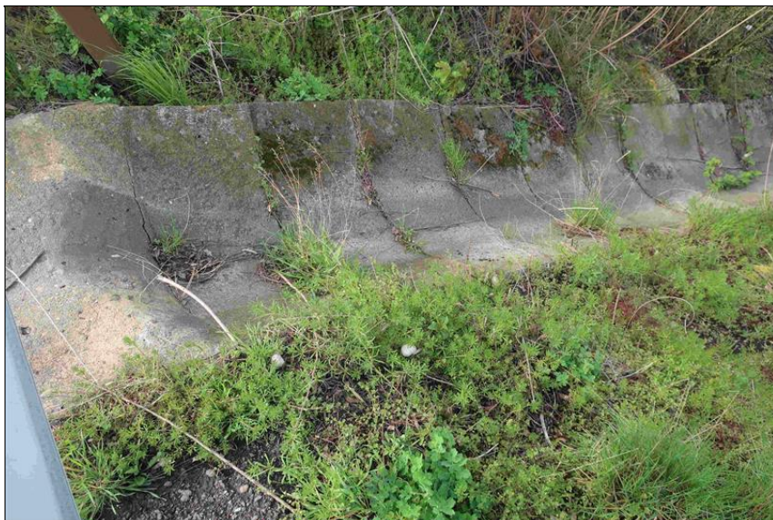
vegetace v odvodňovacím rigolu O4
