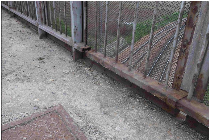
korozí dolního madla zábradlí
