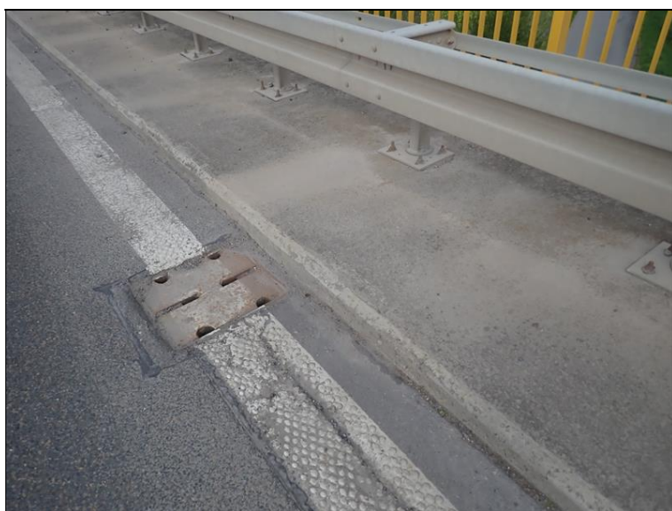
Odvodňovač na mostě.
