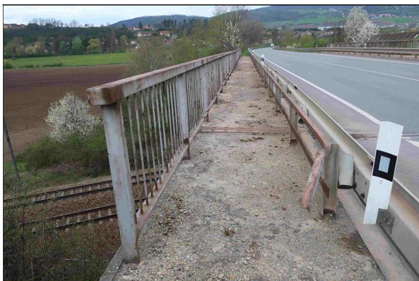
levý chodník ve směru staničení hloubková degradace betonu na horním líci chodníku
