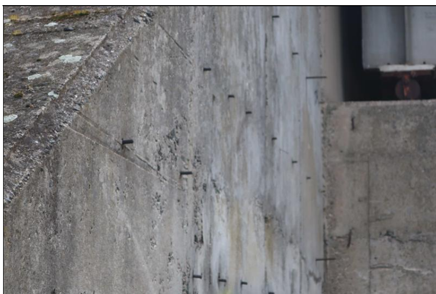
vyčnívající korodující trny z líce pravého křídla O1
