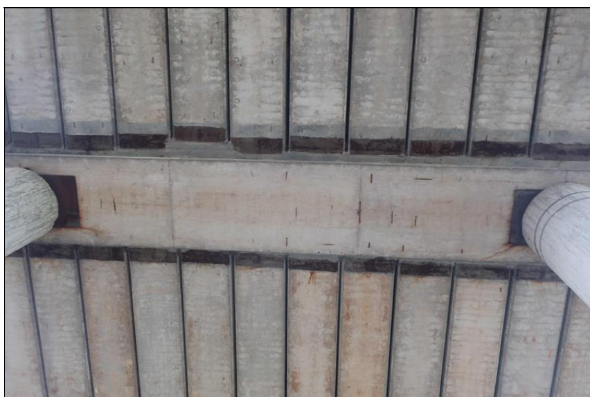
obnažená korodující výztuž na spodním líci podporového příčniku nad P3
