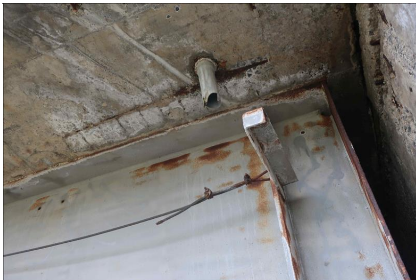
stopy po průsacích s výluhy pojiva v okolí trubky odvodnění povrchu izolace u O4
