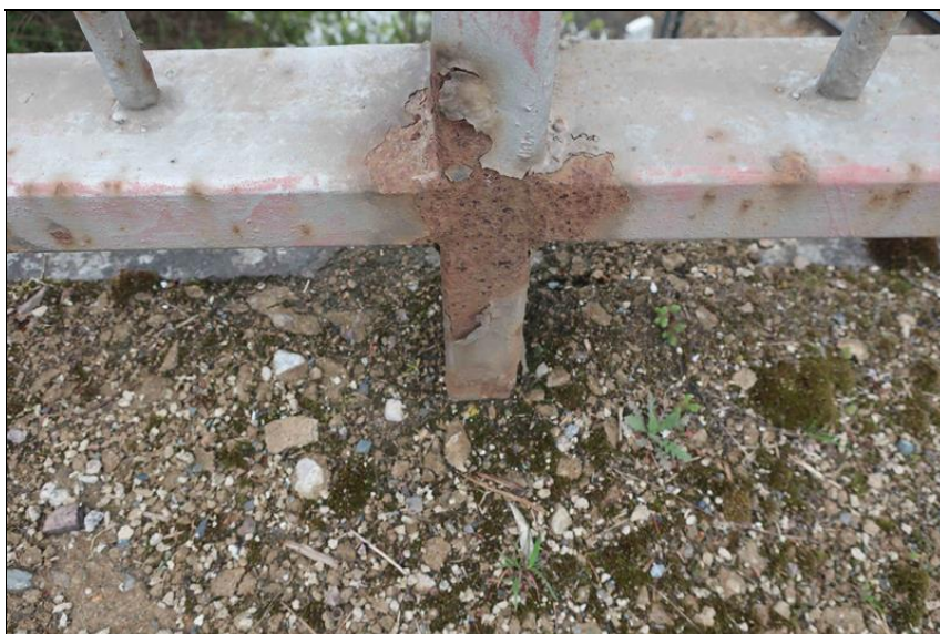
korozí sloupu zábradlí
