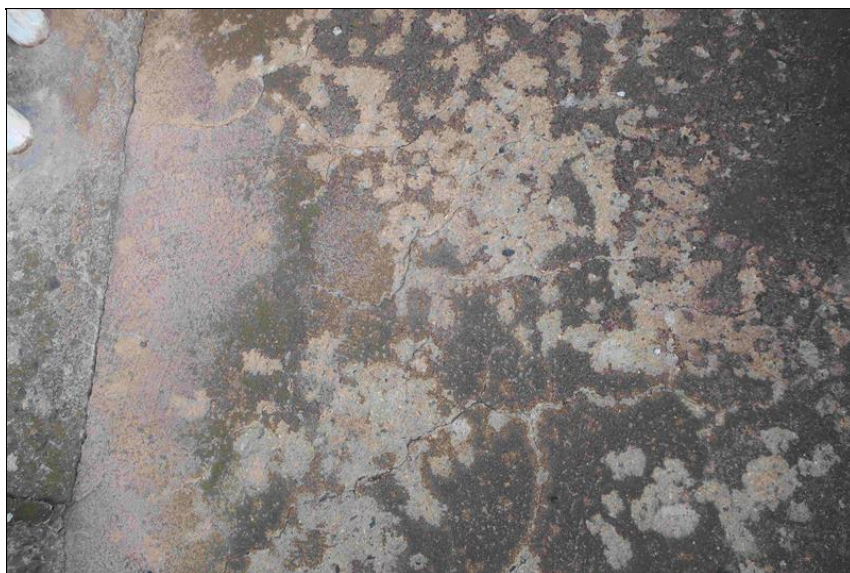
degradace povrchu betonu pravého chodníku
