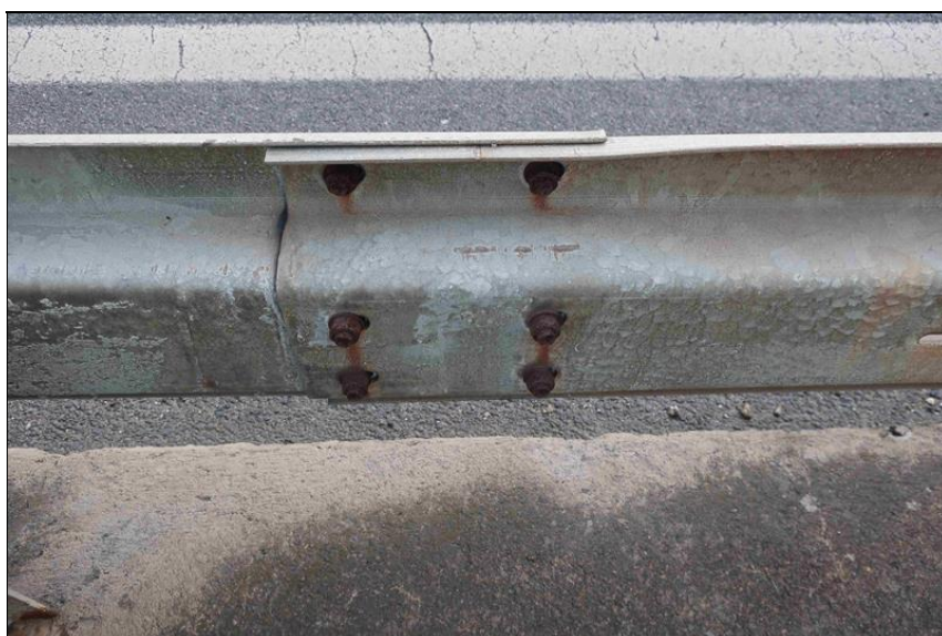
koroze spojovacích prvků svodnice
