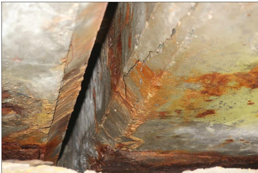
trhliny a stopy koroze v místě průsaku v hraně 2. nosníku u O4
