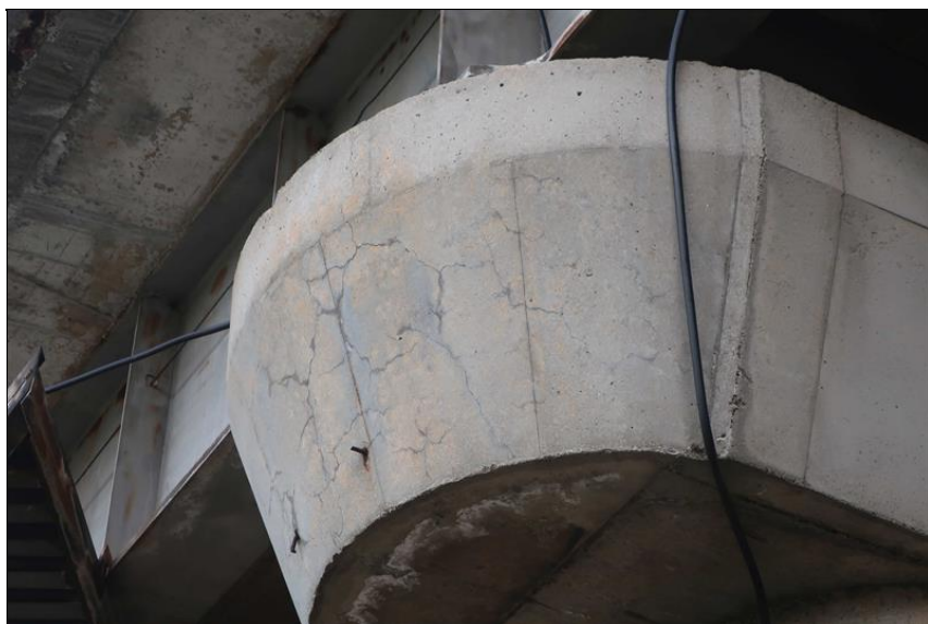
nepravidelné trhliny na pravém boku stativa P3
