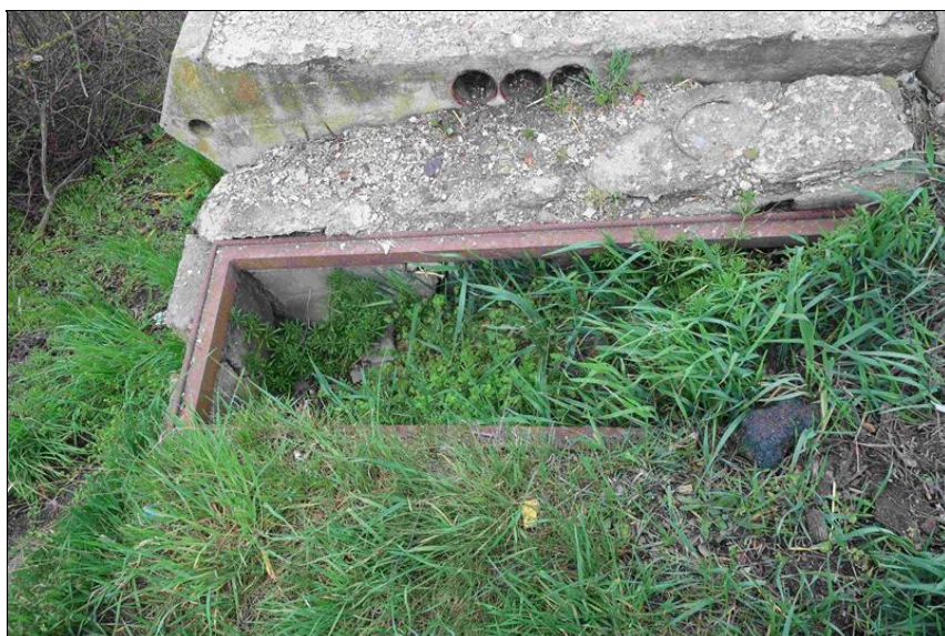
korodující ocelový rám vně římsy
