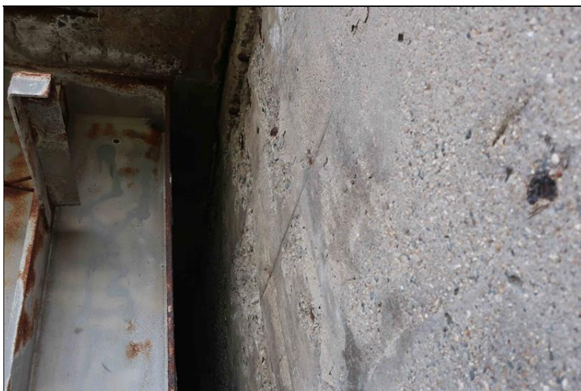
stopy po průsaku dilatační sparou na lic ZZ O4
