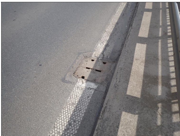
Odvodňovač na mostě.
