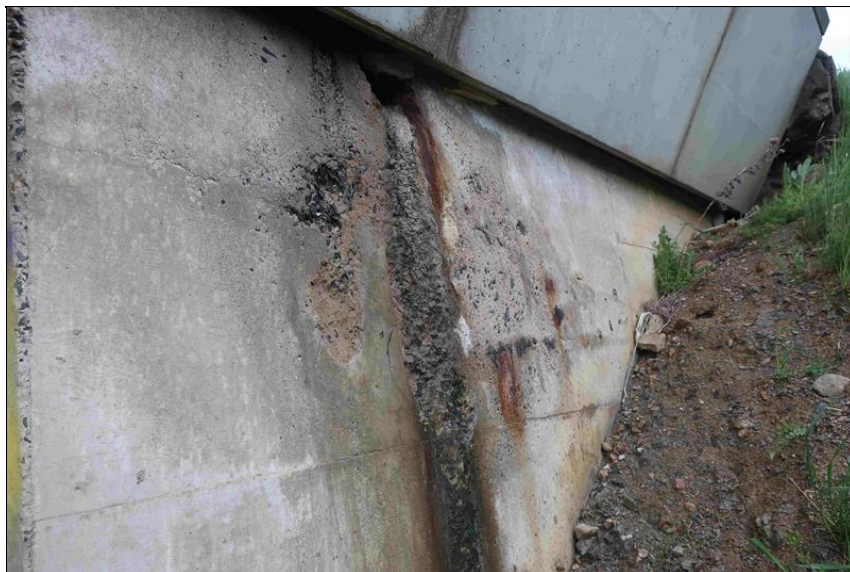
průsak na líci levého křídla O1
