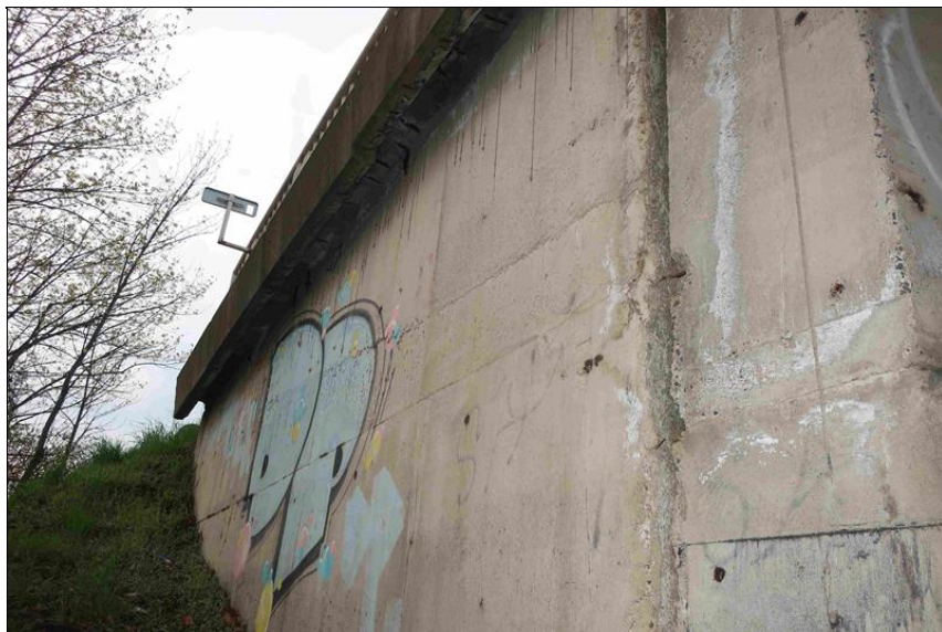
levé křídlo O4 průsaky svislou dilatační sparou mezi levým křídlem a opěrou
