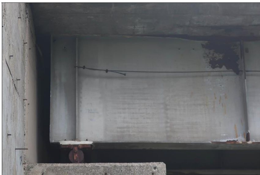
koroze ložiska O1
