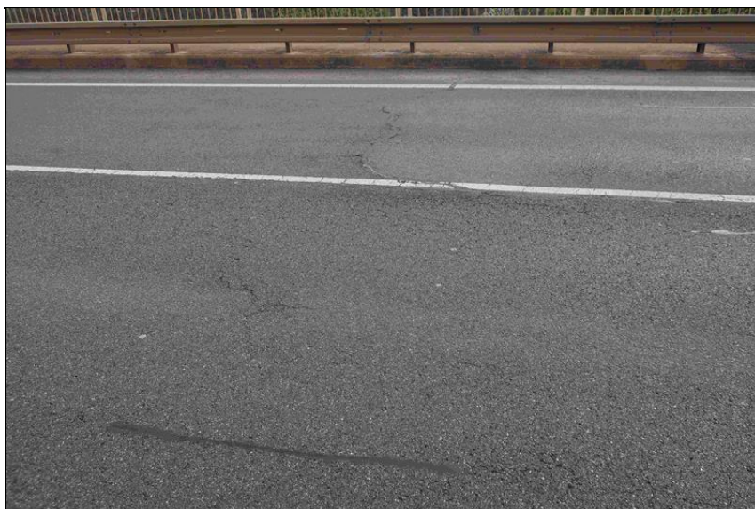
nepravidelné trhliny v krytu vozovky
