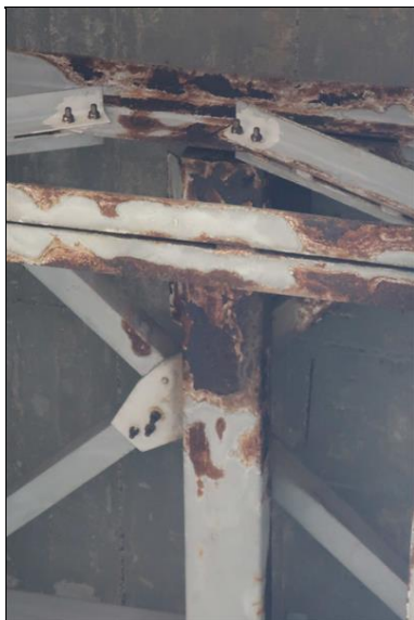
intenzivní koroze odvodňovacího žlabu koroze dotčených prvků NK
