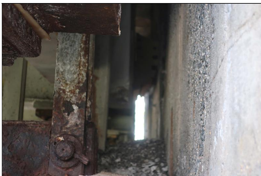
intenzivní koroze prvků zajišťujících tahovou reakci na O4
