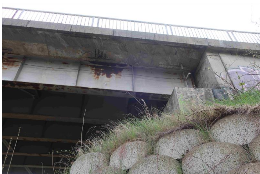
separace krycí vrstvy a koroze výztuže desky v místě průsaku koroze ocelového nosníku
