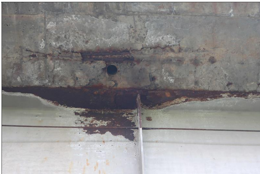
hloubková degradace betonu a koroze výztuže desky, resp. koroze ocelového nosníku v místě průsaku otvorem trubky odvodňující izolaci
