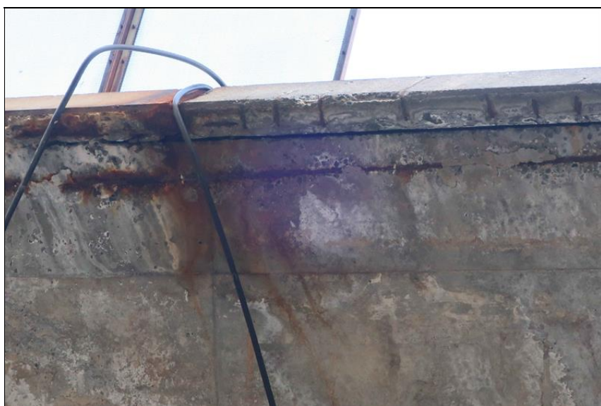
průsak sparou mezi mostovkou a římsou koroze výztuže, degradace betonu, separace krycí vrstvy
