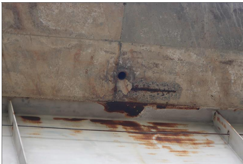
poruchy NK v okolí průsaku otvorem odvodňovací trubky
