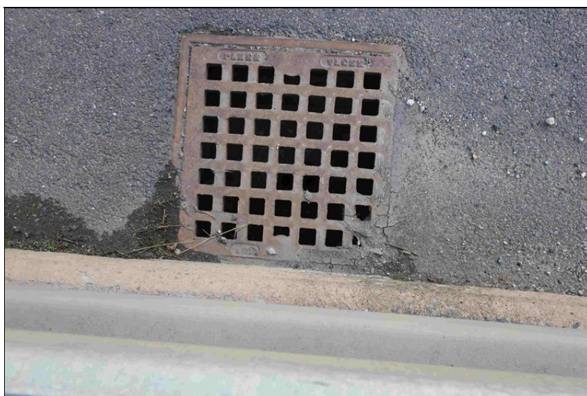
krycí mříž odvodňovače
