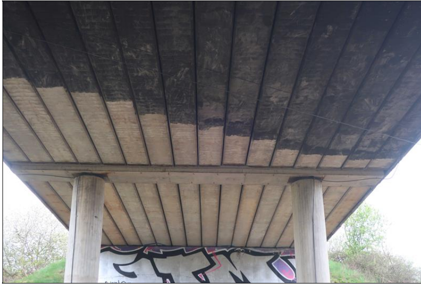
separace krycí vrstvy nad korodující výztuží u římsového prefabrikátu
