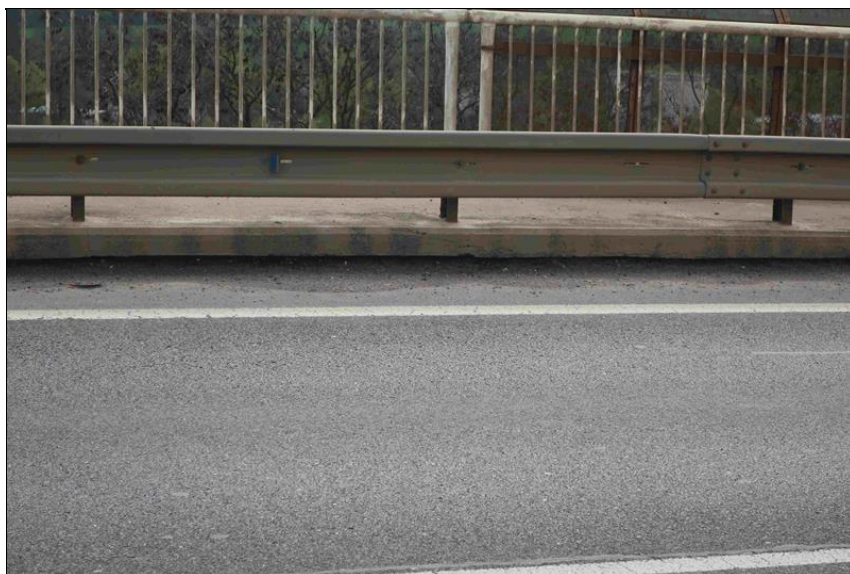
příčné trhliny v obrubě levého chodníku
