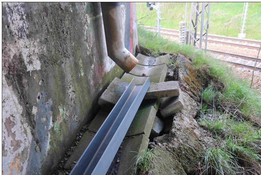
rozpad odvodňovacího žlabu v oblasti podemletí
