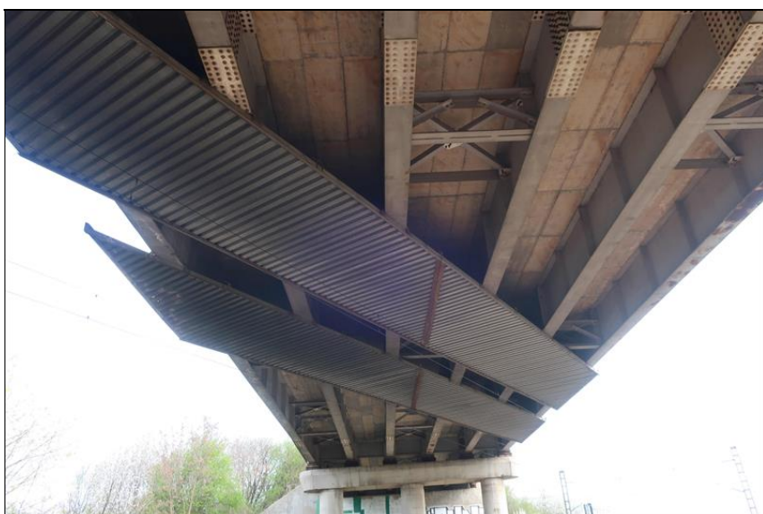
horizontální štíty na spodním líci NK
