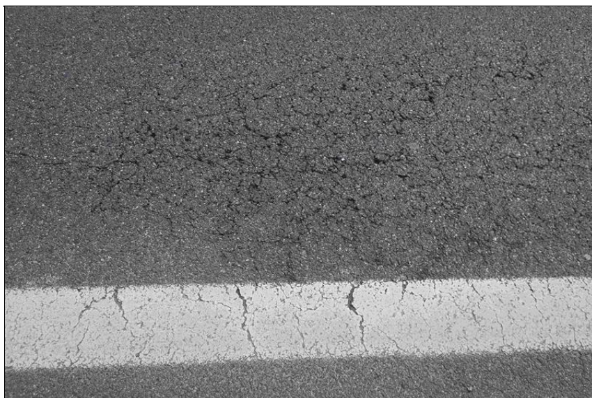
počínající výtluk v krytu vozovky
