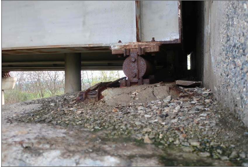
rozpad betonu a intenzivní koroze výztuže podkladního bloku O4 koroze ložiska
