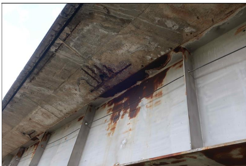
koroze výztuže a degradace betonu desky, koroze ocelového nosníku v místě průsaku
