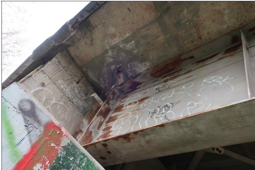
Koroze NK v oblasti průsaků dilatační sparou nad O4
