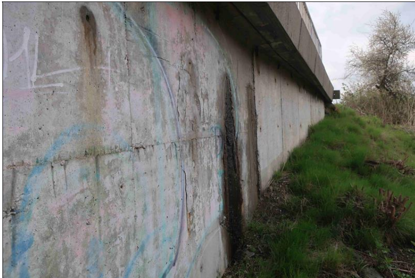
výrazný průsak na líci pravého křídla O4
