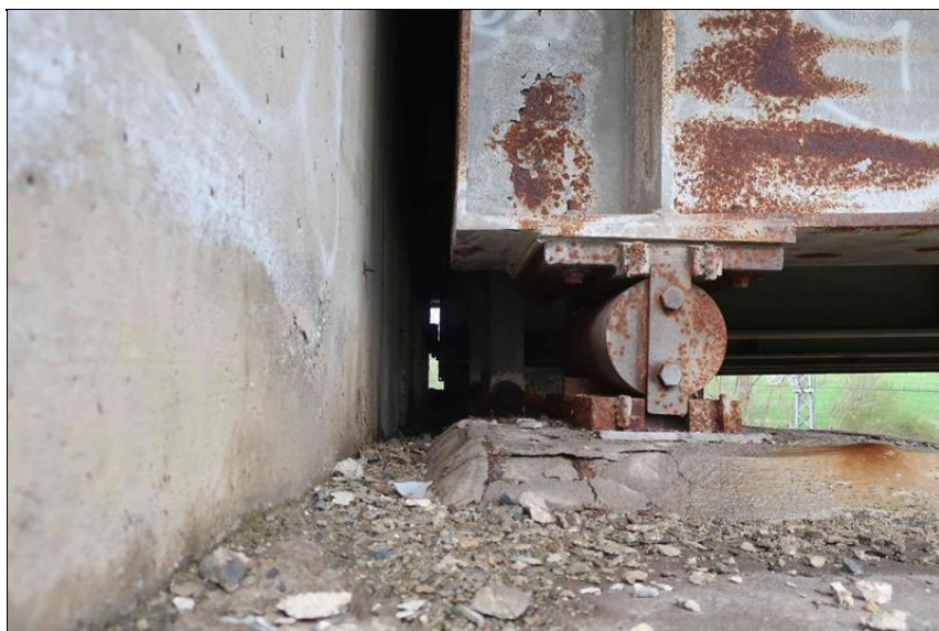
koroze ložiska O4 rozpad betonu a intenzivní koroze obnažené výztuže podkladního bloku
