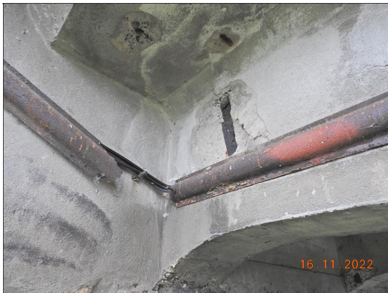
OP2, trhliny ve spárách.
