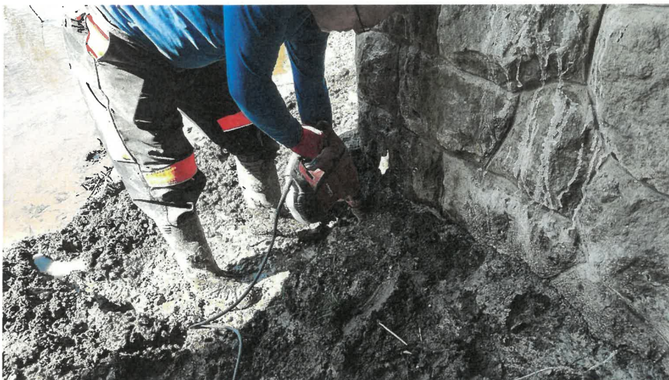
Obr. 22: Ověření hloubky založení mostní opěry pomocí navrtávky prodlouženým vrtákem.
