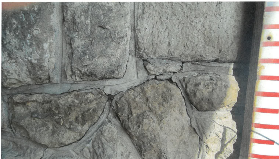
Obr. 16: Detail poškození soudržnosti (rozvolnění) části kamenného zdiva u opěry č. 2 (směr Plazy).
