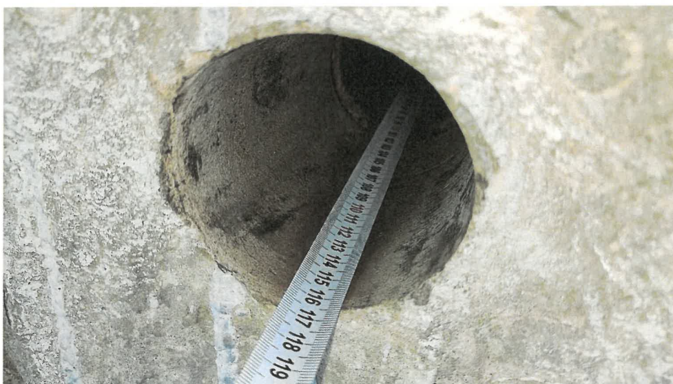
Obr: 5: Ověření tloušťky opěry (směr Kolomuty) bylo provedeno pomocí jádrového vývrtu č. 1-3. Tloušťka konstrukce opěry je 1170 mm.
