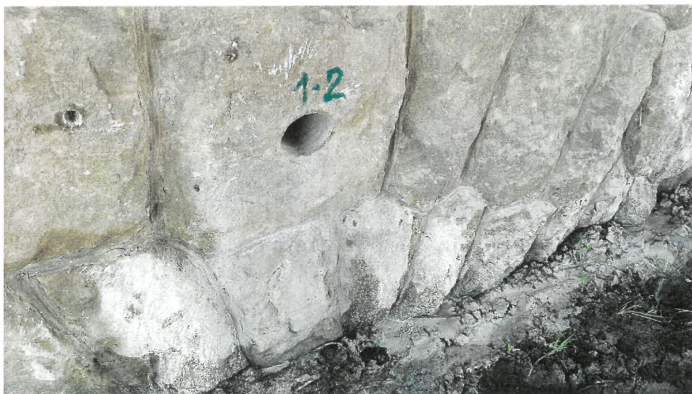
Obr. 3: Pohled na sondu po odběru jádrového vývrtu 1-2.
