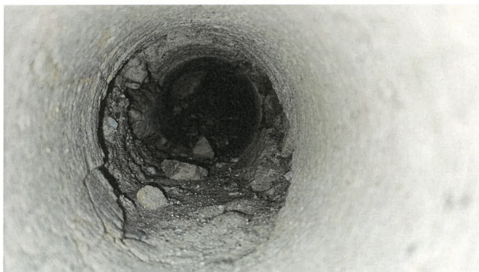
Obr. 12: Pohled do sondy po odběru jádrového vývrtnu 2-1. Při odběru jádrového vývrtnu docházelo k rozplavování pojiva i degradovaných úlomků kamene, které byly umístěny ve střední části konstrukce opěry.
