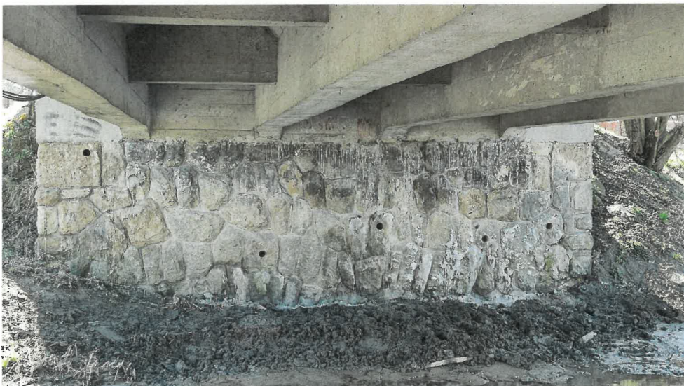
Obr. 2: Pohled na opěru č. 1 (směr Kolomuty). Ve zdících prvcích kamenného zdiva jsou viditelné sondy po odběrech jádrových vývrtů 1-1 až 1-5.
