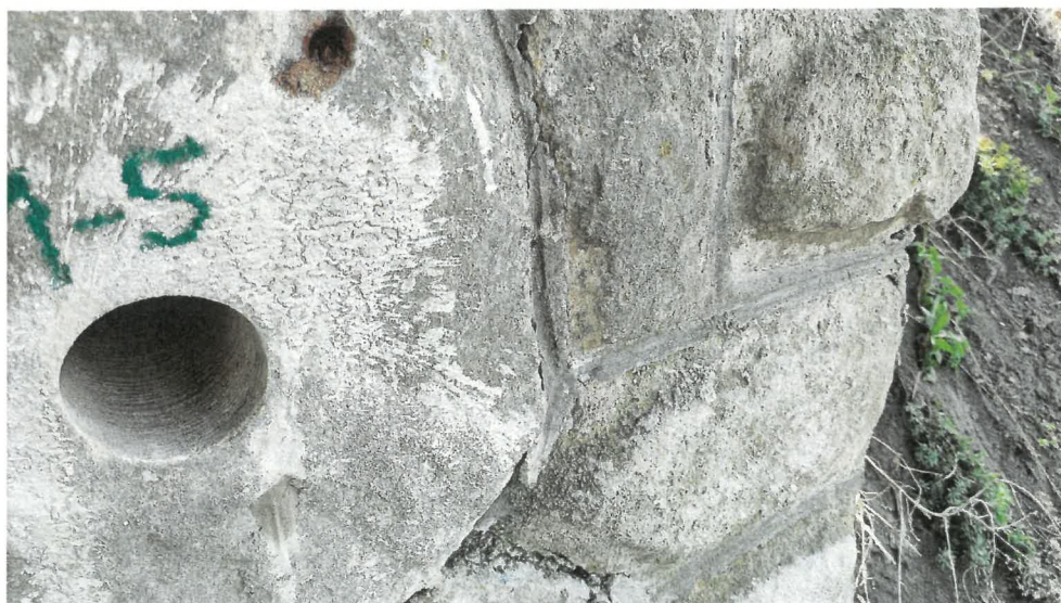
Obr: 6: Pohled na sondu po odběru jádrového vývrtu 1-5.
