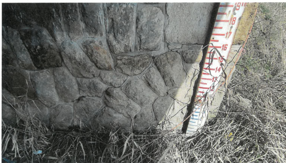
Obr: 15: Poškození soudržnosti (rozvolnění) kamenného zdiva u opěry č. 2 (směr Plazy).
