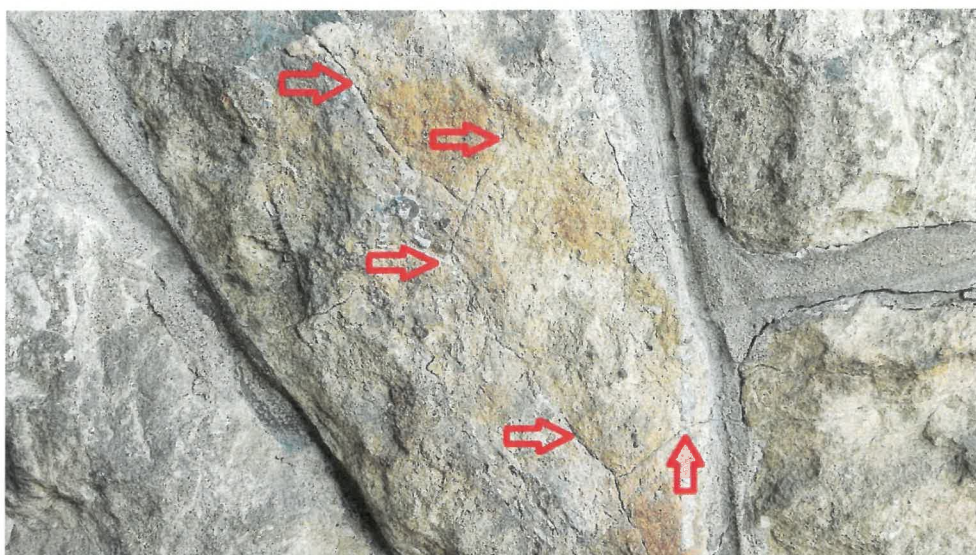
Obr. 17: Trhliny (pukliny) ve zdicím prvku opěry č. 2 (směr Plazy). Odborným odhadem lze, dle hran lomových ploch, určit staří trhlin na více než 10 let.
