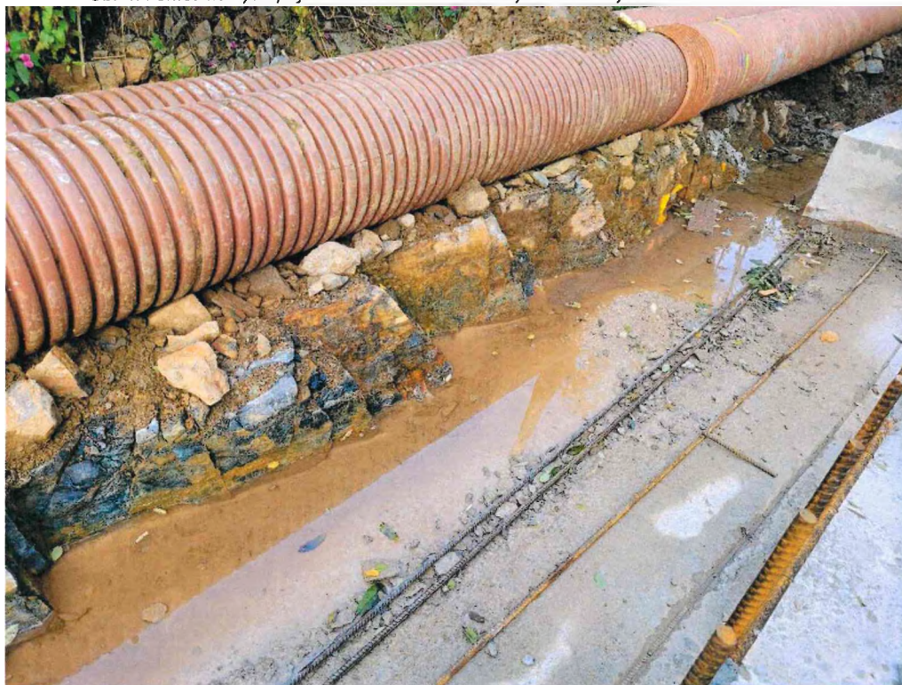
Obr 4: Pohled na vystupující masivní lavice novětralých až zdravých metabazaltů – SO252
