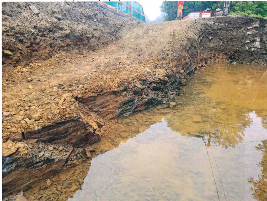
Obr 3: Pohled výkop stavební jámy objektu SO252 – v popředí masivní lavice metabazaltů
