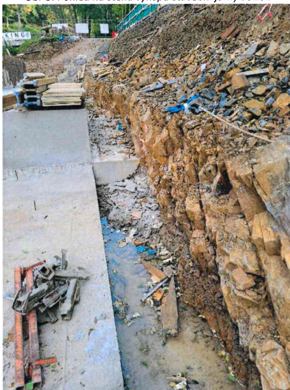
Obr 3: Pohled na stěnu výkopu stavební jámy SO251
