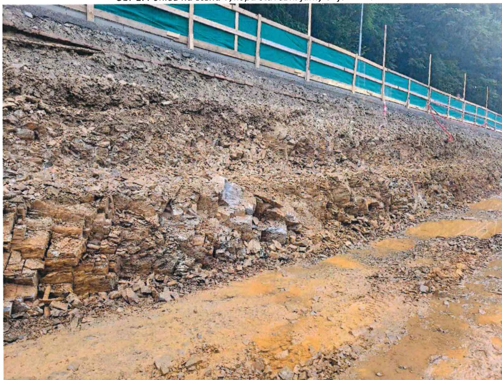
Obr 1: Pohled na stěnu výkopu stavební jámy objektu SO251
