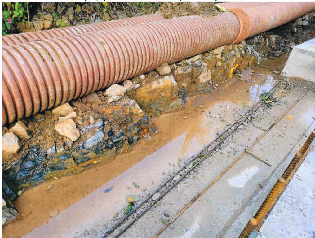
Obr 4: Pohled na vystupující masivní lavice navětralých až zdravých metabazaltů – SO252
