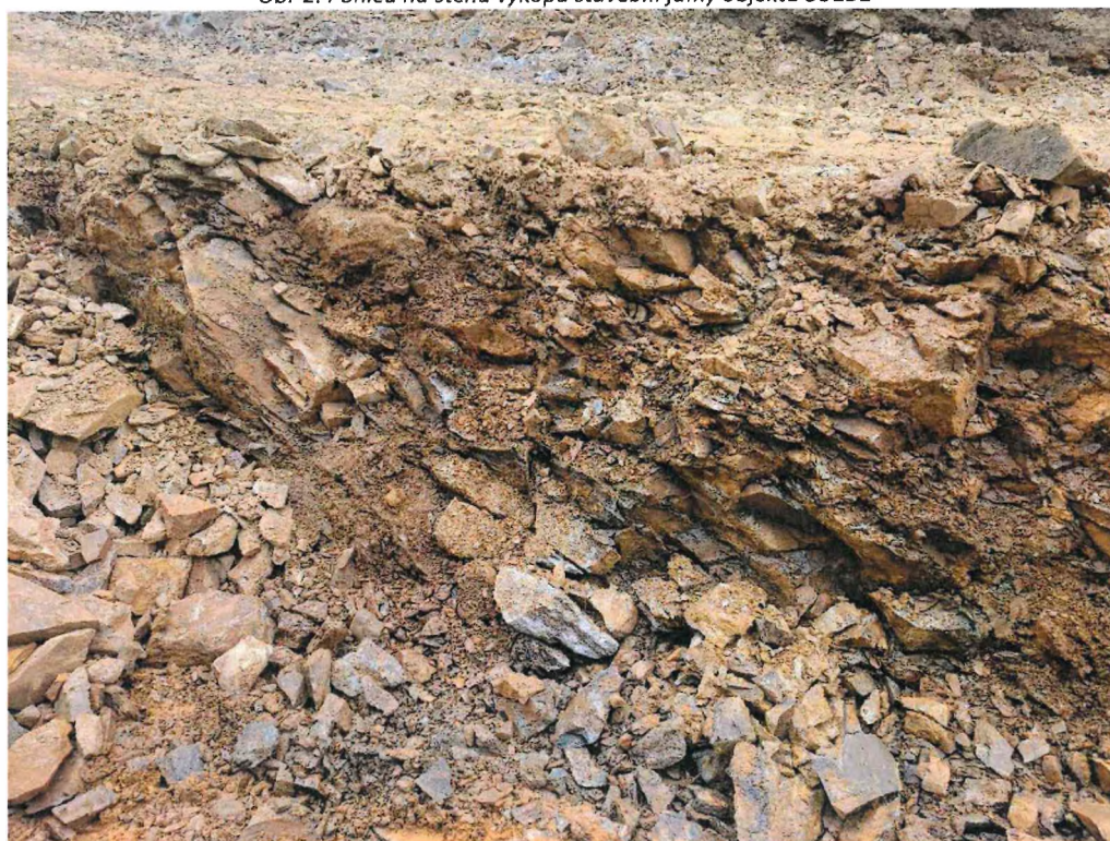
Obr 2: Pohled na stěnu výkopu stavební jámy objektu SO251
