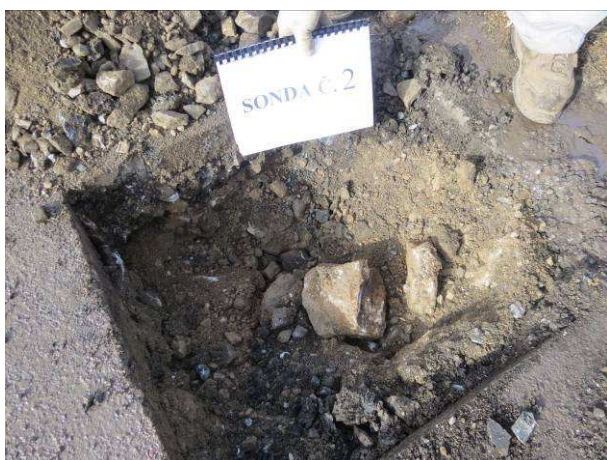
Sonda č.2 – štět v úrovni zemní pláň
