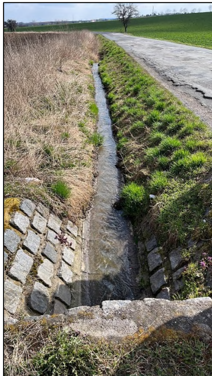
Obrázek 1 Pramen ve staničení km 1,850
