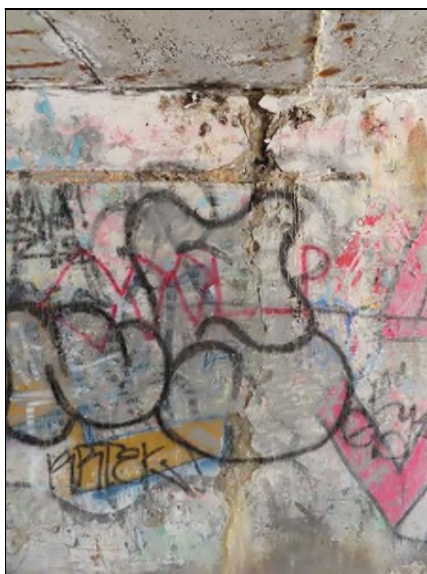
Pohled směrem k OP1 zleva Pod 10. nosníkem - svislá trhлина
