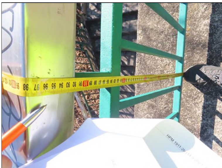
Levá strana Zábradlí - nízké- 0,98 m
