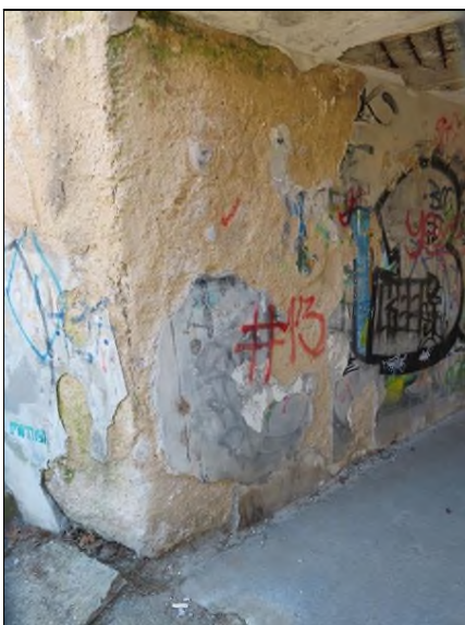
Pohled na OP1 zprava Plošné odpadnutí omítky, místy separace
