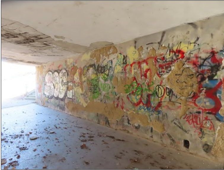
Pohled na OP1 střed Svislá trhлина pod spárou mezi 10-11. nosníkem
