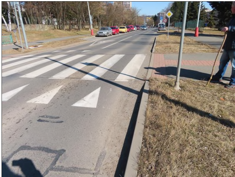
Pohled zleva Zpomalovací práh s náběhy na mostě- zvýšený povrch
