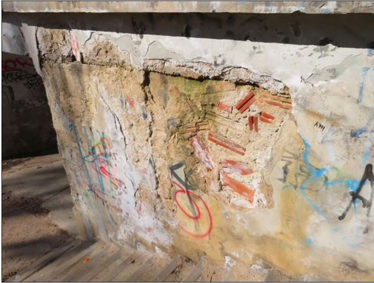
Pohled na OP1 a křídlo zleva Dozdění degradovaných míst -prohlubní úlomky cihel
