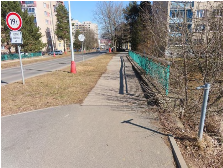
Pohled na uspořádání na mostě proti směru staničení
