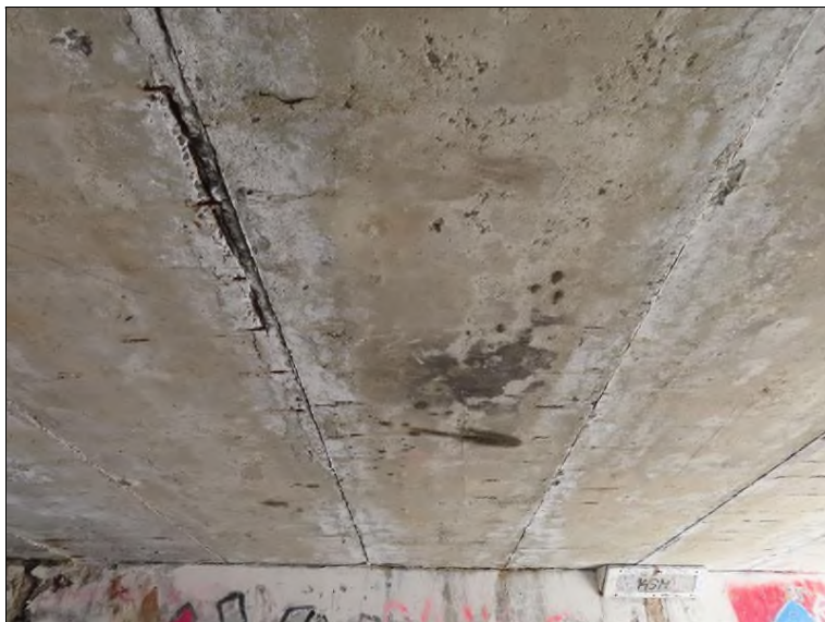
Pohled směrem k OP1 zleva 9. nosník - obnažená hlavní výztuž
