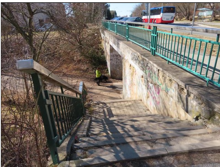
Pohled na most zleva od křídla OP1 Přístupové schodiště
