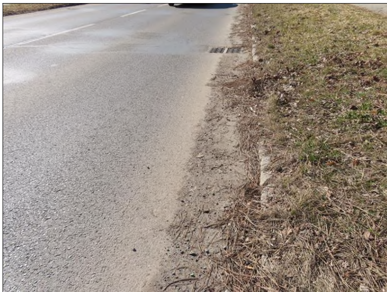
Pohled zprava před křídlem OP1 Vozovka - příčné trhliny, z části zalité Vpust'
