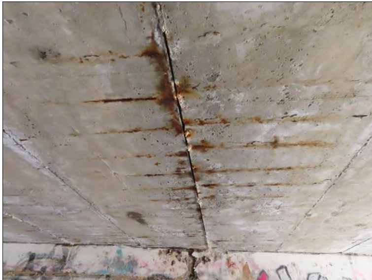
Pohled směrem k OP1 zleva Pod 10. nosníkem - svislá trhлина
