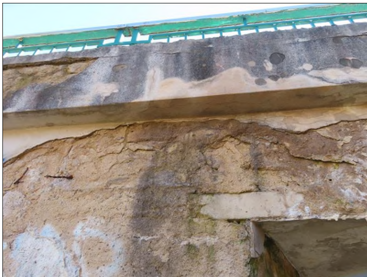
Pohled nad OP1 zprava Uložení krajního nosníku
