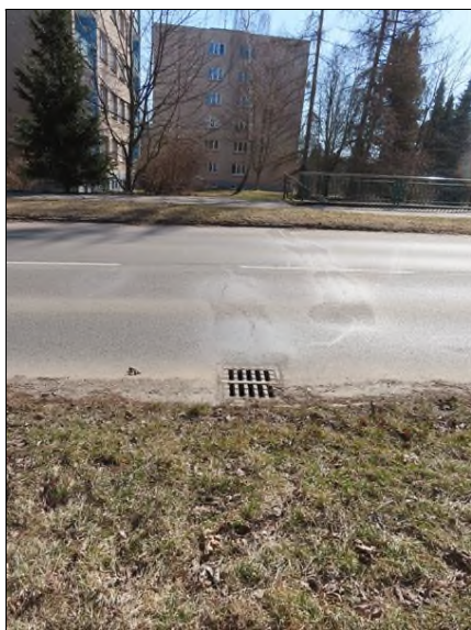
Pohled zprava před křídlem OP1 Vozovka - příčné trhliny, z části zalité Vpust'
