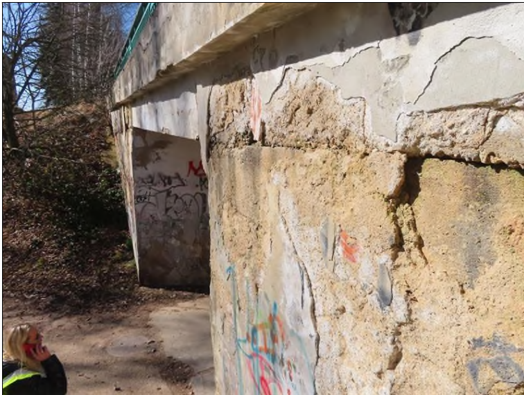
Pohled na OP1 a křídlo zleva Otevřená horizontální pracovní spáráv křídle v úrovni úložného prahu
