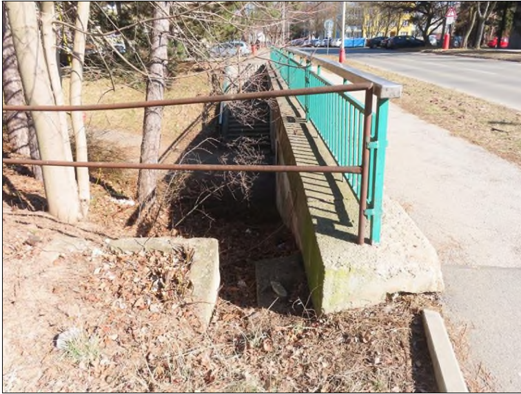
Pohled zprava od konce křídla OP2 Navazující zábradlí
