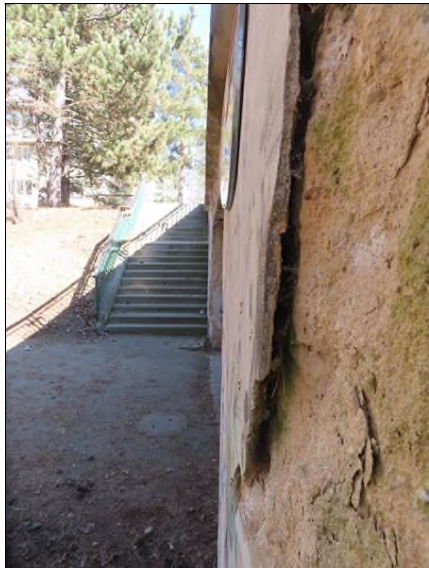
Pohled na OP2 a křídlo zprava Projevy zatékání pod římsou - separace
