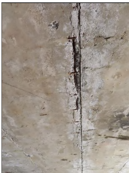
Pohled směrem k OP1 zleva 9. nosník - obnažená hlavní výztuž
