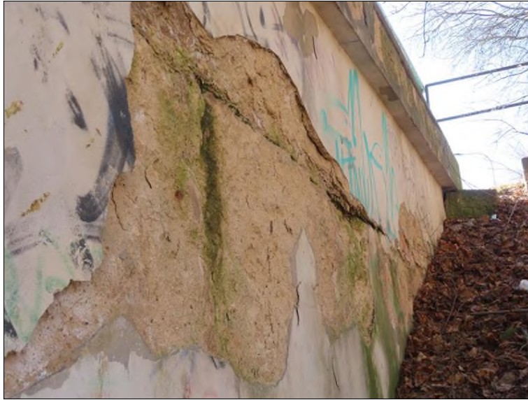
Pohled na OP2 a křídlo zprava Projevy zatékání pod římsou - separace
