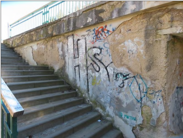
Pohled na OP1 zprava Plošné odpadnutí omítky, místy separace
