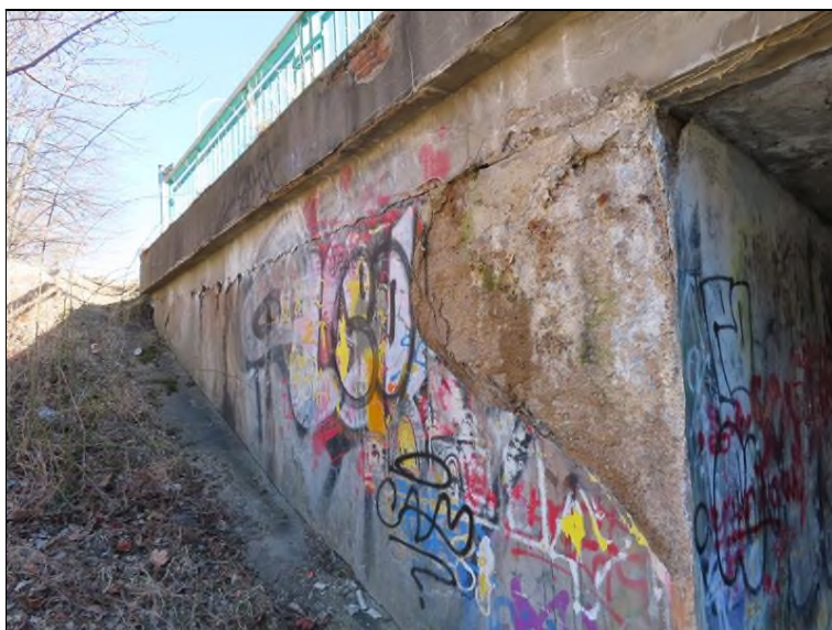
Pohled na OP1 a křídlo zprava Plošné odpadnutí omítky, místy separace Otevřená horizontální pracovní spára
