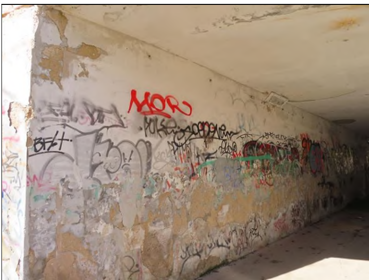
Pohled na OP2 zleva Plošné oddělování omítky
