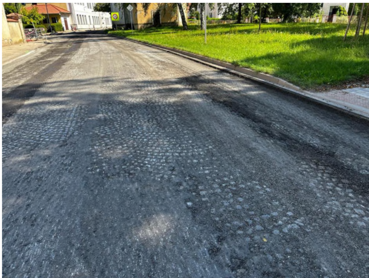
Příloha č. 1 – Fotodokumentace stavu stávajících podkladních vrstev ze dne 28. 08. 2023
