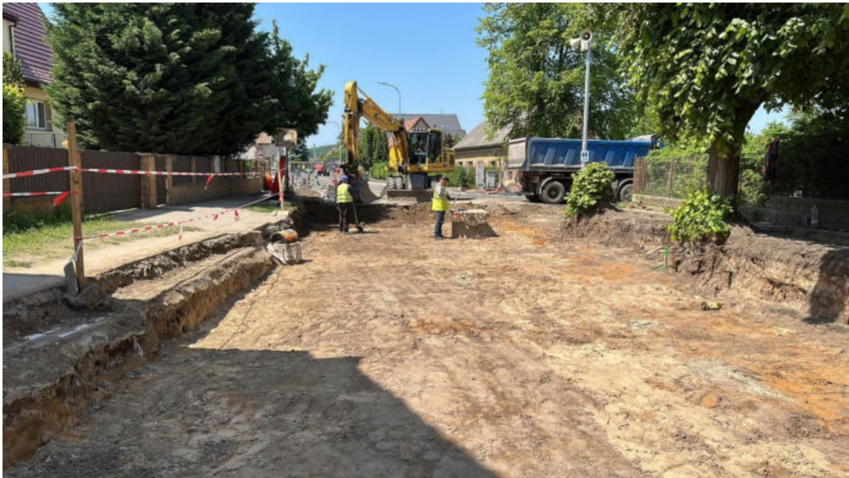
Příloha č. 4 - Fotodokumentace stavu zemní pláně II. etapa
