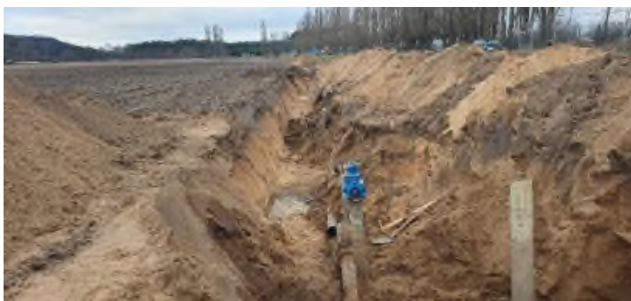
Výkop pro SO 311 v km cca 0,4 až 0,45
