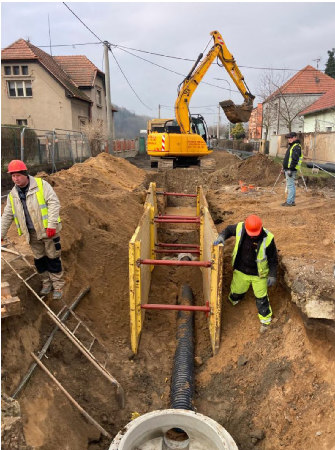
Příloha č. 6 - Fotodokumentace stavu rýhy dešťové kanalizace ze dne 27.02.2023
