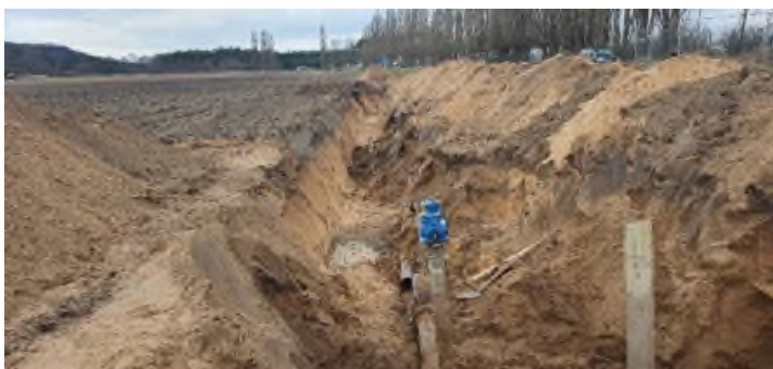
Výkop pro SO 311 v km cca 0,4 až 0,45
