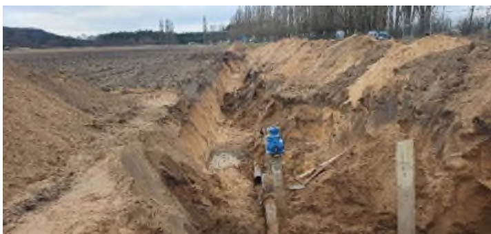
Výkop pro SO 311 v km cca 0,4 až 0,45
