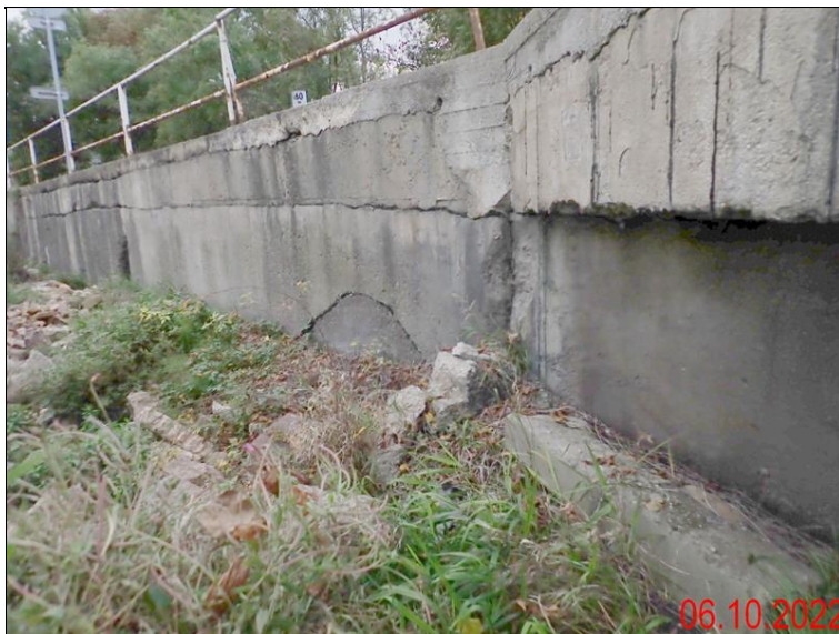
1.2 Opěra O1 - pravé křídlo.JPG
