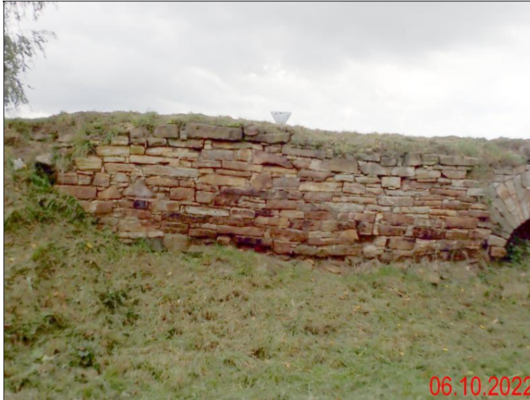
1.2 Opěra O3 - levé křídlo.JPG
