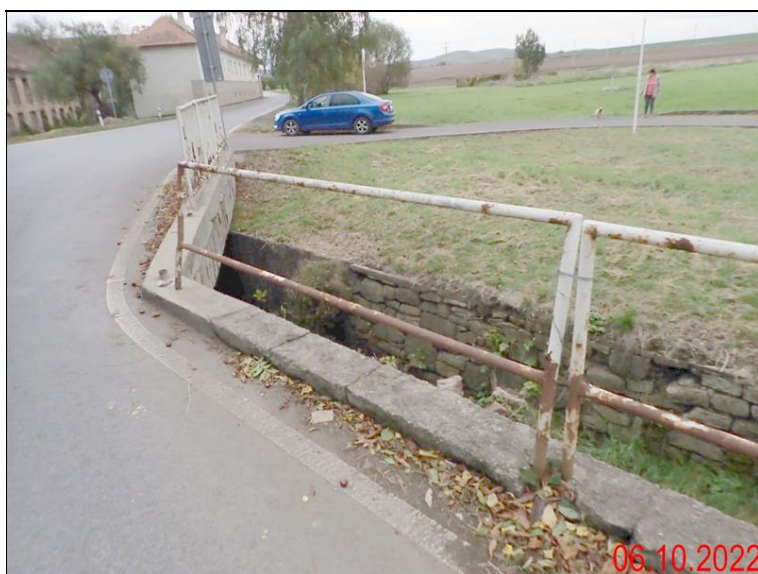
4.2 Zábradlí vpravo na křídle - volný jeden díl.JPG
