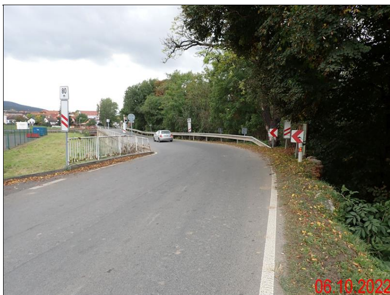
0.2 Pohled proti směru staničení.JPG
