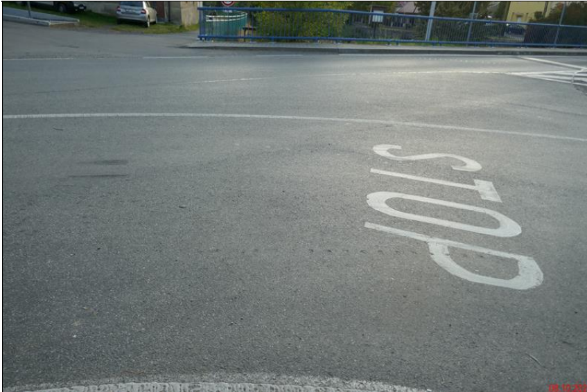
3.1 Vozovka na mostě.JPG
