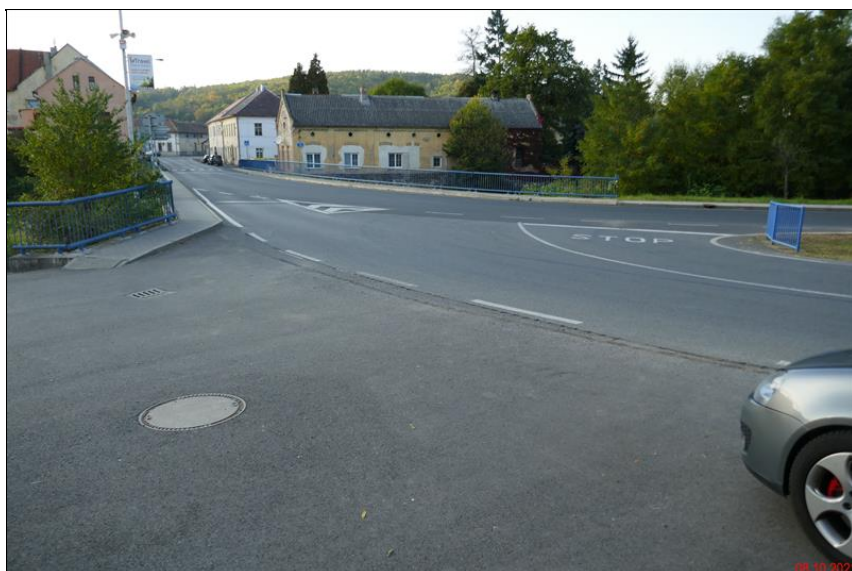
0.2 Pohled proti směru staničení.JPG
