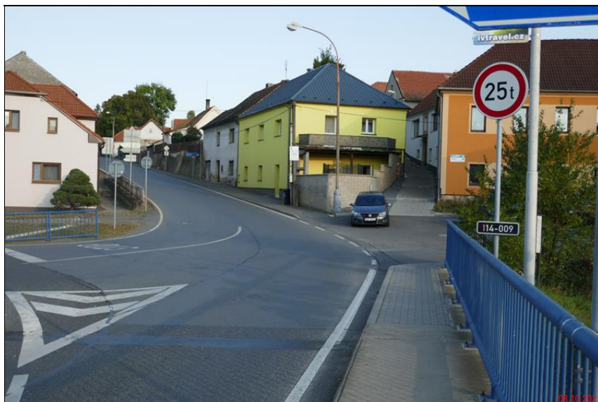
0.1 Pohled ve směru staničení.JPG
