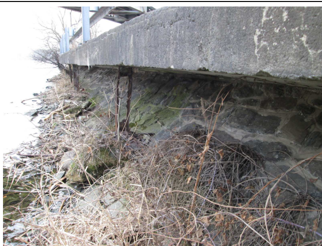
Masivní koroze ocelových prvků,, pravděpodobně historické sloupky svodidla, rozpad.
