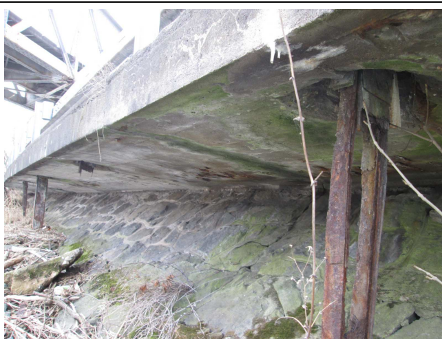
Dtto. Stopy zatékání. Bionapadení.
