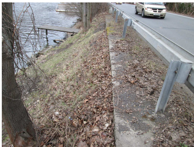
Nečistoty, nánosy na římse.
