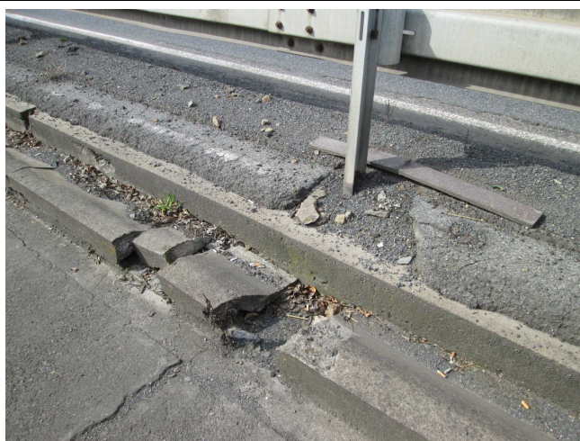
Rozpad předsazeného řlabu.
