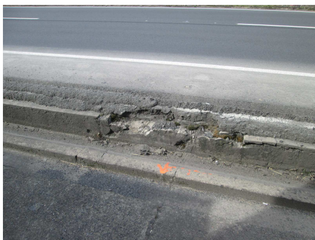
Masivní degradace betonu, rozpad.
