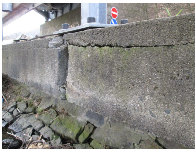
Delaminace horní části římsy.
