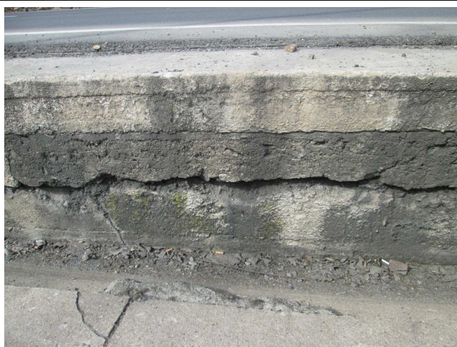
Vodorovná trhlina nebo otevřená pracovní spára. Masivní degradace betonu.
