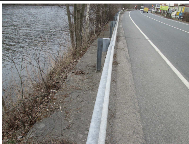
Povrchová degradace betonu.
