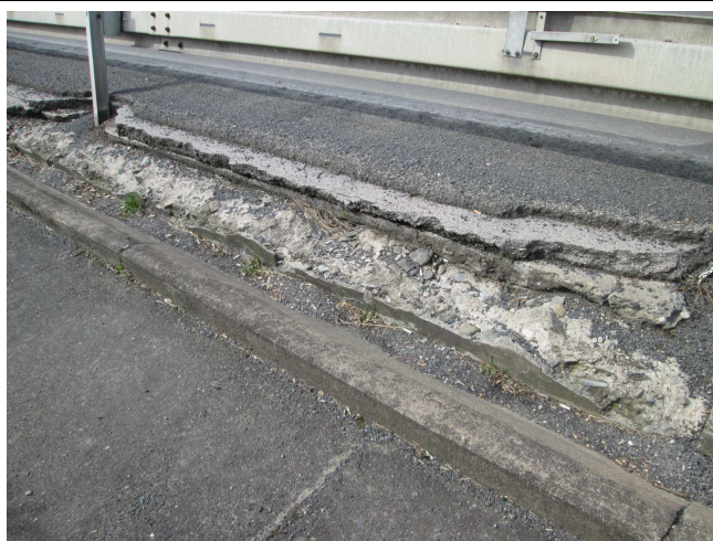
Masivní degradace betonu, rozpad. Část zdi chybí.
