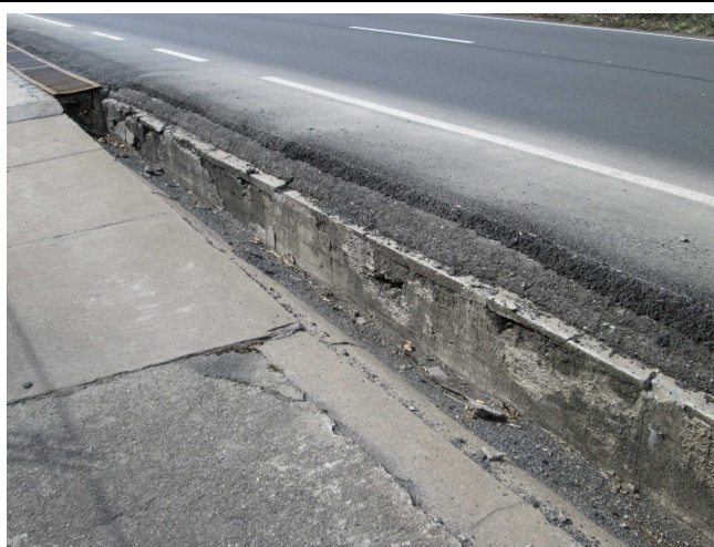
Výrazně převýšená vozovka. Masivní degradace betonu.
