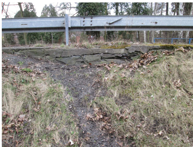
Masivně vydrolené spáry.
