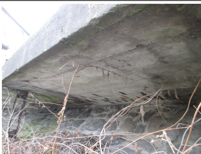
Podhled konzoly. Stopy zatékání. Bionapadení.
