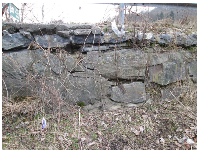
Masivně vydrolené spáry.
