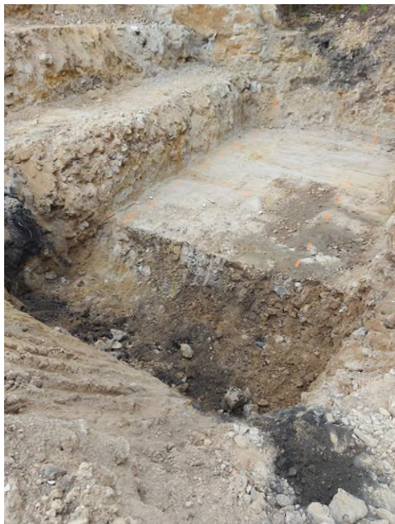
Výměna materiálu základové spáry
