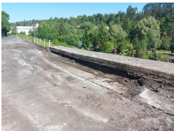
Bourání betonové desky pod komunikací
