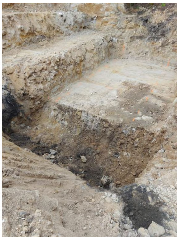
Výměna materiálu základové spáry
