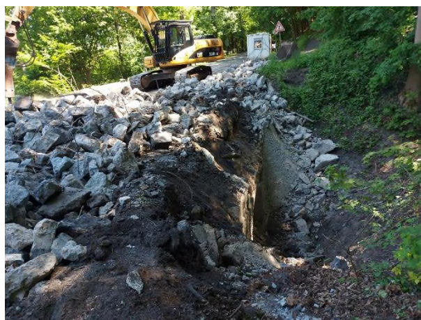
Bourání betonové desky pod komunikací
