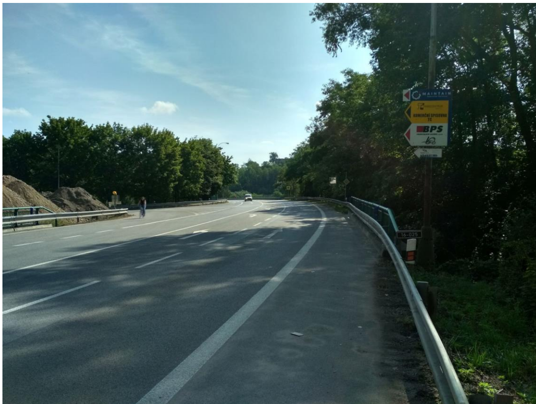
Obrázek 7 – ve směru Benátky n. J. – Krnsko vedení cyklotrasy po silnici I/16 přes levý odbočovací pruh v křižovatce ( z pohledu bezpečnosti nevhodné řešení )
