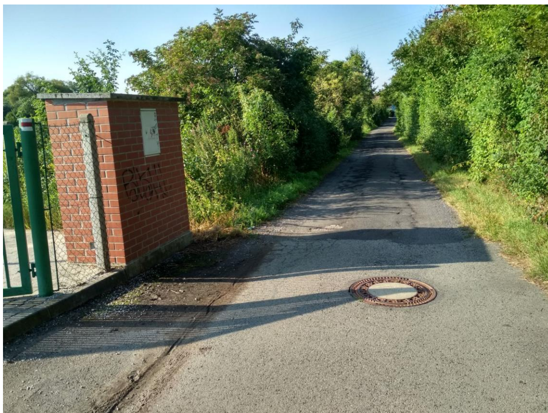
Obrázek 30 – km 2,900 - vedení cyklotrasy po místní komunikaci, horší obrušná vrstva
