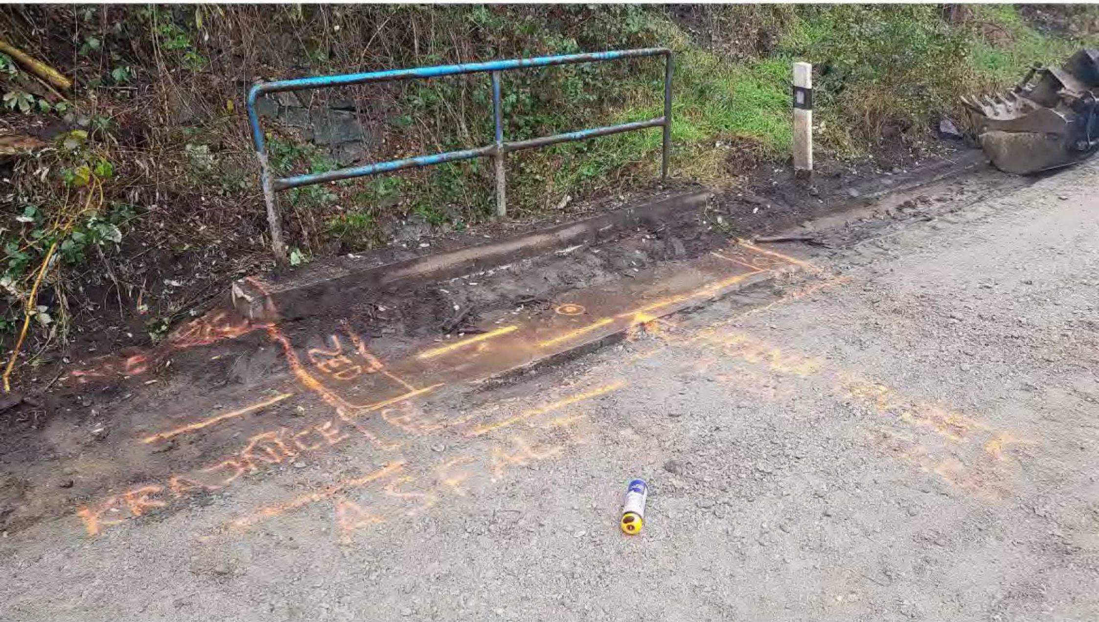
Fotka z místního šetření propustku km1,389
