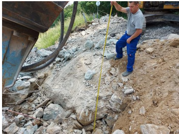
Bourání betonového bloku (vysprávka propadu komunikace)
