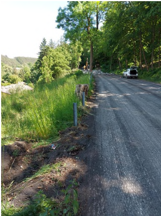
Frézování vozovky
