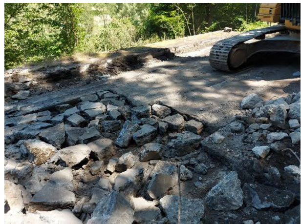
Bourání betonové desky pod komunikací
