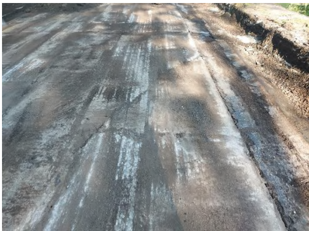
Bourání betonové desky pod komunikací
