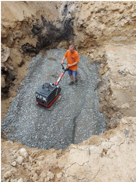
Výměna materiálu základové spáry
