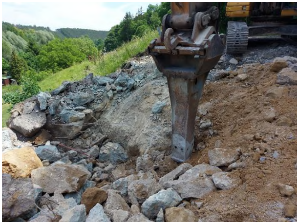
Bourání betonového bloku (vysprávka propadu komunikace)
