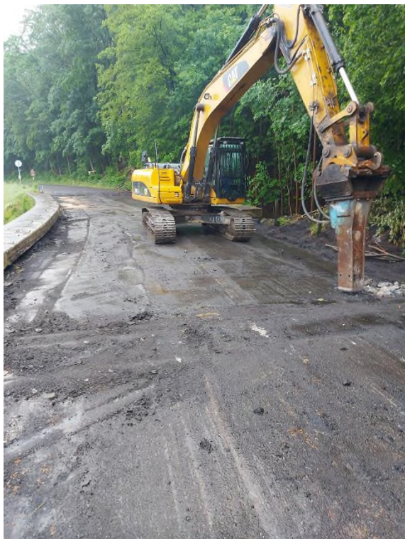
Bourání betonové desky pod komunikací
