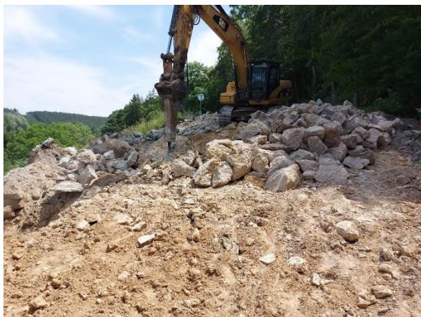
Bourání betonového bloku (vysprávka propadu komunikace)
