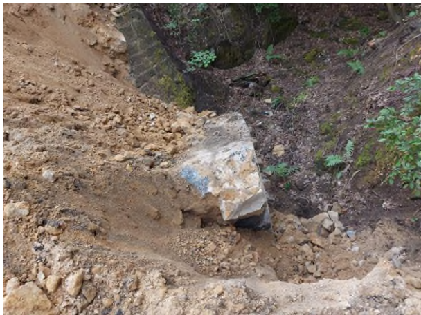
Bourání betonové klenby
