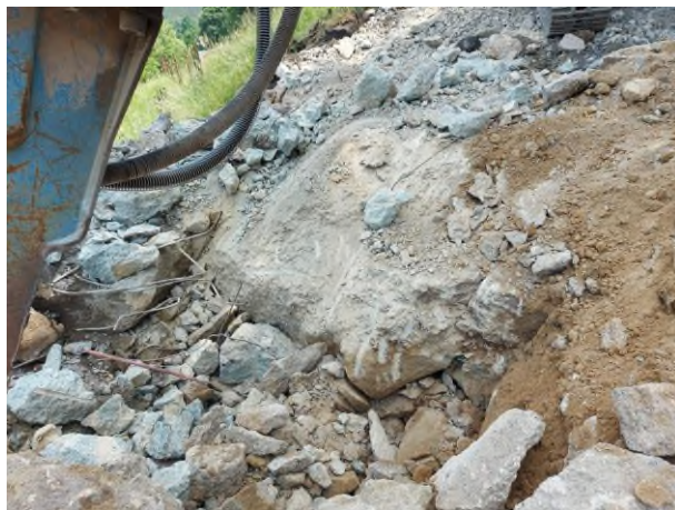
Bourání betonového bloku (vysprávka propadu komunikace)
