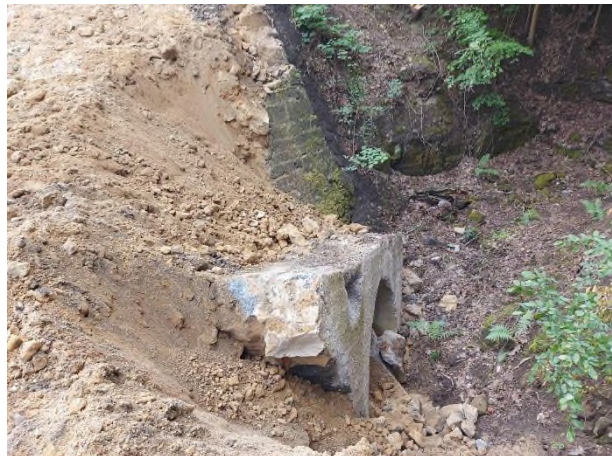
Bourání betonové klenby
