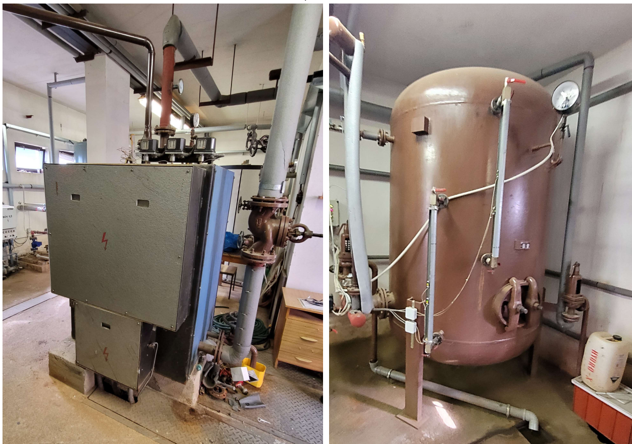
Obrázek č. 4.5.1.1: Vlevo - elektrokotel ČKD Dukla EOK 250, vpravo - akumulční nádrž
