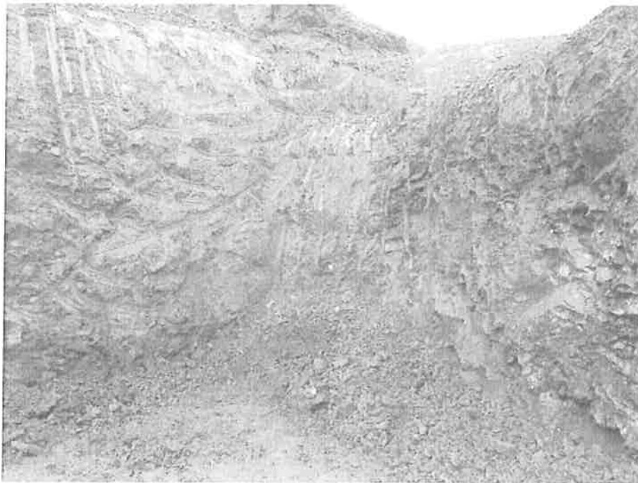
Obr.3 – Pohled na část stavební jámy s více zvětralou horninou (proterozoické droby)
