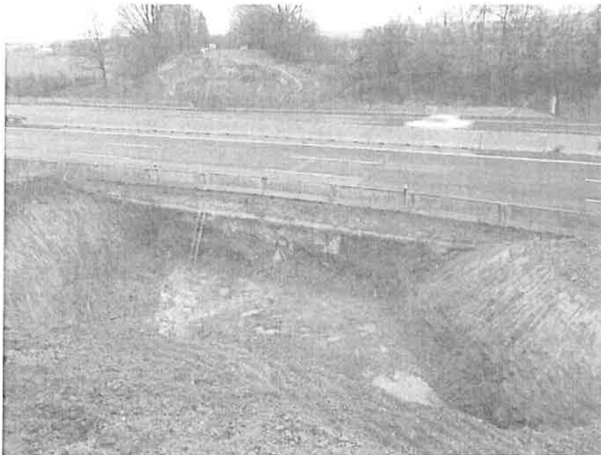
Obr.1 - Pohled do stavební jámy před konečným dočištěním
