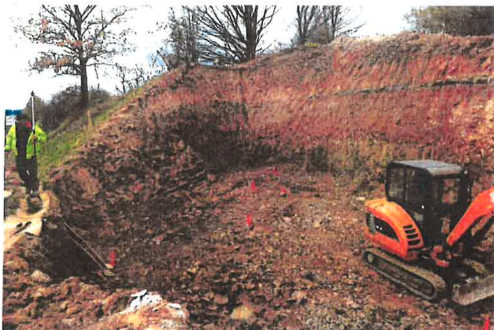
Obr.1 - Pohled do stavební jámy
