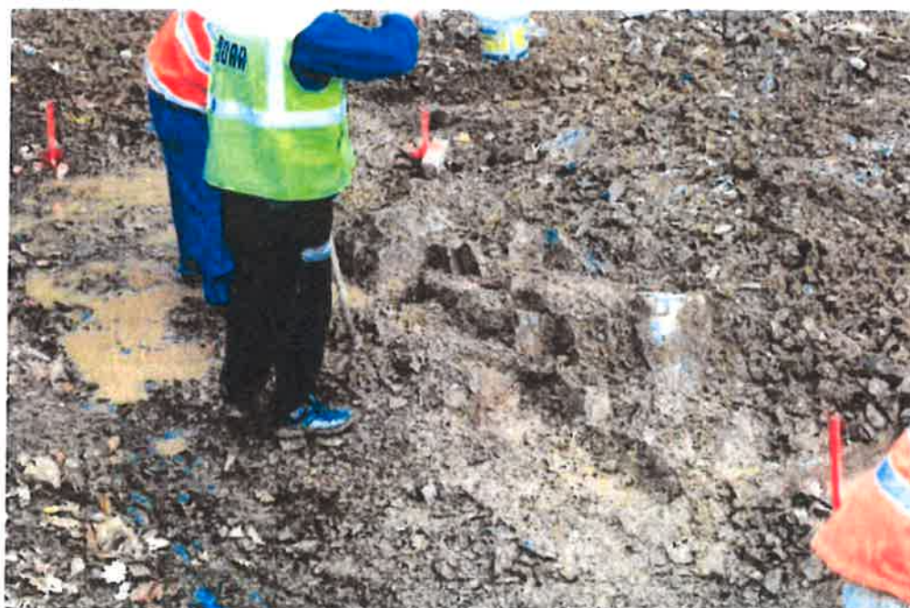
Obr.2 – Dočišťování základové spáry
