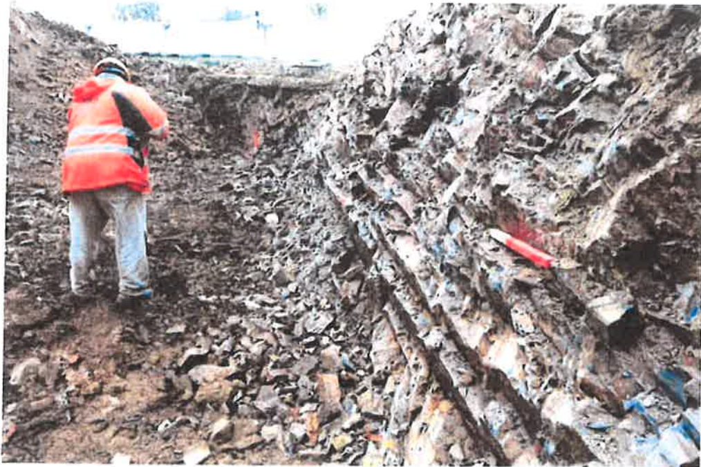
Obr.3 – Proterozoické droby vystupující v západní stěně výkopu (26.10.2017)
