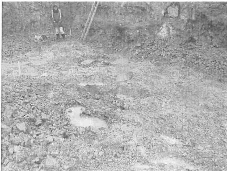
Obr.2 – Pohled na severní část základové spáry před konečným dočištěním
