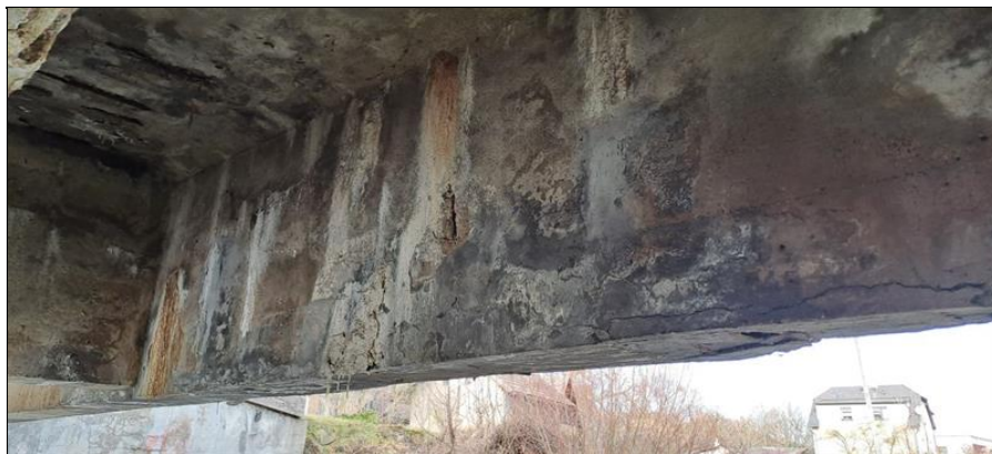
5. trám (PS) vnitřní strana
