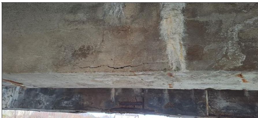
4. trám(PS) vnitřní strana
