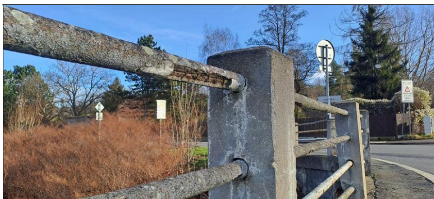
Zábradlí na PS
