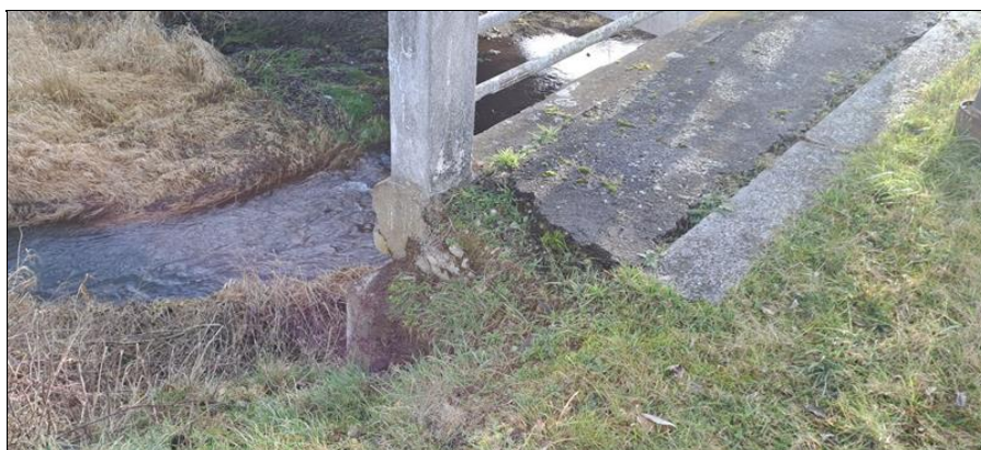
Konec chodníku nad křídlem OP02, PS
