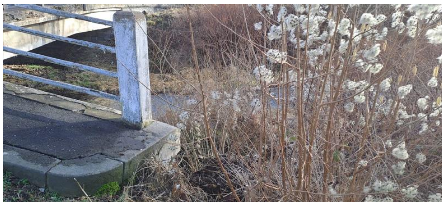
Konec chodníku na LS, nad křídlem OP02
