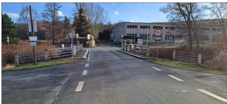
Pohled proti směru staničení
