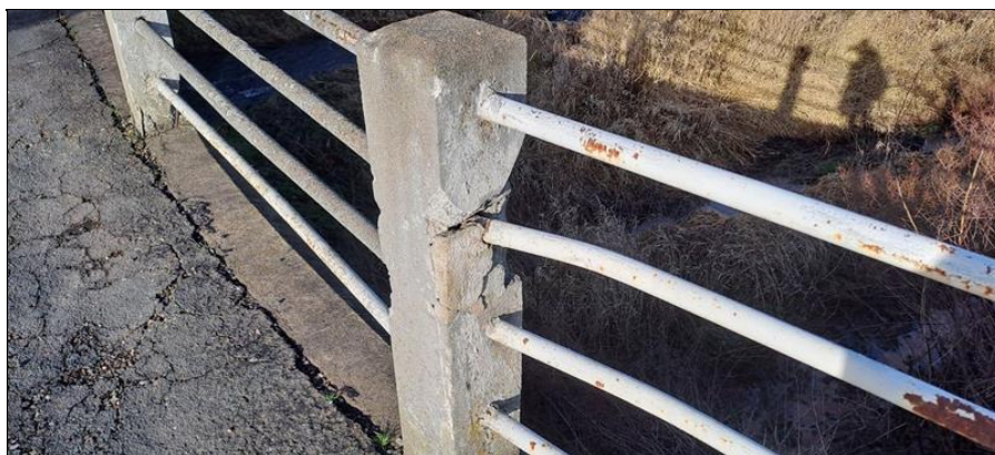
Zábradlí na PS
