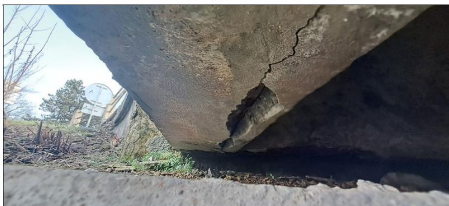
5. trám (PS) nad OP01
