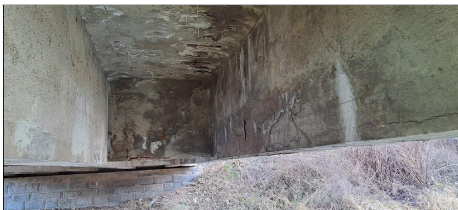
Příčnick a mostovka mezi 1. a 2.trámem z návodní strany , pohled od OP02
