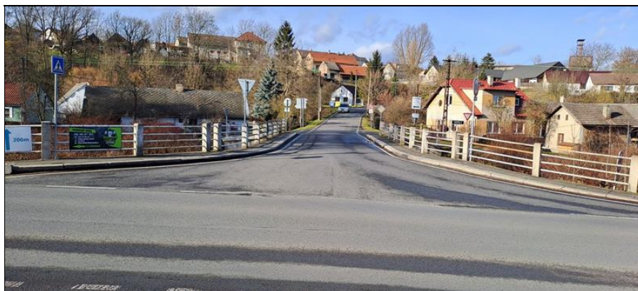
Pohled ve směru staničení
