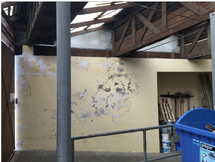
foto - stávající zastropení - dřevěné vazníky
