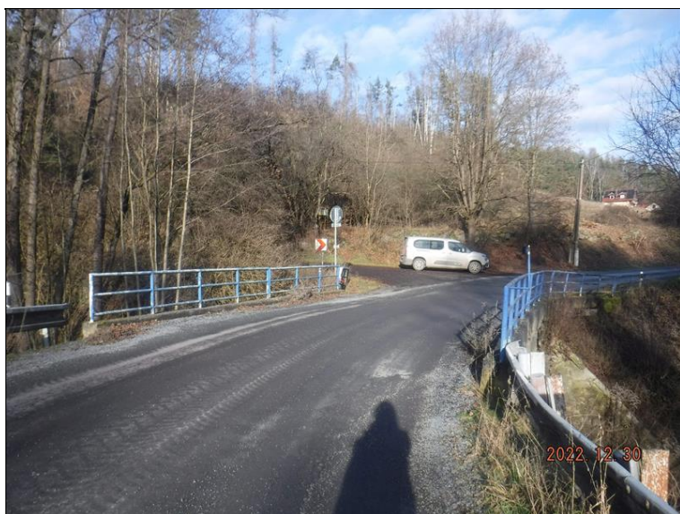
Celkový pohled na svršek konstrukce (proti směru staničení).
