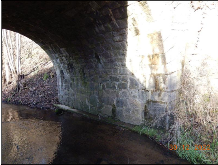
Pohled na opěru O1 zleva.
