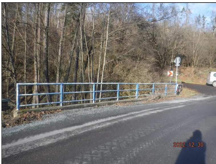
Celkový ohled na zábradlí na pravé straně
