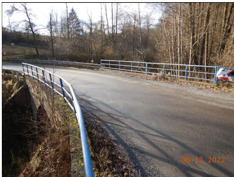
Celkový pohled na svršek konstrukce (ve směru staničení).
