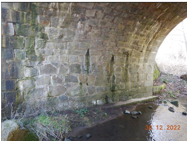
Pohled na opěru O2 zleva.
