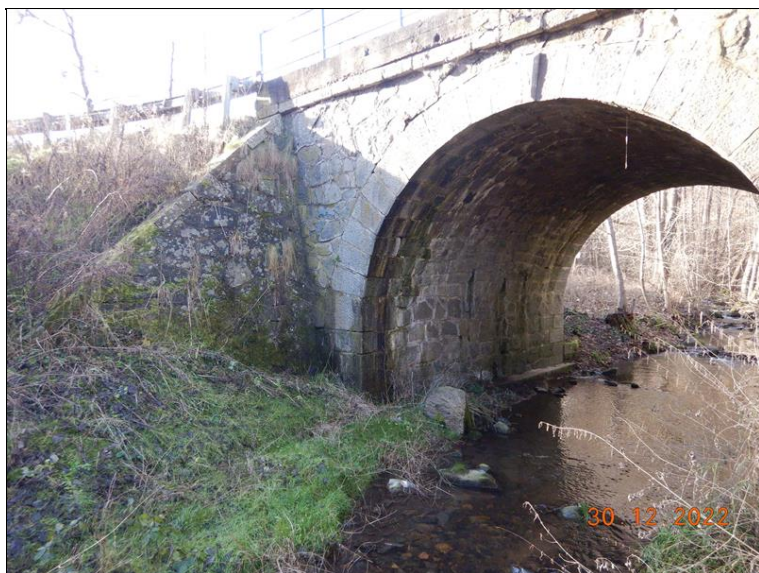
Pohled na levé křídlo opěry O2.
