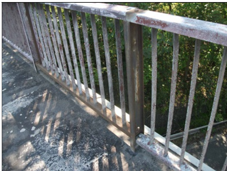
pravá strana mostu, povrchová koroze zábradlí
