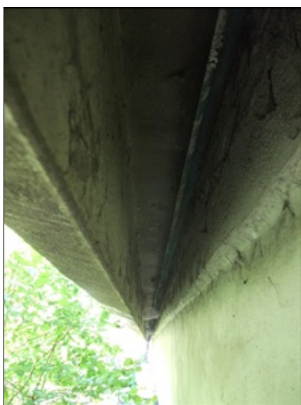
levá strana, korodující okapnice pod římsou
