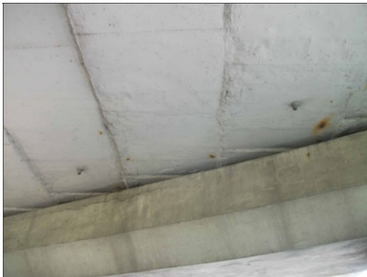
pilíř P4, trhliny v sanaci stativa, chybějící optvor odvodnění dutiny nosníku
