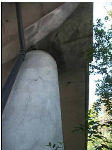
pilíř P2, trhliny na boku sloupu
