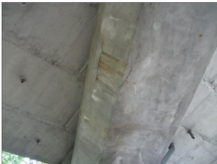
pilíř P4, pata sloupu, odpadávající krycí vrstva betonu a sanace
