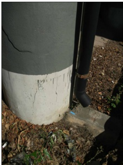
oilíř P2 trhliny v povrchu betonu v patě sloupu
