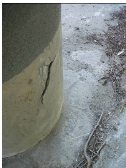
pilíř P4, pata sloupu, odpadávající krycí vrstva betonu a sanace
