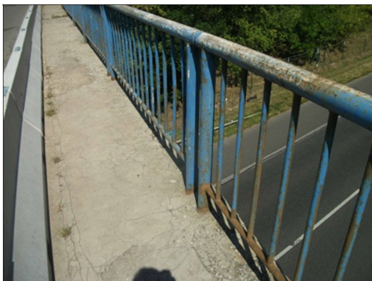
pravá strana mostu, silná povrchová koroze zábradlí, trhliny a rozpad povrchové vrstvy chodníku
