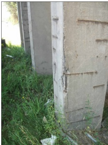
pilíř P4, odpadání povrchové vrstvy betonu stojek, koroze obnažené výztuže
