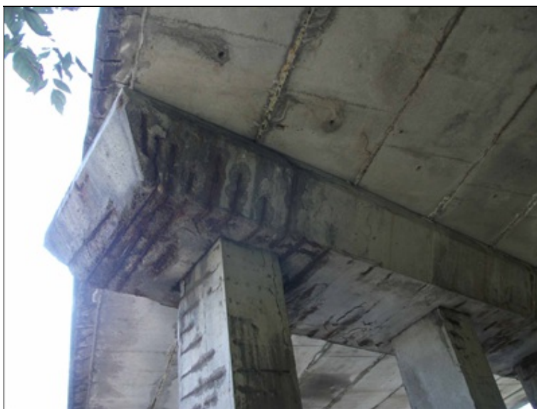
detail pilíře P4, masivní koroze odhalené výztuže
