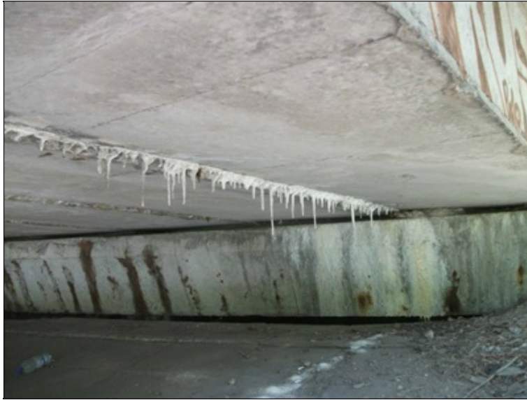
pole 4, protékání vody mezi nosníky, pokles opevnění svahu před OP1, koroze obnažené výztuže úložného prahu opěry OP5
