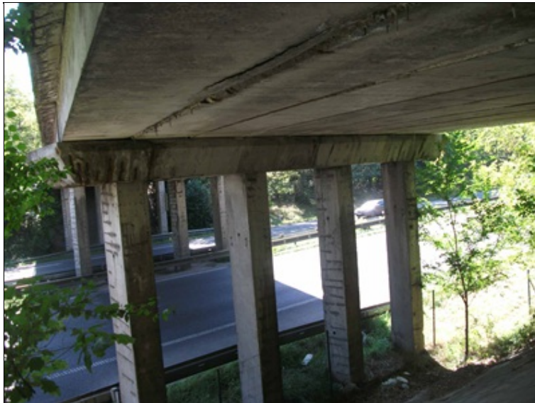
podhled mostu od Op5, masivní odpadání krycí vrstvy betonu na podpěrách, koroze odhalené výztuže, dtto v římsách
