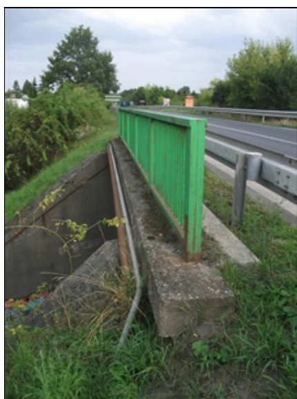
levá římsa mostu, degradace betonu římsy
