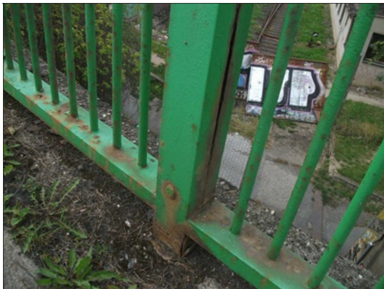
zábradlí vlevo, silná koroze, zejména v patce sloupku
