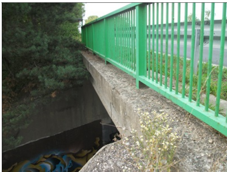
pravá římsa, degradace povrchu betonu
