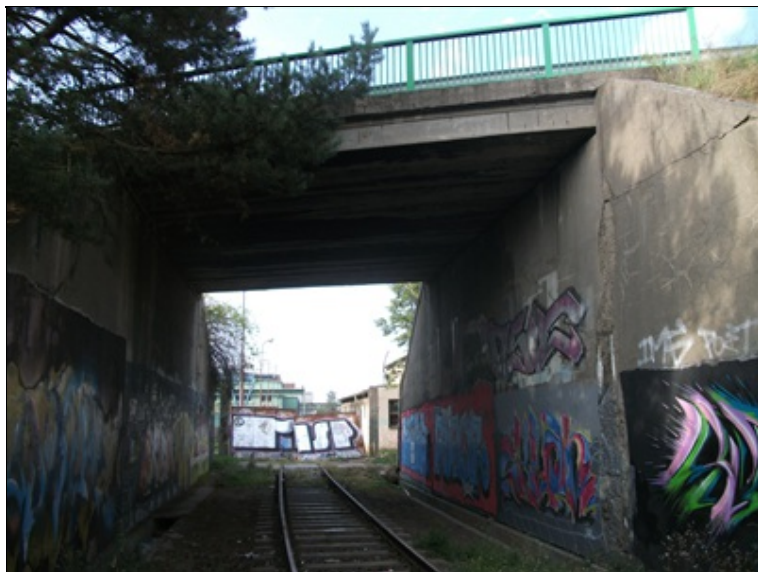
pohled na most zprava, tehliny a odpadlé části omítky
