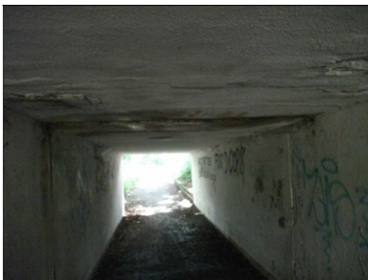
podhled mostu v místě dilatační spáry mezi mosty
