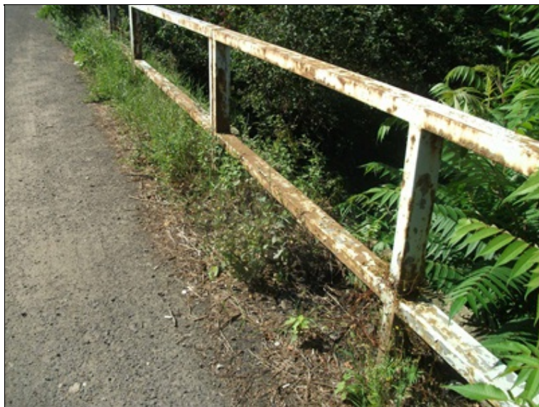
zábradlí na mostě, chybějící odrazný obručník před zábradlím
