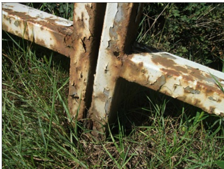
detail zábradlí, silná koroze, proreznutí sloupku v patě
