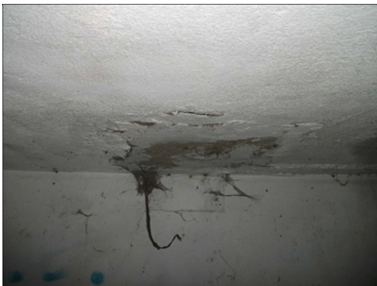
stpy protékání, odpadávající omítka
