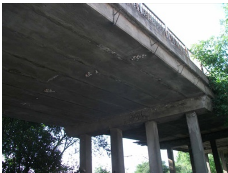
podhled pole 4, odhalená korodující výztuž pilíře P4
