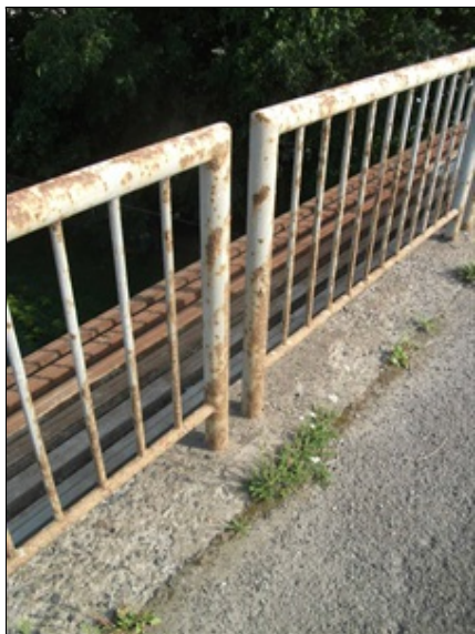
Levá strana mostu, silnější povrchová koroze zábradlí.
