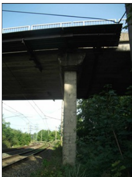
pohled na pilíř P3 zprava, prokreslená korodující výztuž stojky
