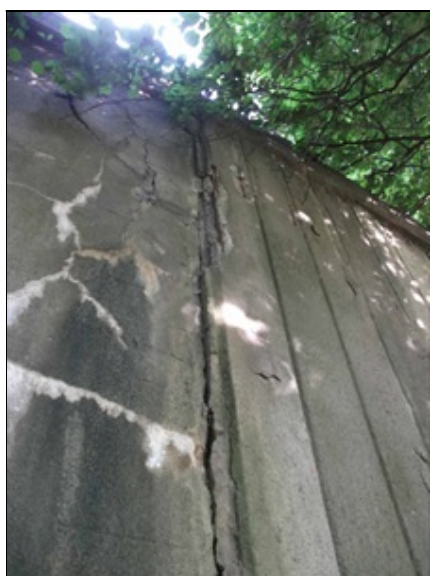
spára mezi pravým křídlem OP5 a navazující opěrnou zdí, odpadávající krycí vrstvy betonu, odhalená korodující výztuž
