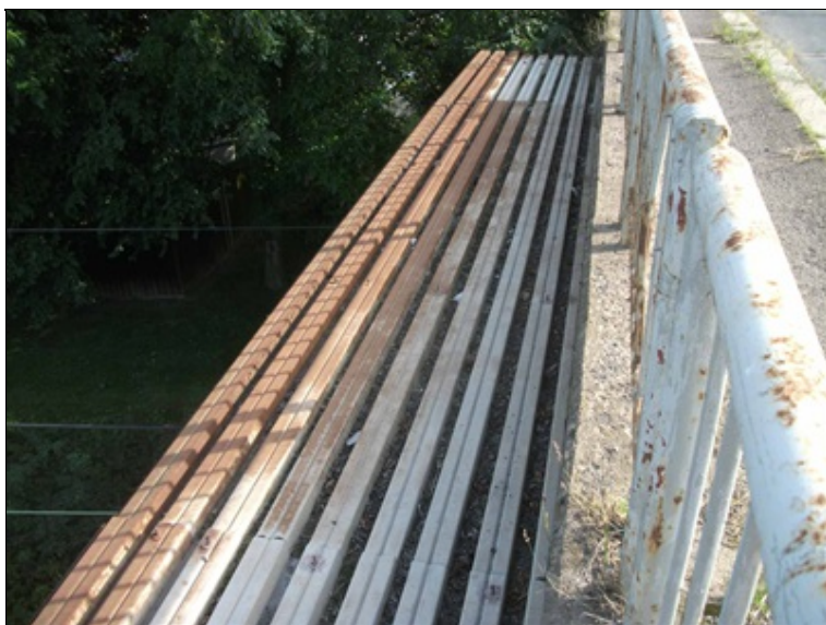
Horizontální protidotykové zábrany vlevo, povrchová koroze a nečistoty v profilaci krycího plechu.
