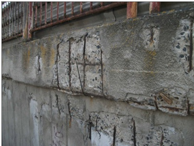
detail poruch opěrné zdi za OP5 vlevo
