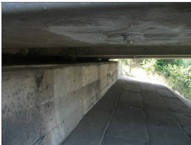
P3 - šikmá vzpěra, koroze výztuže, odtrhávání krycí vrstvy betonu
