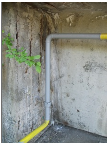
koncový příčník nad OP4, stopy po masivním zatékání, degradace betonu, koroze výztuže, plynovod na levém boku mostu
