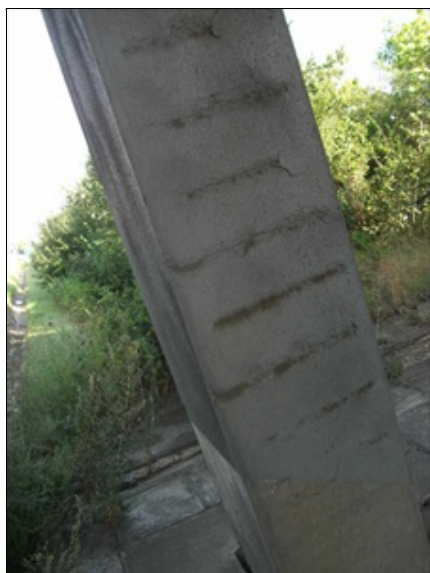
P3 - šikmá vzpěra, koroze výztuže, odtrhávání krycí vrstvy betonu
