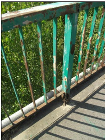
koroze zábradlí, v patě sloupku skoro 100%
