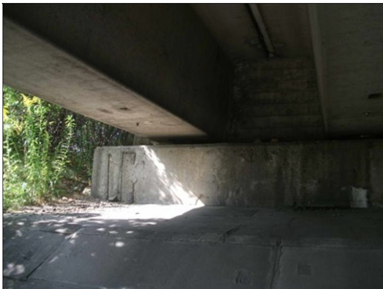
ukončení NK u OP1, stopy po masivním zatékání, odpadlá krycí vrstva betonu, koroze výztuže
