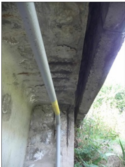
ukončení NK u OP1, stopy po masivním zatékání, odpadlá krycí vrstva betonu, koroze výztuže
