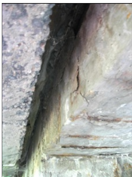
masivní zatékání pod římsou u OP4
