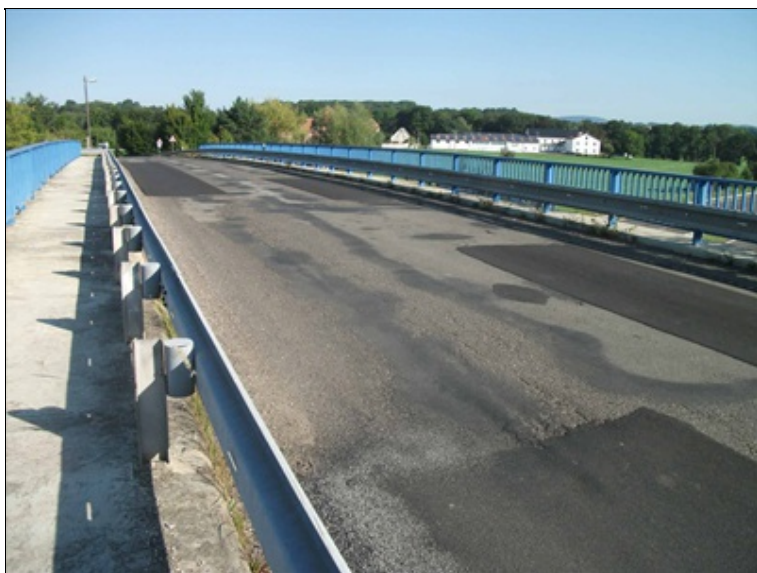
vozovka na mostě, poruchy a četné vysprávkky
