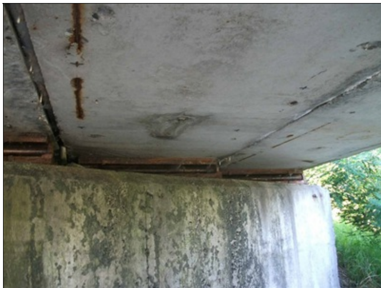
opěra OP1 zleva, odlomená část koncové dobetonávky NK
