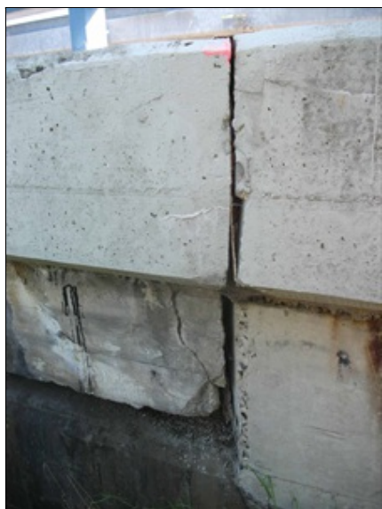
opěra OP1 zleva, odlomená část koncové dobetonávky NK
