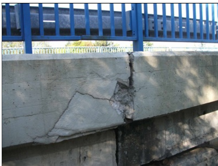
opěra OP1 vpravo, trhliny a destrukce betonu římsy - důsledek nepřiznané dilatační spáry
