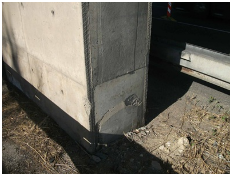
pilíř P3, odtržená povrchová vrstva betonu stojky
