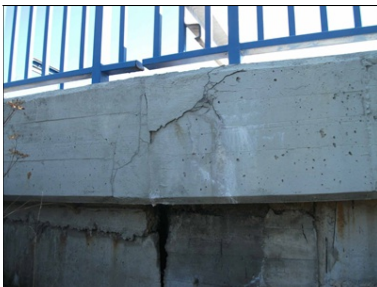
opěra OP5, podrcení římsy - důsledek nepřiznané dilatační spáry
