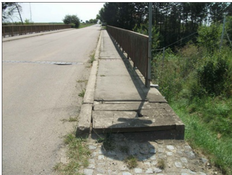
MZ nad OP1, trhliny a výtluk ve vozovce
