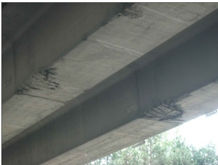
detail poškození dvou krajních nosníků vpravo
