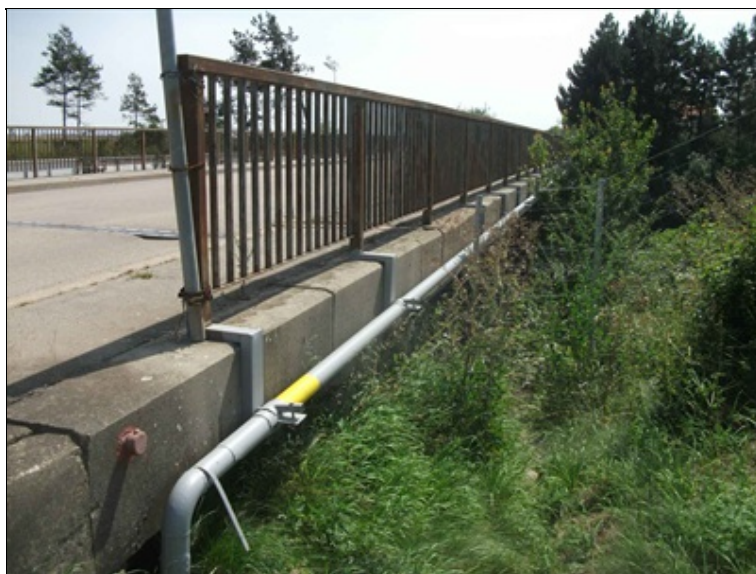
plynovod na pravém boku mostu
