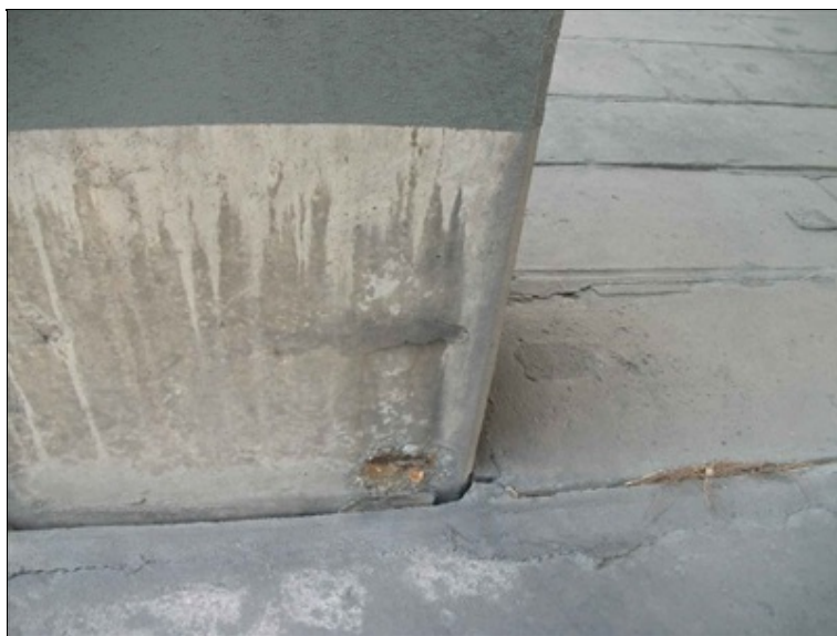
P3, šikmá stojka, odtržený krycí beton, odhalena korodující výztuž
