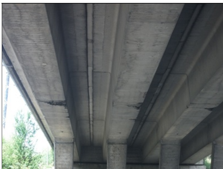
podhled středního pole, proti směru staničení, poškození nosníků od podjíždějícího vozidla
