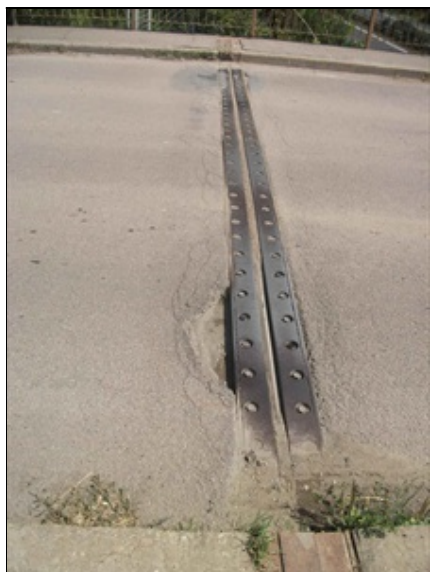
MZ nad OP1, trhliny a výtluk ve vozovce
