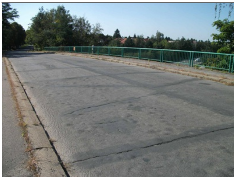
poruchy vozovky na mostě
