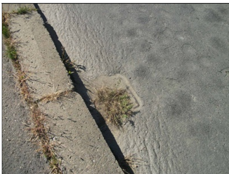
zanesený odvodňovač v 1. poli vpravo
