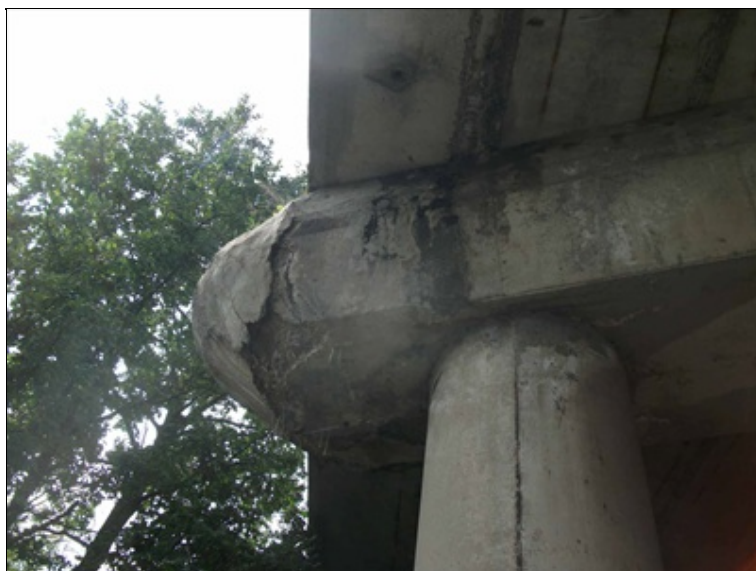
detail čela stativa pilíře P2, odpadávající sanace
