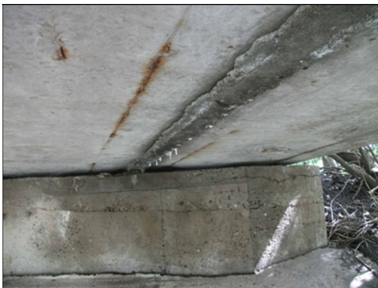
opěra OP5, pravá část, degradace betonu, trhliny v povrchu
