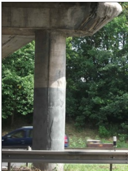
pilíř P3, trhliny ve sloupu
