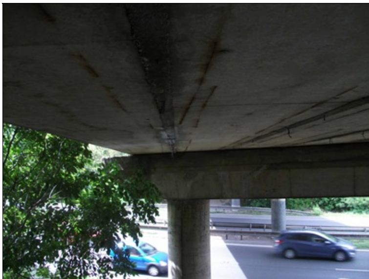
podhled NK, 4. pole vpravo, protékající krajní spára mezi nosníky
