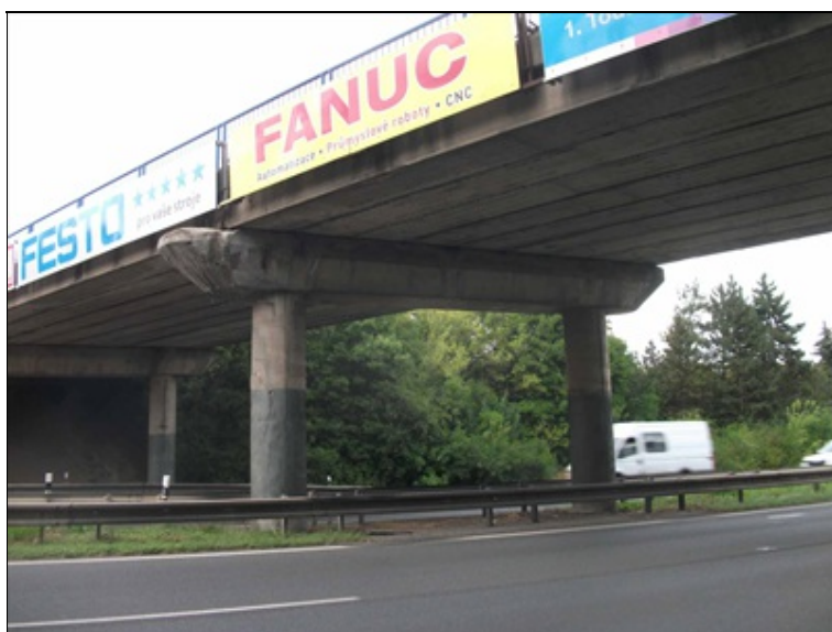
piulíř P3, zatékání na stativo, trhlina ve sloupu
