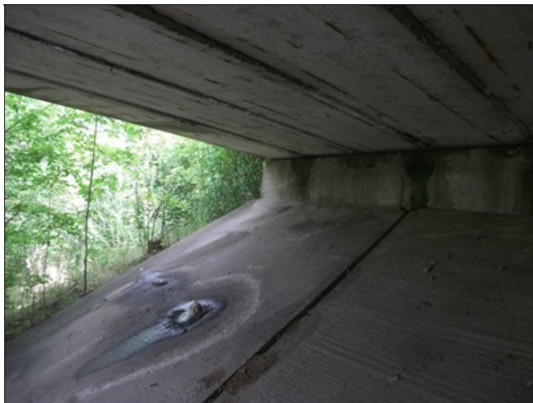
4. pole vlevo, protékající spára mezi nosníky
