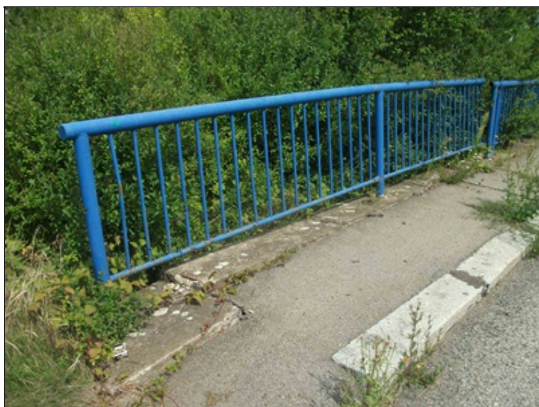
křídlo opěry OP1 vlevo, pokles a vyklonění samostatné koncové části křídla, vykloněné zábradlí
