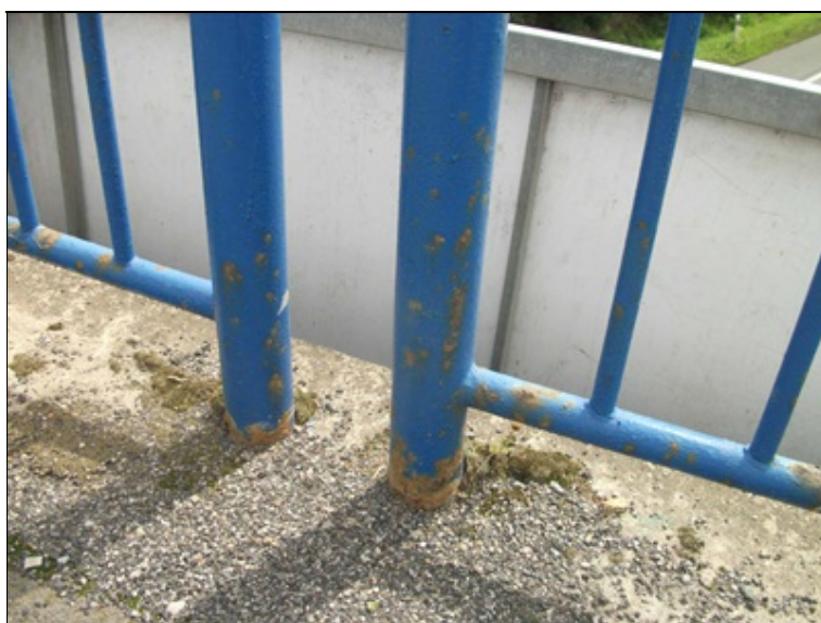
pravá strana mostu, silná koroze v patě sloupků zábradlí
