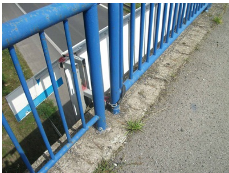
levá strana mostu, bodová povrchová koroze zábradlí, odhalená korodující výztuž říms
