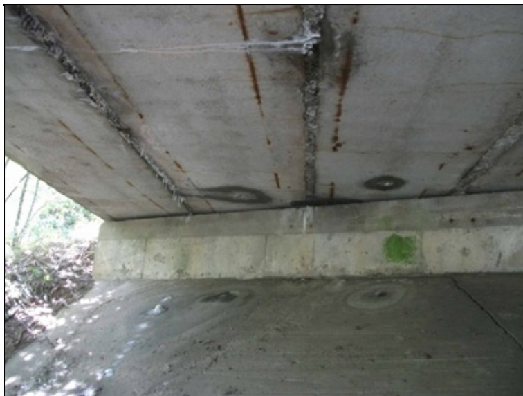
podhled NK v 1. poli vpravo, protékání spárami mezi nosníky, masivní vlhkost v okolí otvorů v nosnících
