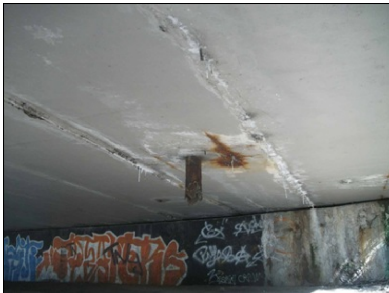
pole 4 vpravo, stopy po protékání mezi nosníky a vedle odvodňovačů, zrezlé odpadní potrubí odvodňovače
