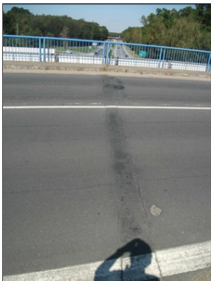
flexibilní mostní závěr nad pilířem P3
