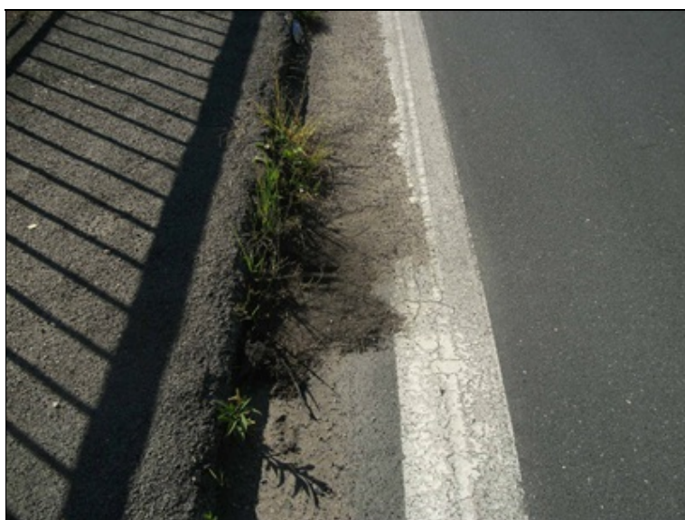
zanesený vtok odvodňovače, nečistoty a vegetace u obrubníku
