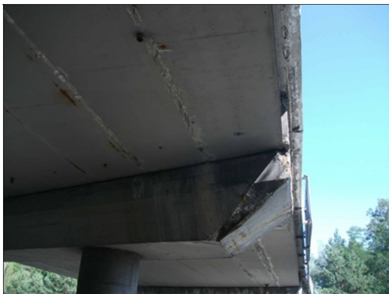
pilíř P2, pravé čelo stativa, korodující obnažená výztuž, protékající spáry mezi nosníky
