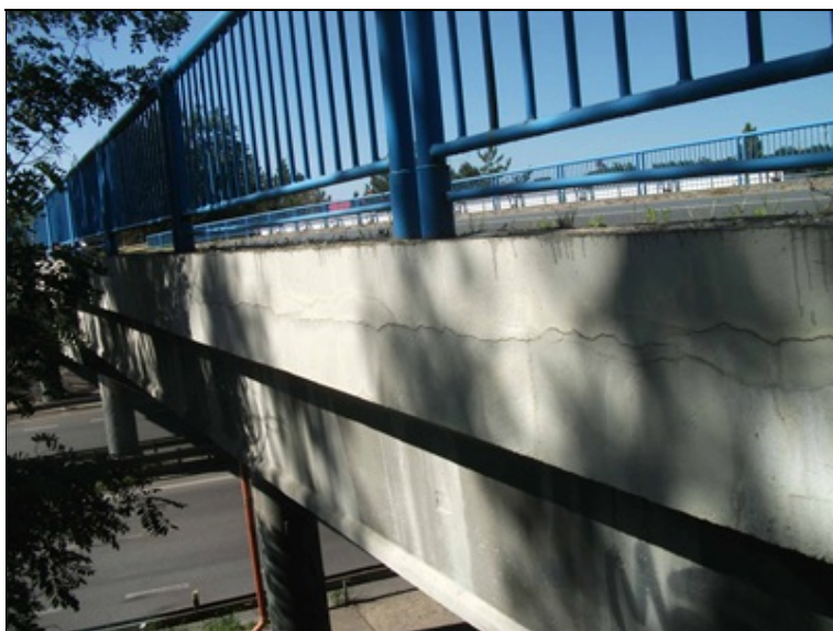
pravá římsa, trhliny v sanaci římsy
