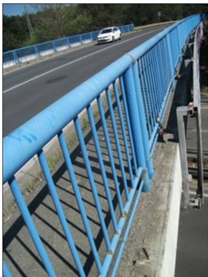
pravá strana mostu, lokální koroze zábradlí
