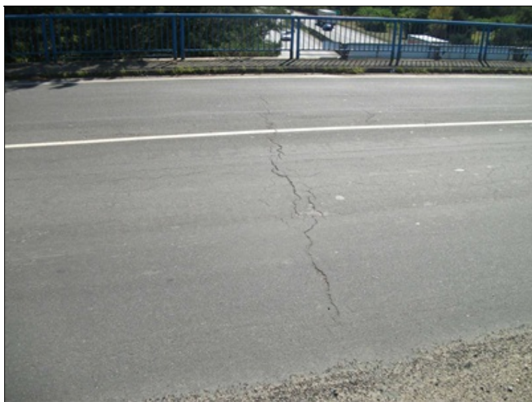
trhliny ve vozovce nad pilířem P4
