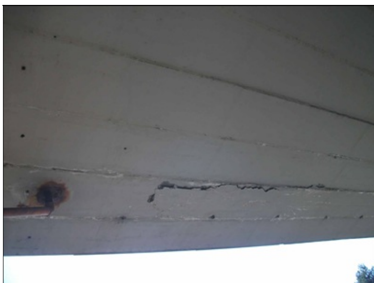
pole 3, separace sanační vrstvy v pohledu NK
