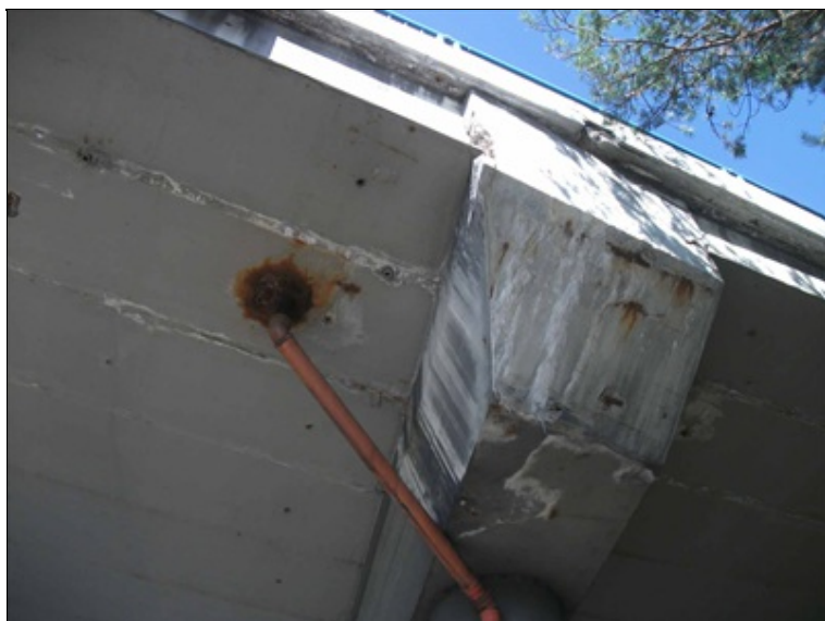
pilíř P4 vpravo, prokreslená korodující výztuž, zrezlé odpadní potrubí odvodňovače, výluhy koroze v okolí, protékání NK ve spárách mezi nosníky
