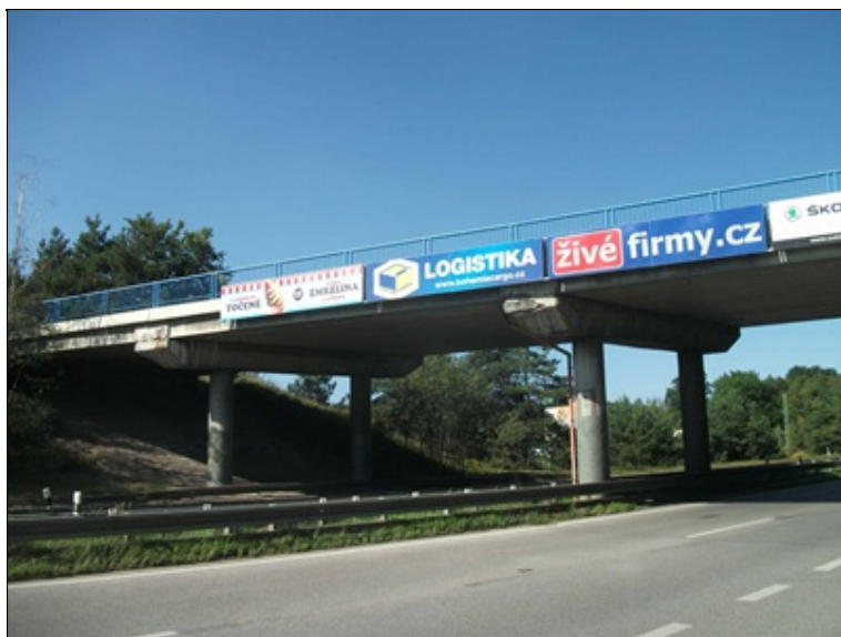
pohled na most zprava, prokreslená korodující výztuž na čelech stativ, stopy po zatékání na čela stativ
