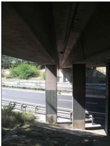
chybějící svod odvodňovače u pilíře P3
