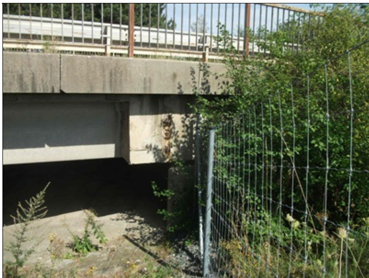
OP4, obnažené kotvy příčného předpětí
