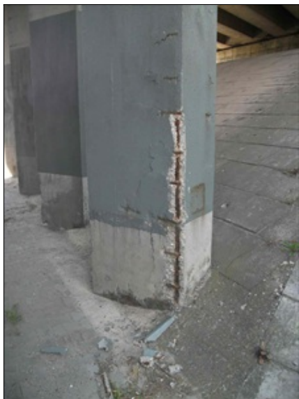
pilíř P2, odpadlá povrchová vrstva betonu, koroze výztuže
