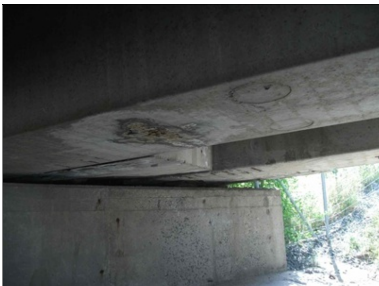
stopy po průsacích na spodku nosníku v okolí odvodňovacího otvoru
