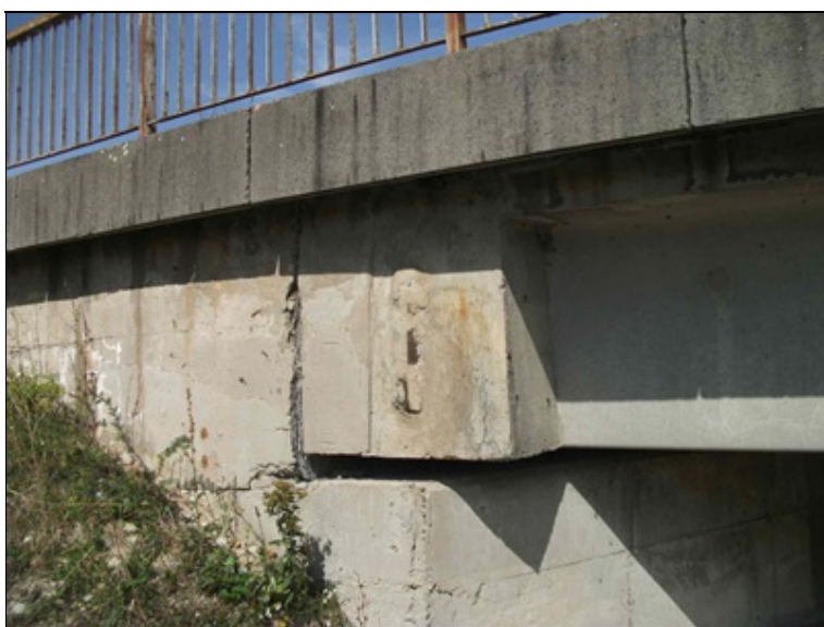
obnažené kotvy příčného předpětí koncového příčniku nad OP1
