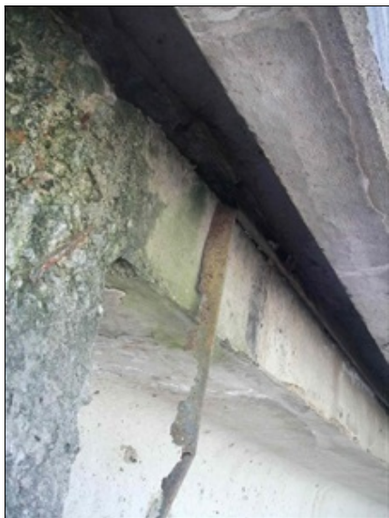
NK u OP4, odpadlý korodující okapní plech
