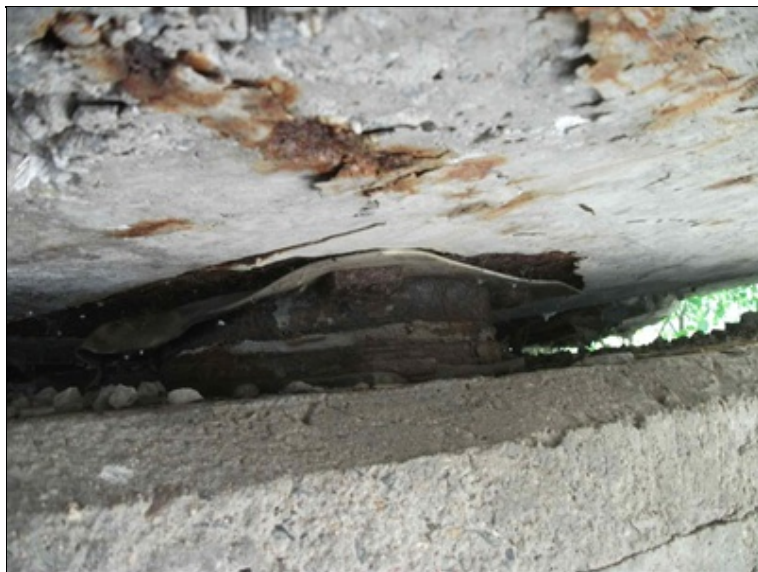
OP4 detail koroze ložiska
