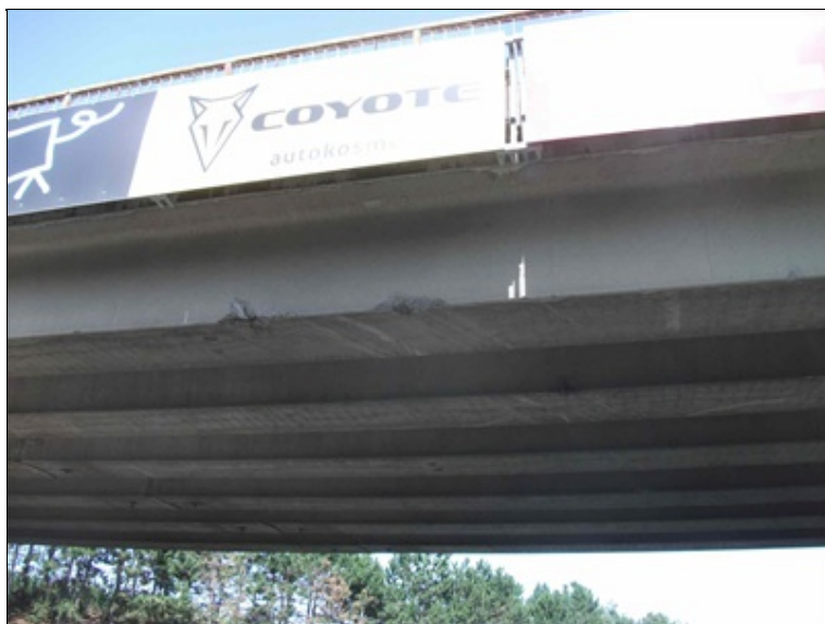
pilíř P3, odpadlá povrchová vrstva betonu stojky, koroze výztuže
