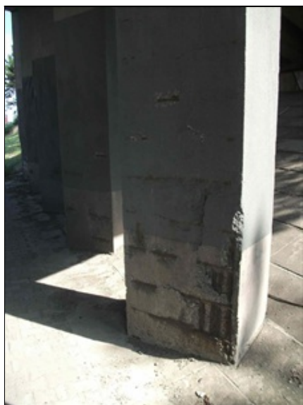
pilíř P3, odpadlá povrchová vrstva betonu stojky, koroze výztuže
