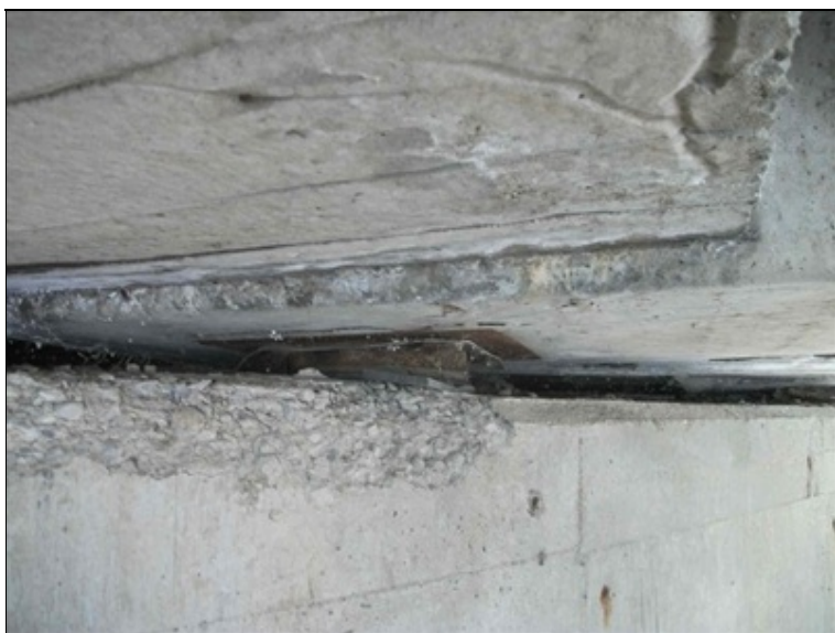
OP4, korodující ložisko, odražená hrana úložného prahu opěry
