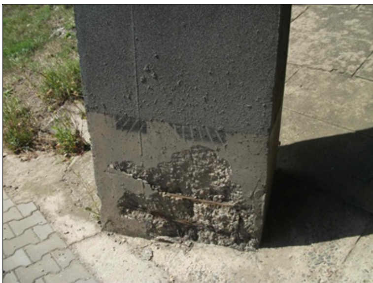
pilíř P2, odpadlá povrchová vrstva betonu, koroze výztuže
